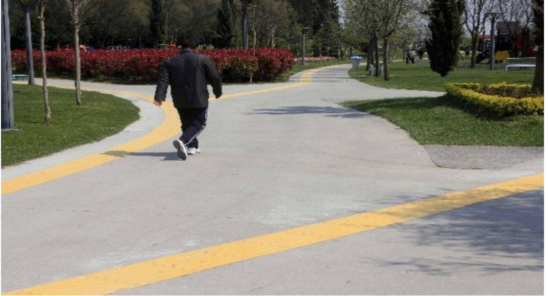
Şekil 12. Rekreasyon Alanında Kılavuz Döşeme Örneği (URL3, 2015).
