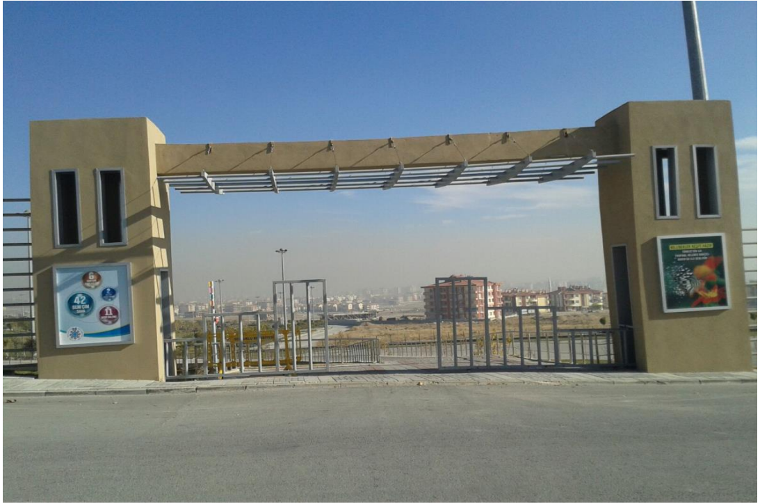
Şekil 6. Kelebekler Vadisi Parkının Batı Girişi (E. Kaya, 2015)
