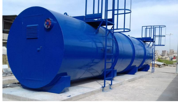
Görsel 41: Proses Atık Su Arıtma Tesisi Revizyonu, 2021
