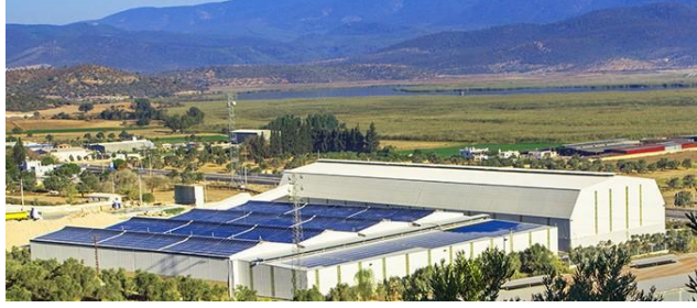
Görsel 39: Güllük Enerji Santrali Esan Seramik,
