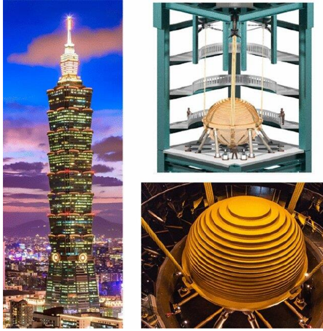
Şekil 1.9. Taipei Tower binası ve sarkaç biçimindeki DTS, Chen ve ark, (2023)'ten uyarlanmıştır.
