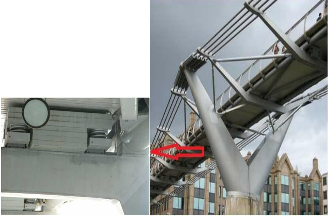
Şekil 1.10. Millenium Köprüsü ve köprü altında kullanılan DTS'ler, Maraveas ve ark, (2015)'ten uyarlanmıştır.
