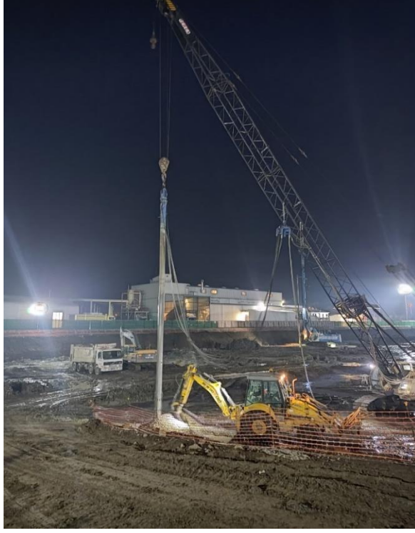
Şekil 2.2. Düzce Çilimli’de granüler malzeme ile taş kolon imalatı.
