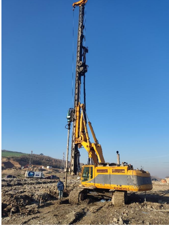
Şekil 2.5. İstanbul'da yapılan kesişen DSM imalatı delgi işlemi.
