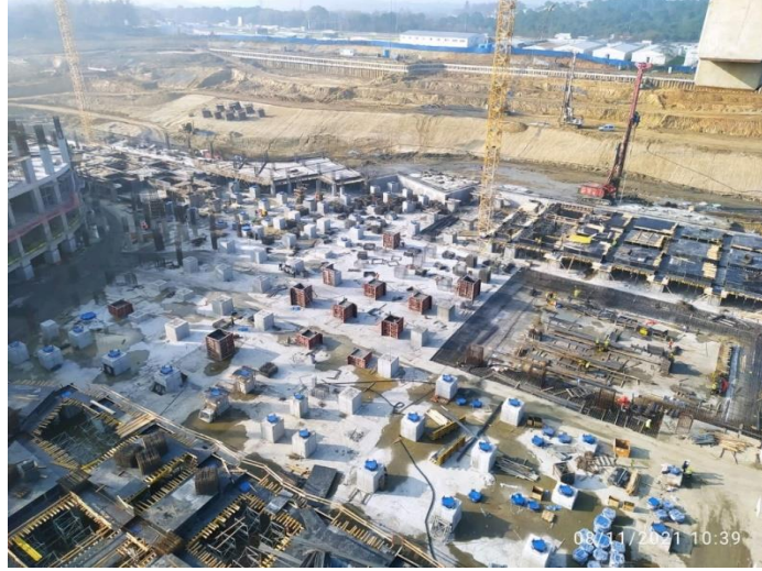
Şekil 3.7. DSM ile zemin iyileştirilmesi yapılan alanlarda yapı inşası.
