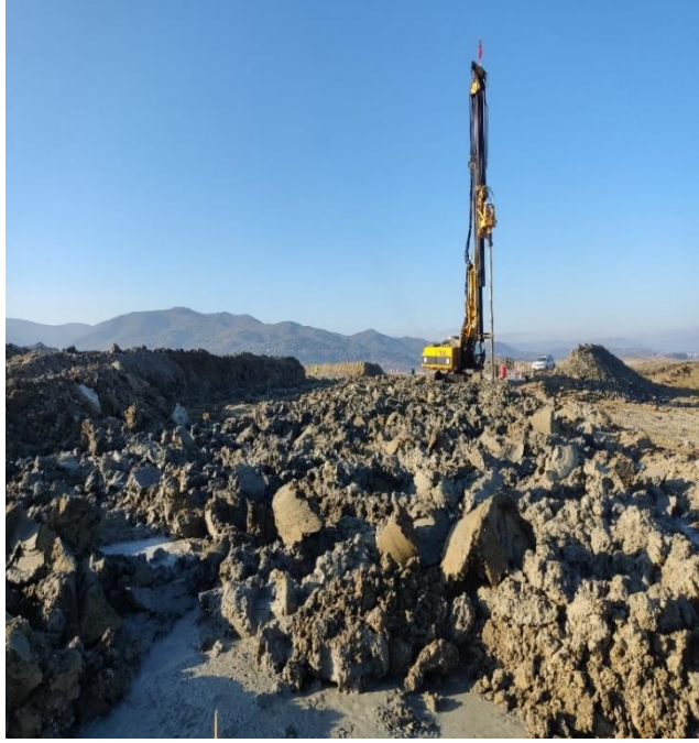
Şekil 2.6. Yalova ili DSM imalatı uygulaması.
