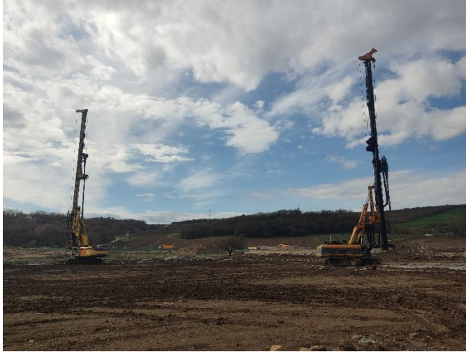
Şekil 3.4. DSM makinesi saha pozisyonu alma ve etkin kullanılması.
