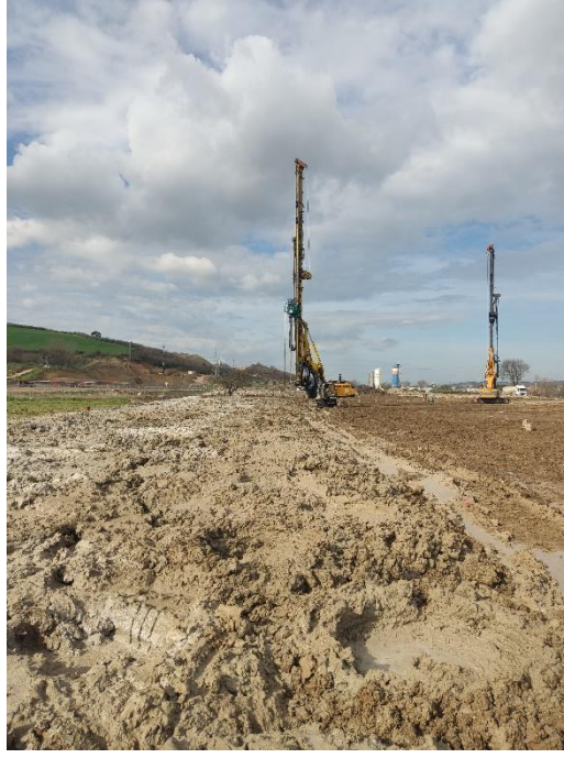
Şekil 3.3. DSM makinesi saha pozisyonu alma ve etkin kullanılması.
