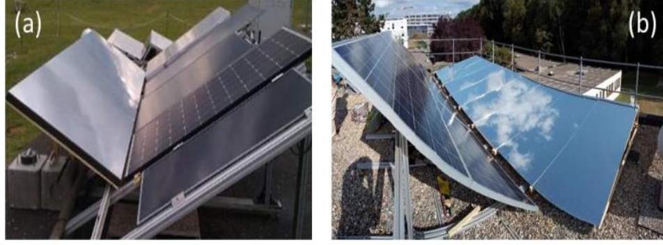
Şekil 3.13. Düz yansıtıcı(a) ; Fresnel yansıtıcı(b).
