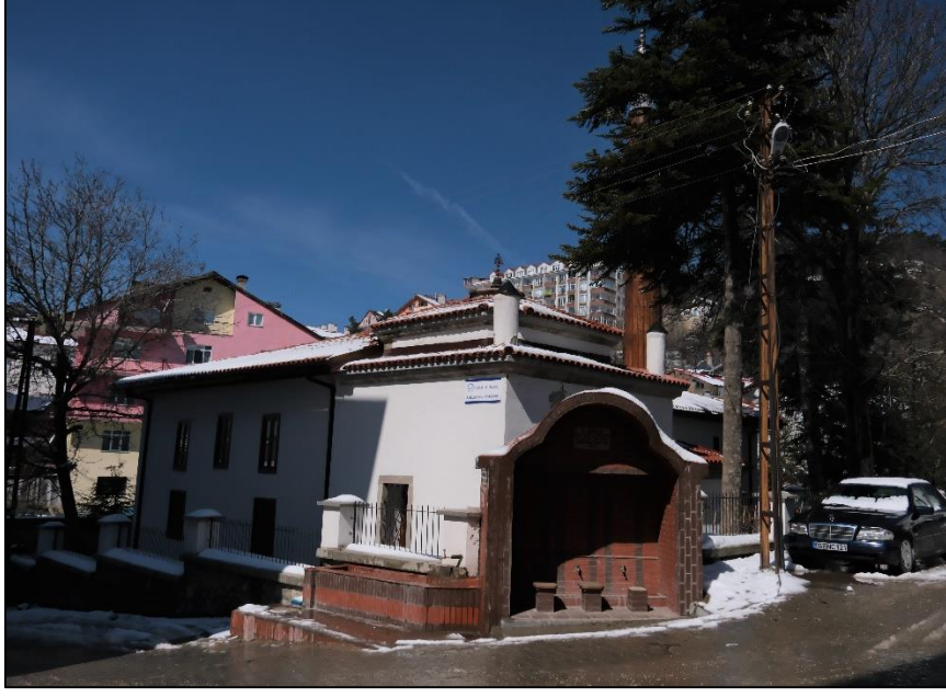
Fotoğraf 231: Caminin Güney Doğu Köşesinden Görünüm
