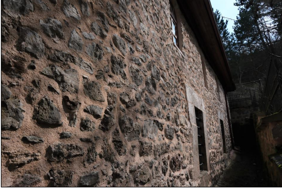
Fotoğraf 383: Doğu Cephesinden Görünüm
