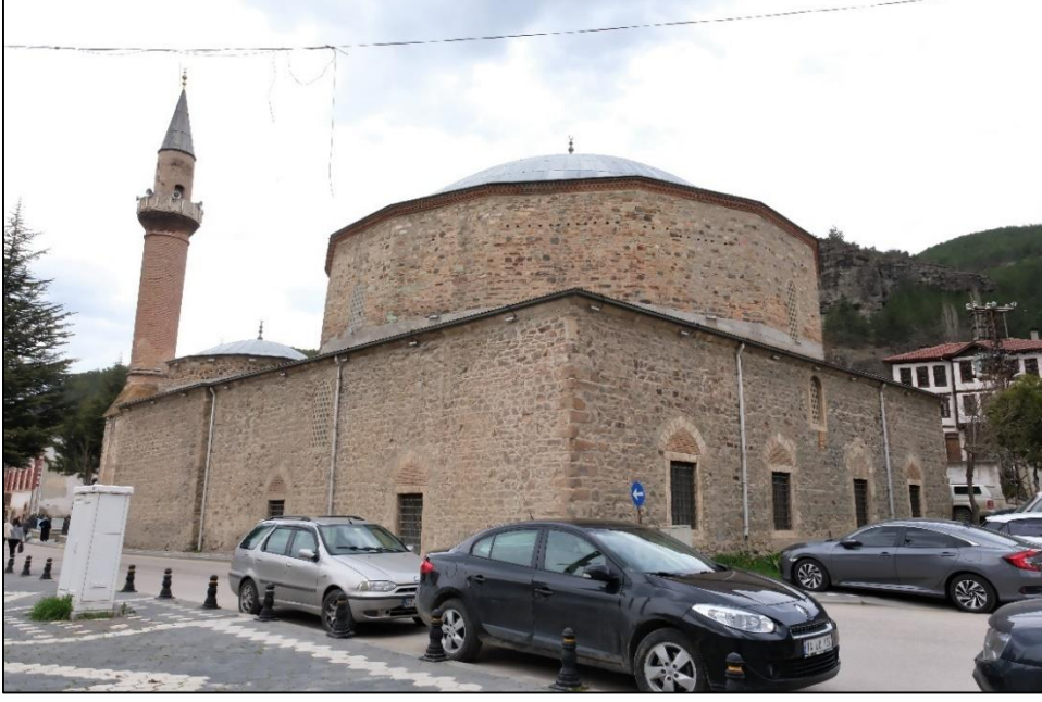
Fotoğraf 317: Yapının Batı Cephesi
