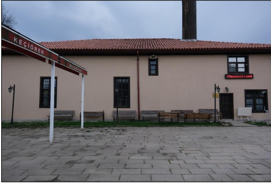
Fotoğraf 269: Doğu Cephesi
