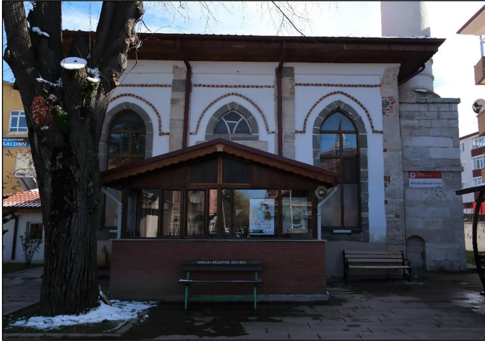
Fotoğraf 395: Caminin Kuzey Cephesinden Görünüm
