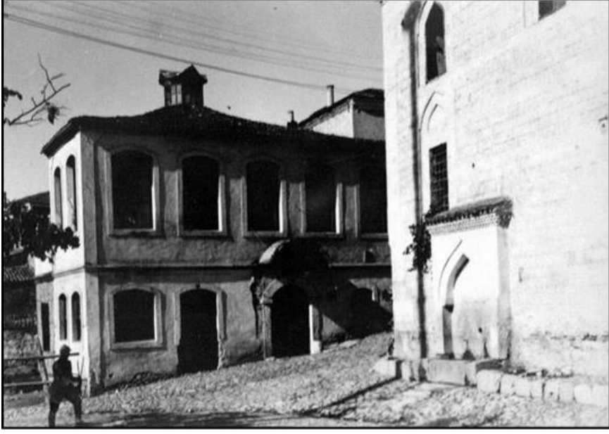
Fotoğraf 132: Saraçhane Camii'nin Güney Batı Cephesindeki Sivri Kemerli Çeşme. (1928)
