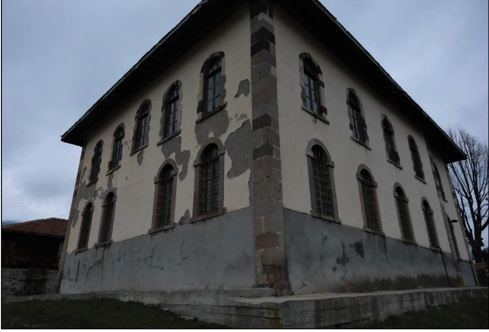
Fotoğraf 241: Yapının Güney ve Doğu Cephelerinden Görünüm
