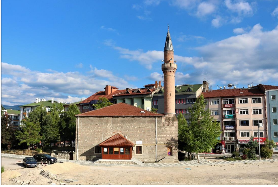
Fotoğraf 120: Yapının Kuzey Cephesinden Görünüm
