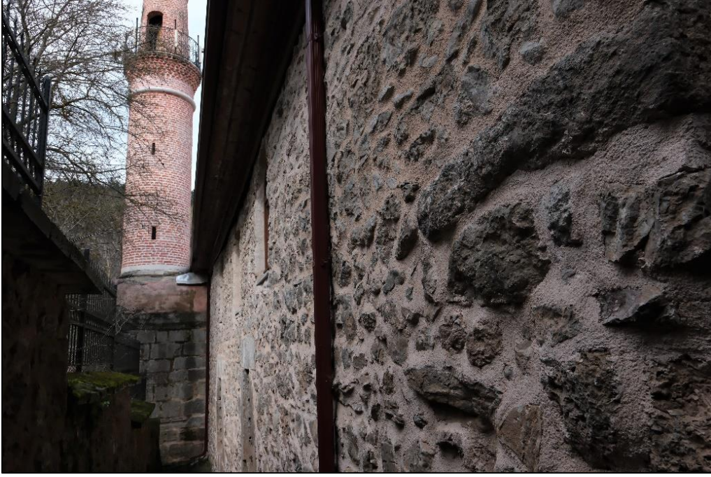
Fotoğraf 385: Batı Cephesinden Görünüm
