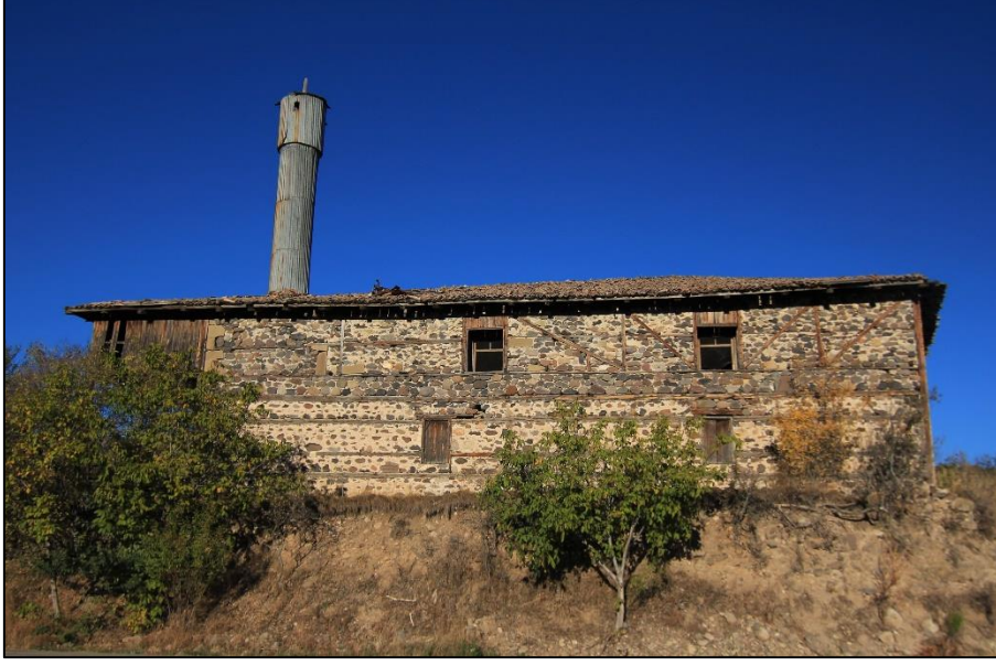
Fotoğraf 373: Caminin Batı Cephesi
