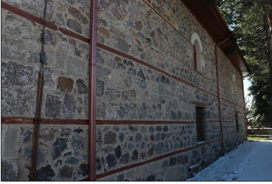
Fotoğraf 203: Kuzey Cepheden Görünüm
