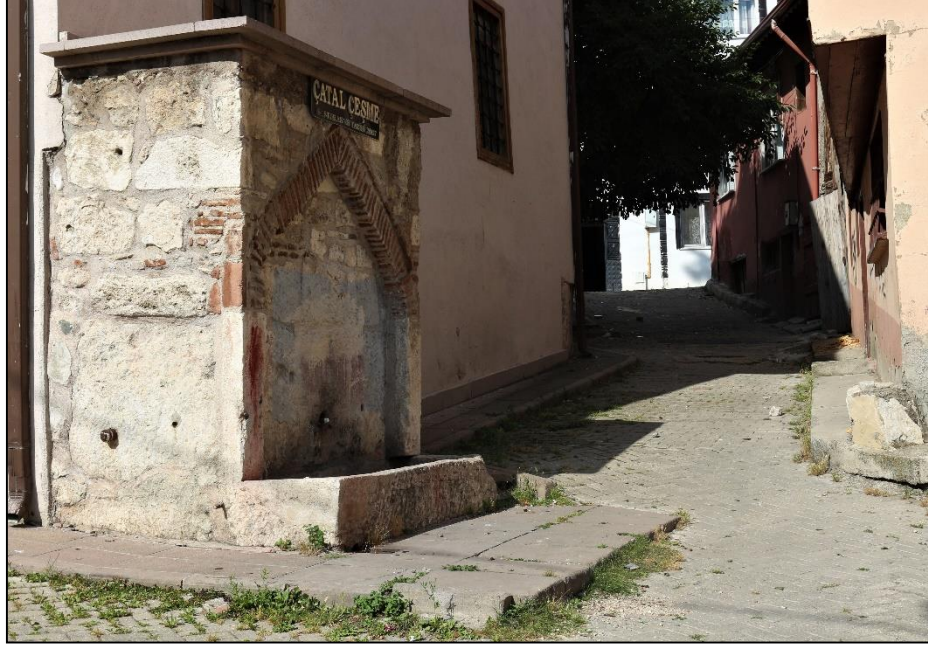
Fotoğraf 174: Yapının Güney Batı Cephesinde Bulunan Bağımlı Çeşmesi
