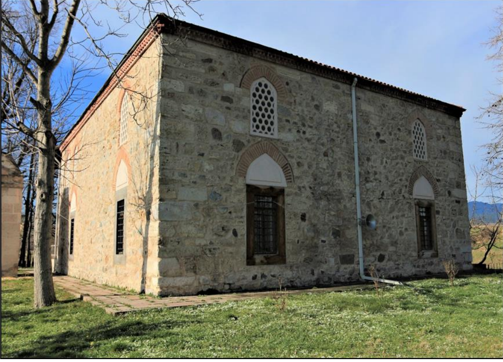
Fotoğraf 106: Karaköy Camii'nin Batı ve Güney Cephesi
