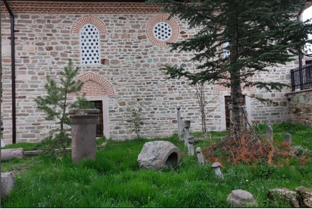
Fotoğraf 327: Yapının Güney Cephesi ve Güney Cephesinde Bulunan Haziresi
