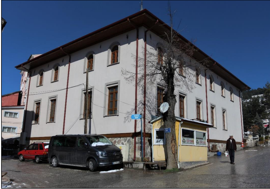
Fotoğraf 218: Yapının Doğu ve Güney Cephelerinden Görünüm
