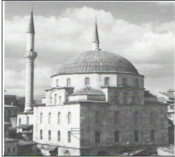
Fotoğraf 33: 1963’lü Yıllarda Tek Minare Yıkılmış ve Yerine İlk Minarelerin Üslubuna Yakın Minareler Eklenmiştir
