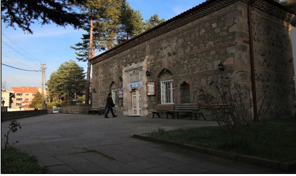
Fotoğraf 69: Yapının Giriş Cephesi
