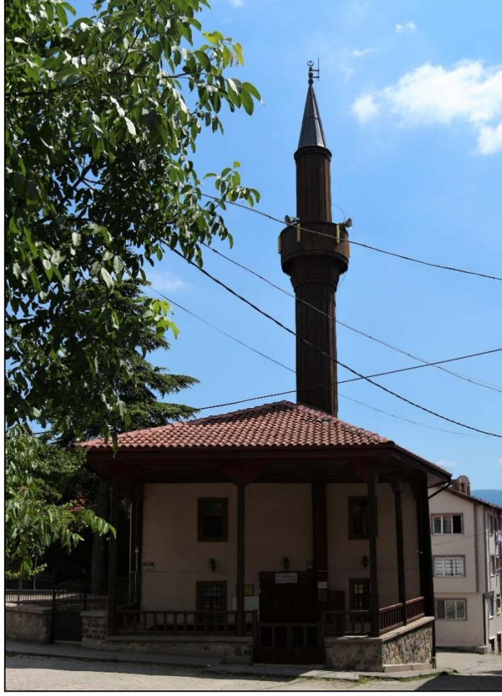
Fotoğraf 172: Yapının Kuzey Cephesinden Genel Görünüm
