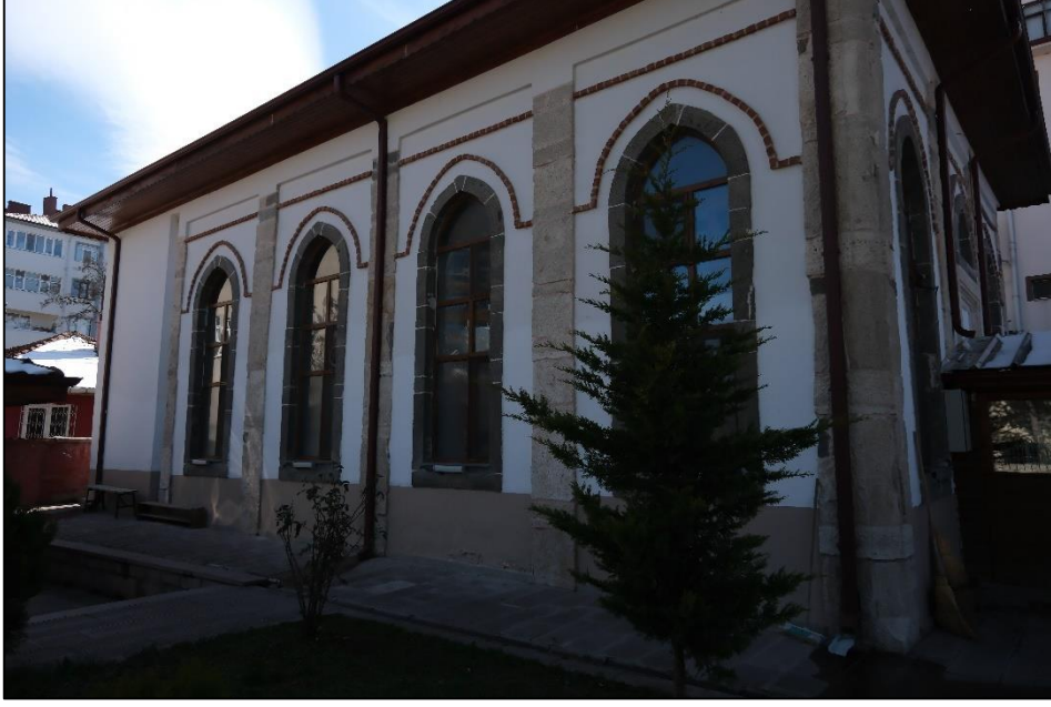
Fotoğraf 396: Doğu Cephesinden Görünüm
