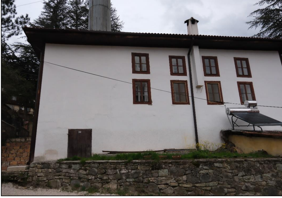
Fotoğraf 343: Caminin Batı Cephesi
