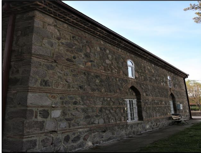
Fotoğraf 70: Yapının Güney Cephesi
