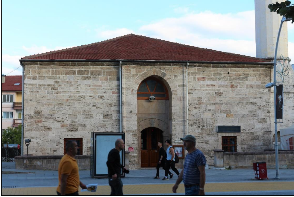
Fotoğraf 91: Kadı Camii'nin Kuzey Cephesi
