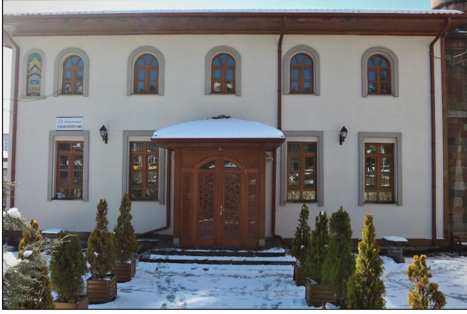
Fotoğraf 217: Yapının Kuzey Cephe Görünümü
