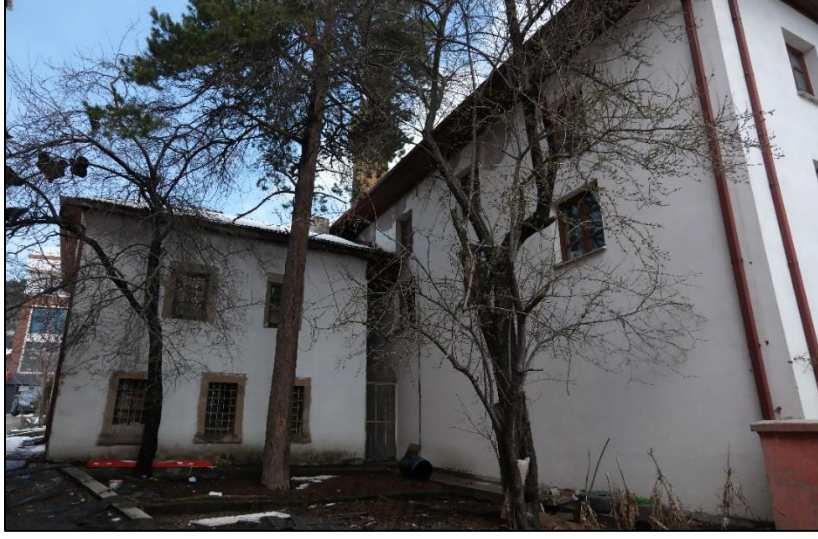
Fotoğraf 251: Yapının Batı Cephesi ile Kütüphanesi
