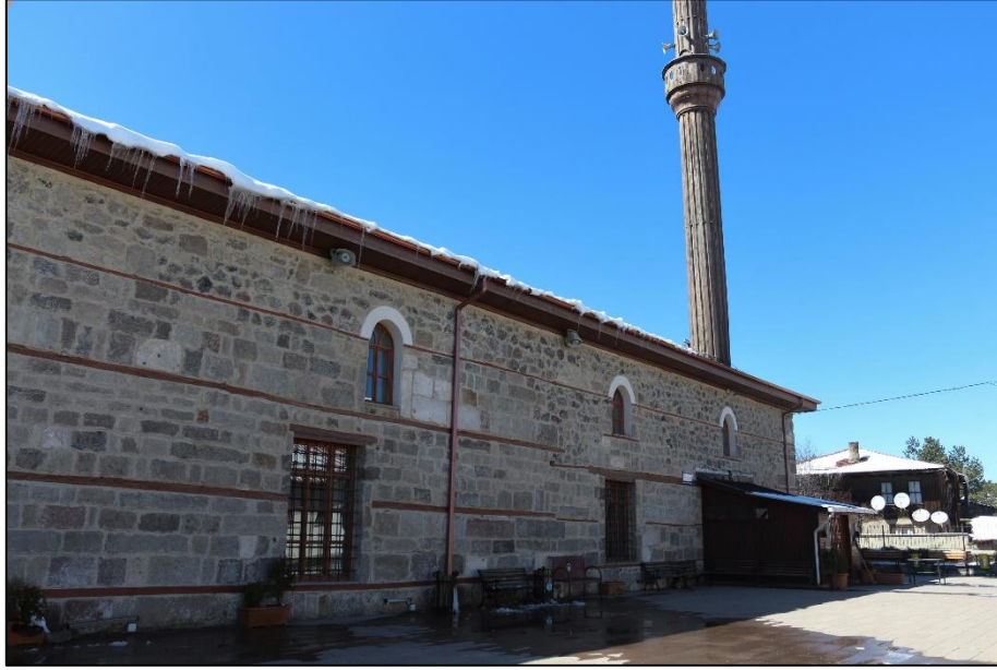
Fotoğraf 202: Camiye Girişin Sağlandığı Doğu Cepheden Görünüm
