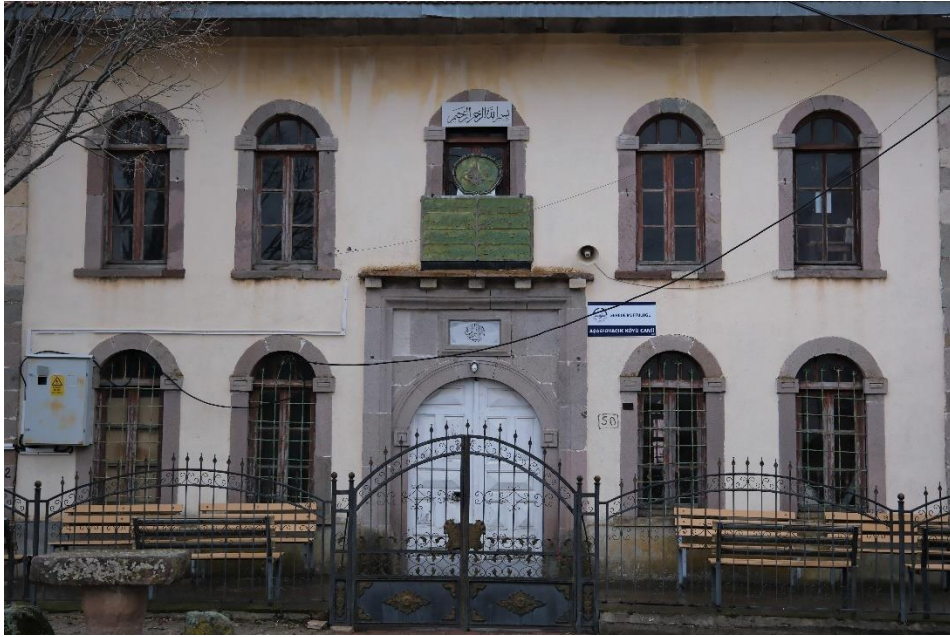
Fotoğraf 240: Yapının Kuzey Cephe Görünümü
