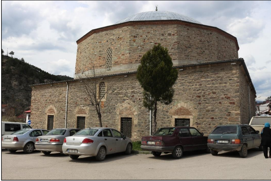
Fotoğraf 318: Yapının Güney Cephesi
