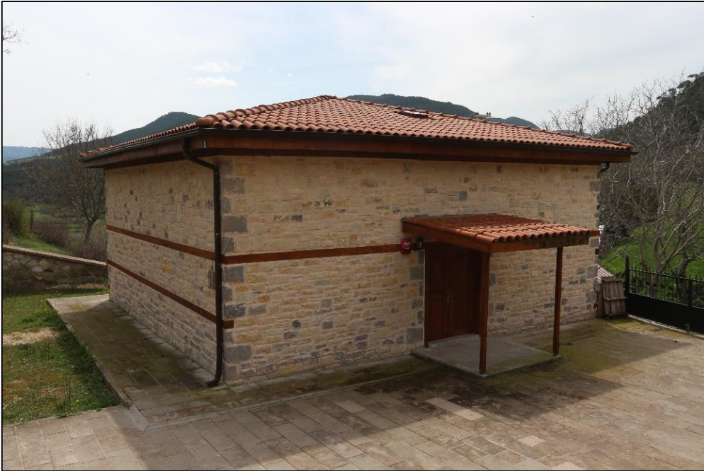
Fotoğraf 305: Caminin Kuzey Cephesi
