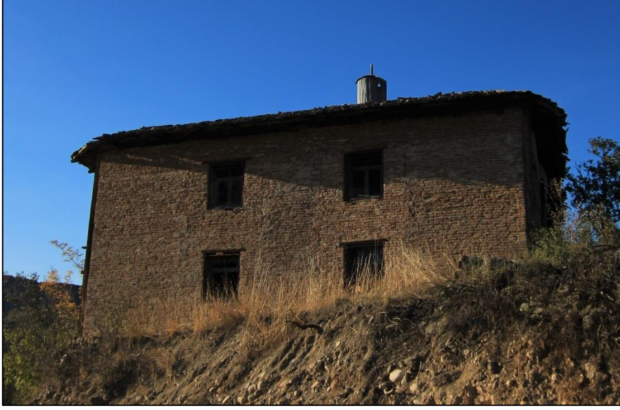
Fotoğraf 375: Yapının Güney Cephesi
