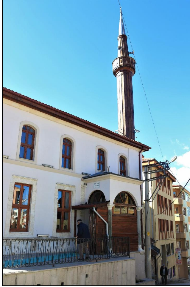
Fotoğraf 182: Yapının Kuzey Doğuda Yer Alan Girişi ve Minaresi
