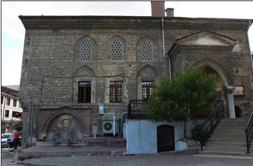
Fotoğraf 140: Yapıya Girişin de Yer Aldığı Doğu Cephesi
