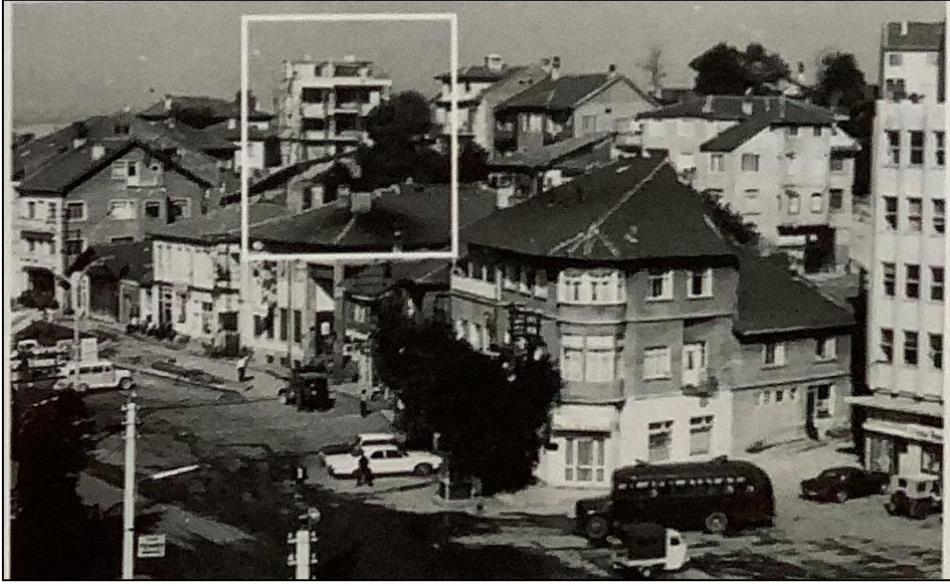
Fotoğraf 407: 1944 Depreminden Sonra Yıkılan Mescidin Yerine İnşa Edilen Apartmanın, 1944 Yılı Sonrası
