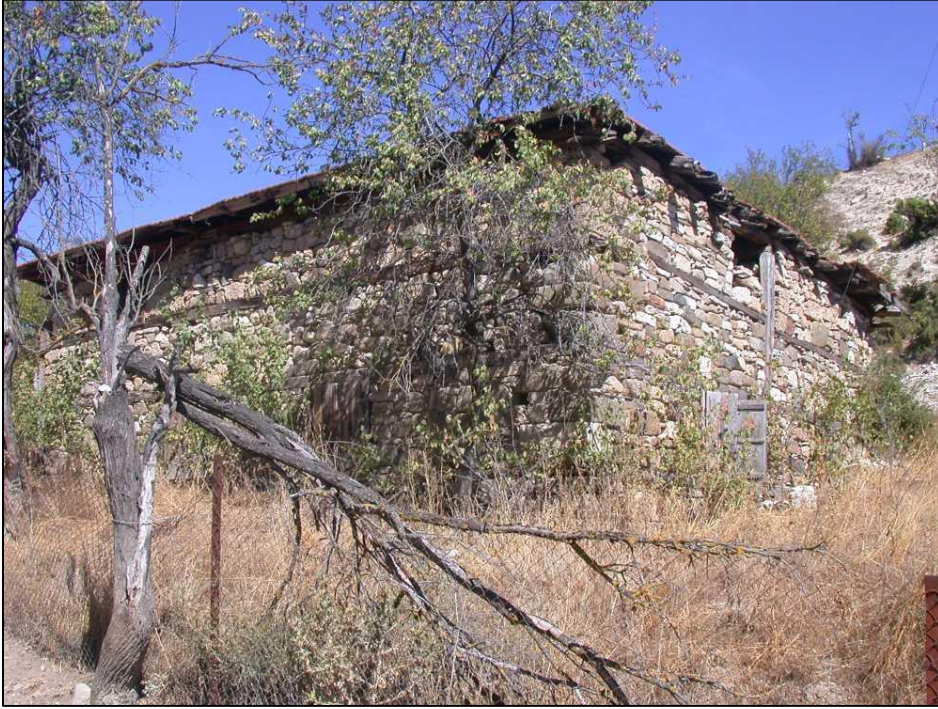
Fotoğraf 302: Yapının Restorasyon Öncesi Güney Batı Cephelerinin Görünümü
