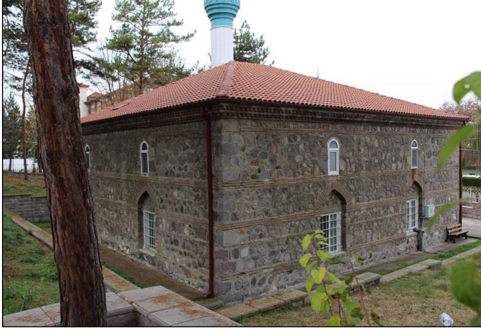
Fotoğraf 71: Ilıca Musa Paşa Camii'nin Güney ve Doğu Cephesi
