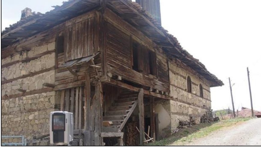
Fotoğraf 351: Kuzey Batı Cephesinden Yapıya Giriş Sağlanan Ahşap Merdiven Sistemi
