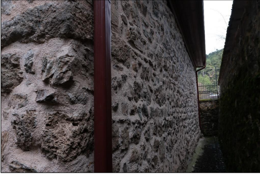
Fotoğraf 384: Güney Cephesinden Görünüm
