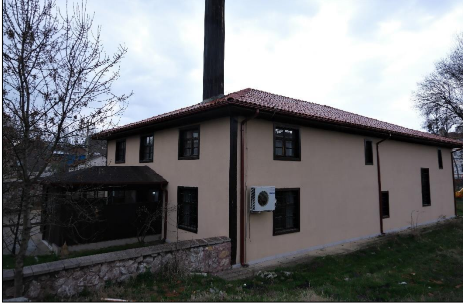
Fotoğraf 270: Kuzey Batı Cephe Görünümü
