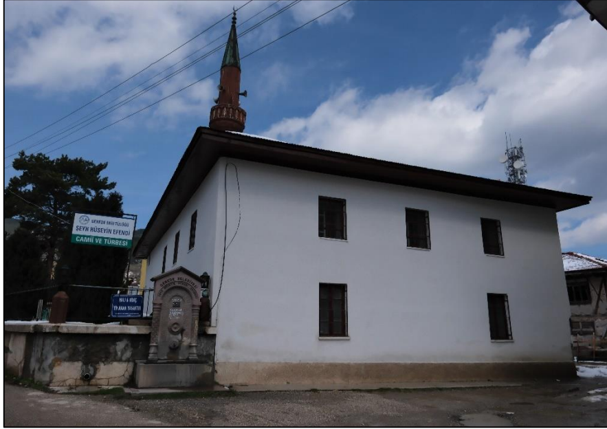
Fotoğraf 259: Caminin Güney Cephesinden Görünüm
