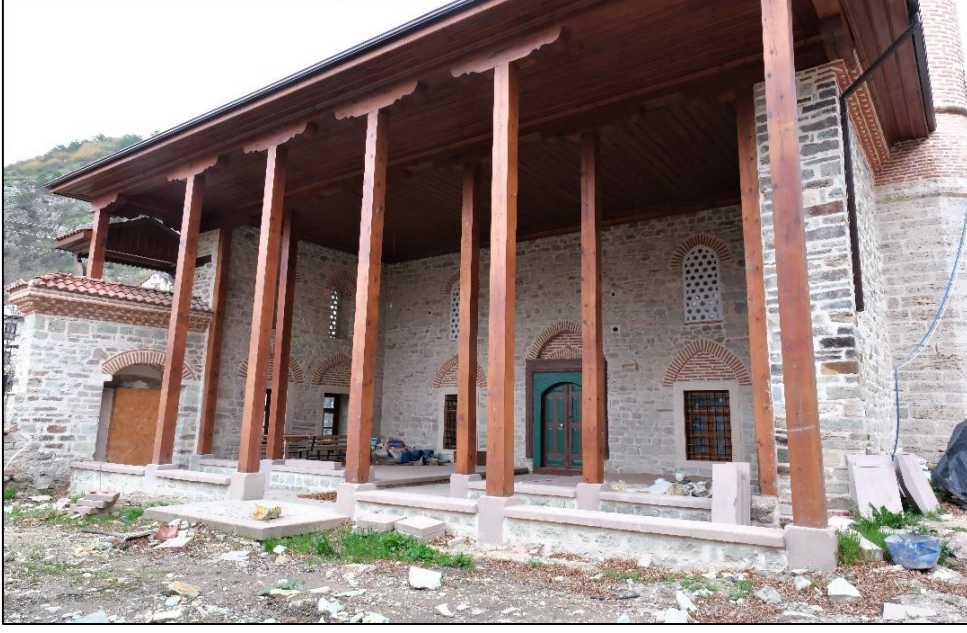
Fotoğraf 326: Yapının Son Cemaat Yerinden Görünümü
