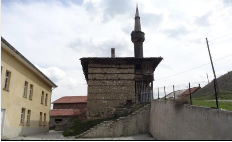
Fotoğraf 352: Yapının Kuzey Cephesi
