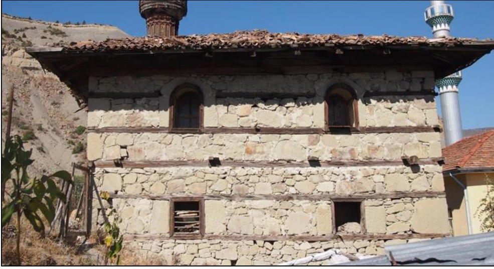
Fotoğraf 354: Yapının Güney Cephesi
