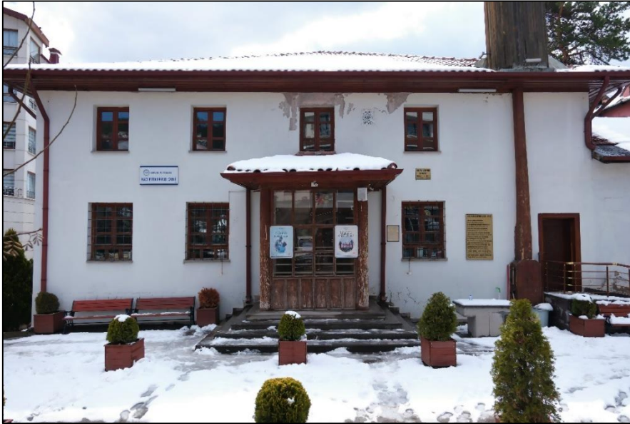
Fotoğraf 250: Caminin Kuzey Cephesi
