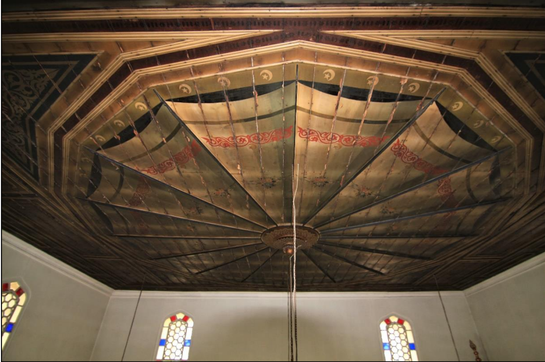
Fotoğraf 128: Yapının Ahşap Tavanından Görünüm
