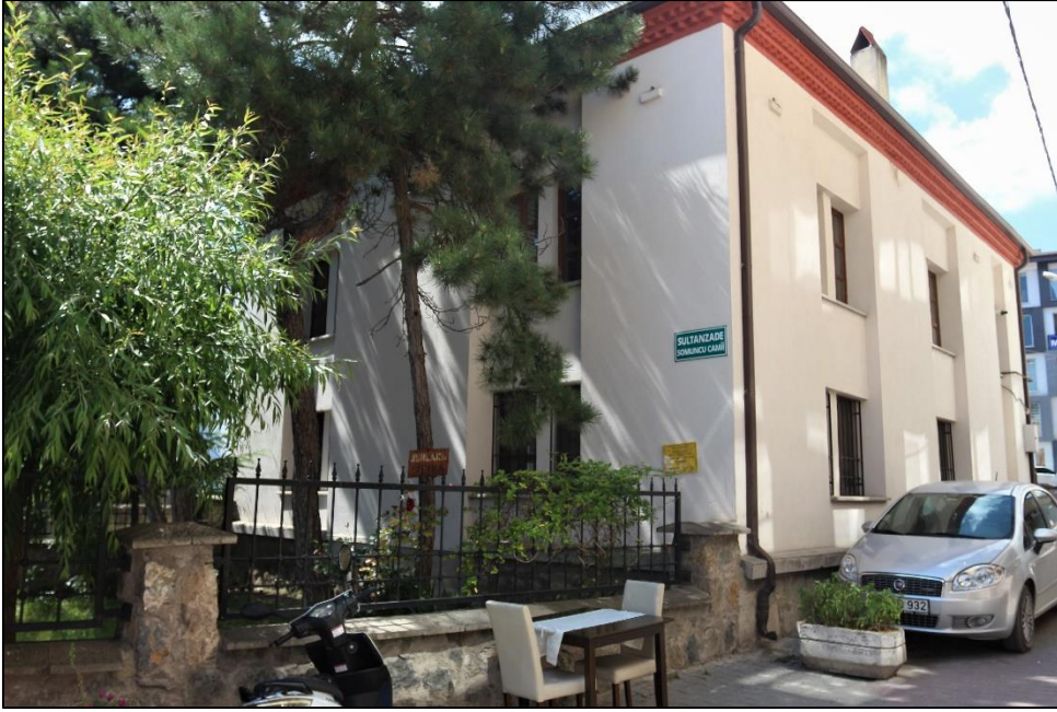
Fotoğraf 187: Yapının Güney ve Doğu Cephesinden Görünüm
