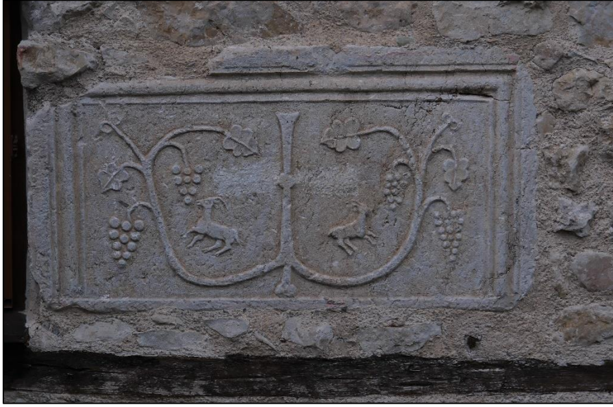
Fotoğraf 291: Yapının Batı Cephesindeki Devşirme Malzemedeki Detay
