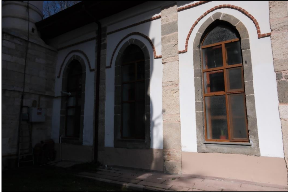
Fotoğraf 397: Batı Cephesinden Görünüm
