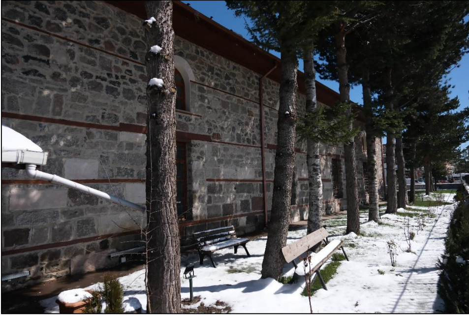
Fotoğraf 204: Batı Cepheden Görünüm
