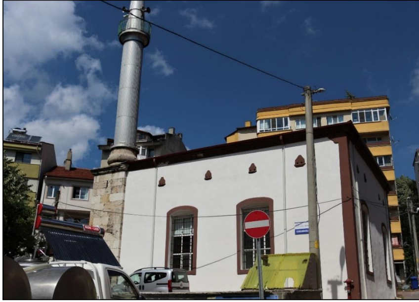
Fotoğraf 156: Yapının Batı Cephesi
