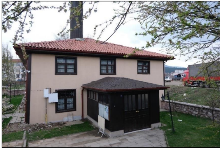
Fotoğraf 267: Yapıya Girişin Sağlandığı Kuzey Cephe
