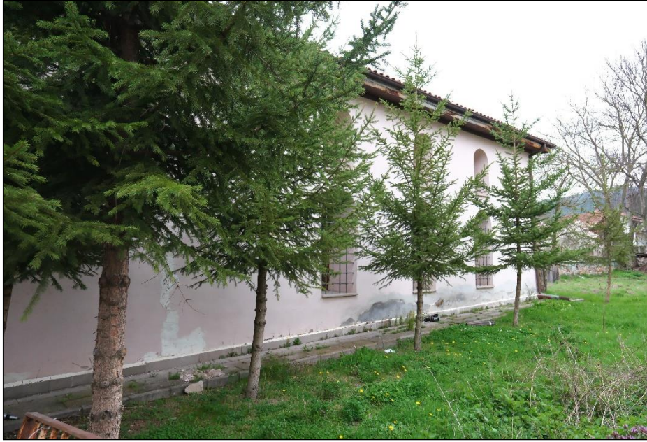
Fotoğraf 335: Caminin Batı Cephesi
