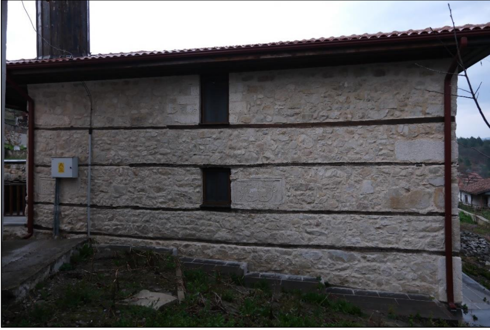
Fotoğraf 282: Yapının Batı Cephe Duvarı
