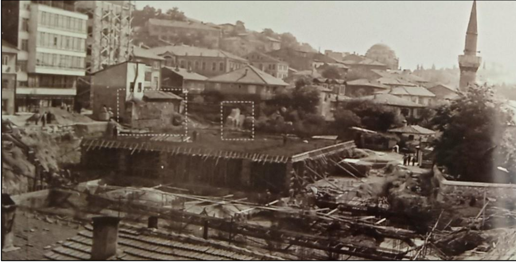
Fotoğraf 118: 1973 Yılında Başlayan Katlı Otopark İnşaatının Görünümü. İşaretli Noktalar İmaret Kalıntıları
