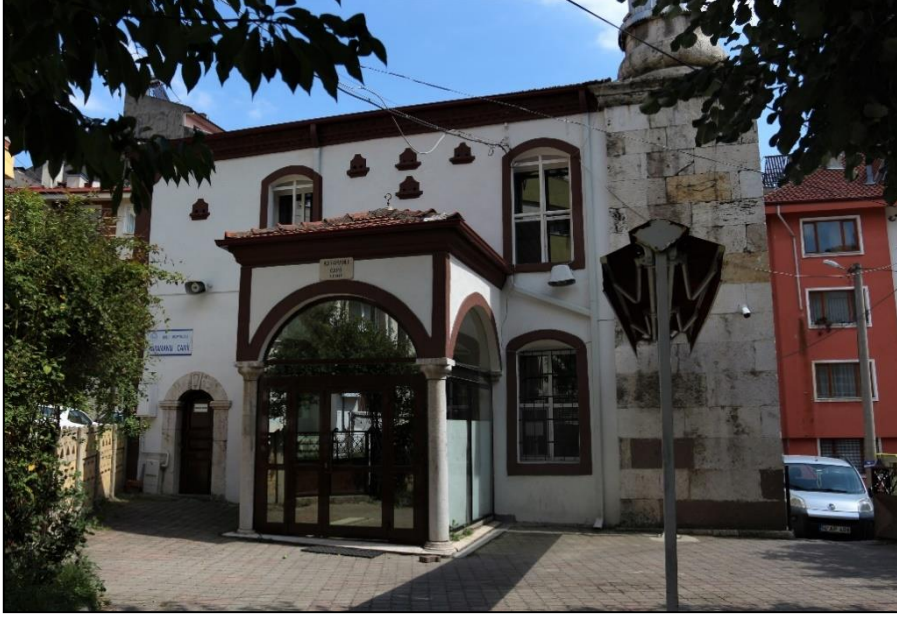
Fotoğraf 155: Yapının Kuzey Cephe Görünümü
