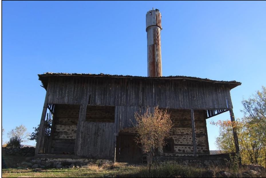
Fotoğraf 372: Caminin Kuzey Cephesi
