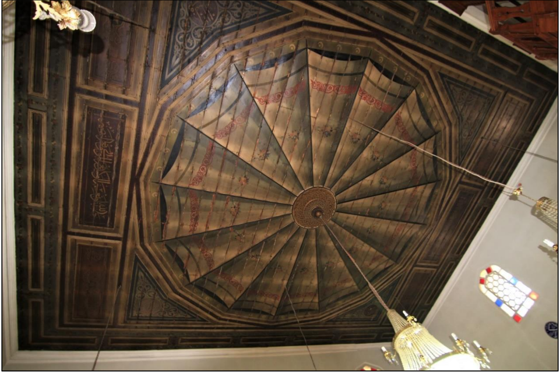
Fotoğraf 127: Yapının Ahşap Tavanından Görünüm
