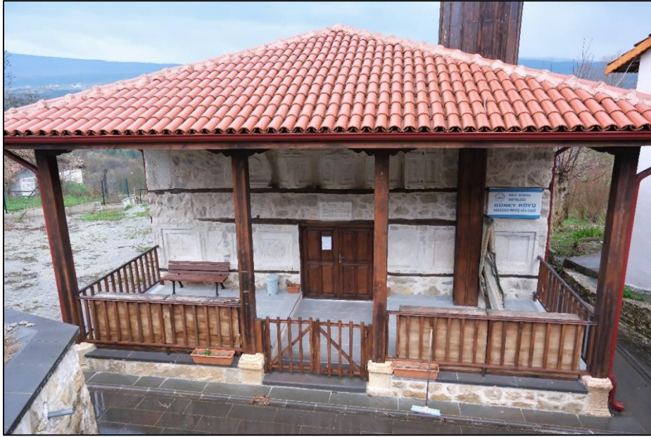
Fotoğraf 279: Yapının Kuzey Cephesi
