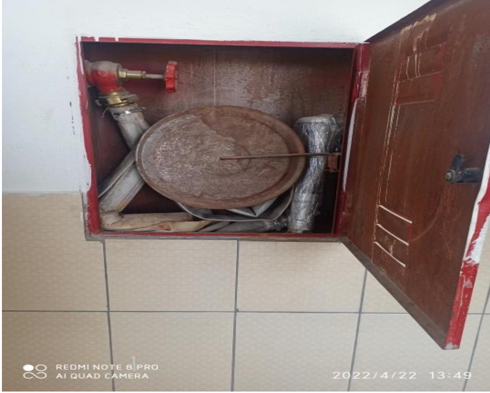
Şekil 4.5. Yangın sisteminin aktif olmaması.
