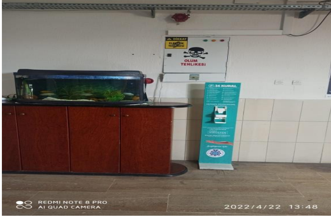
Şekil 4.3. Elektrik pano önlerinin engellenmesi.
