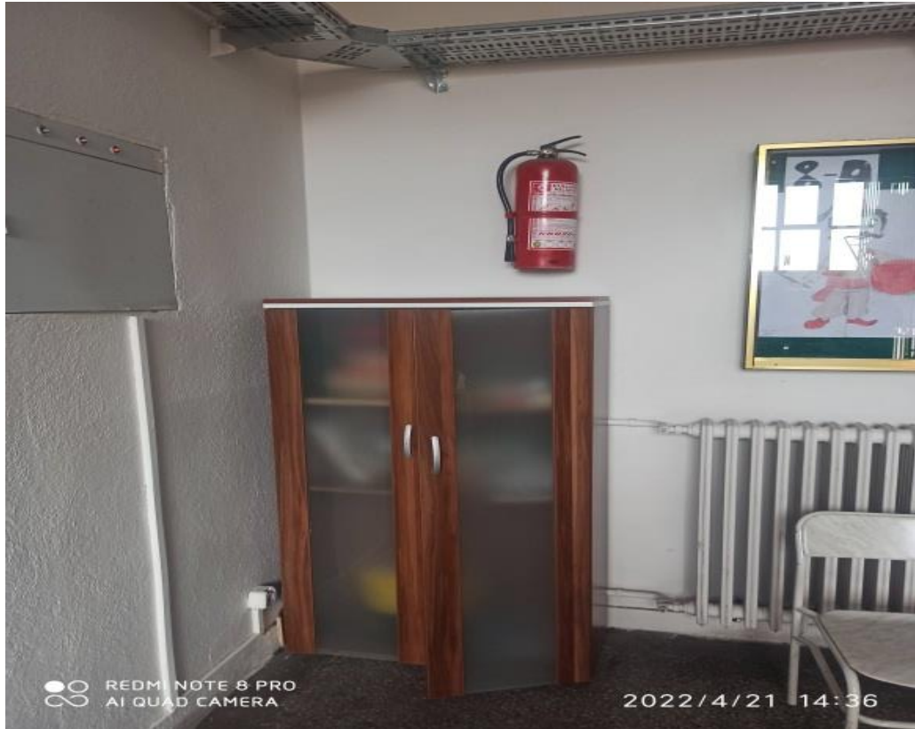
Şekil 4.3. Elektrik pano önlerinin engellenmesi.
