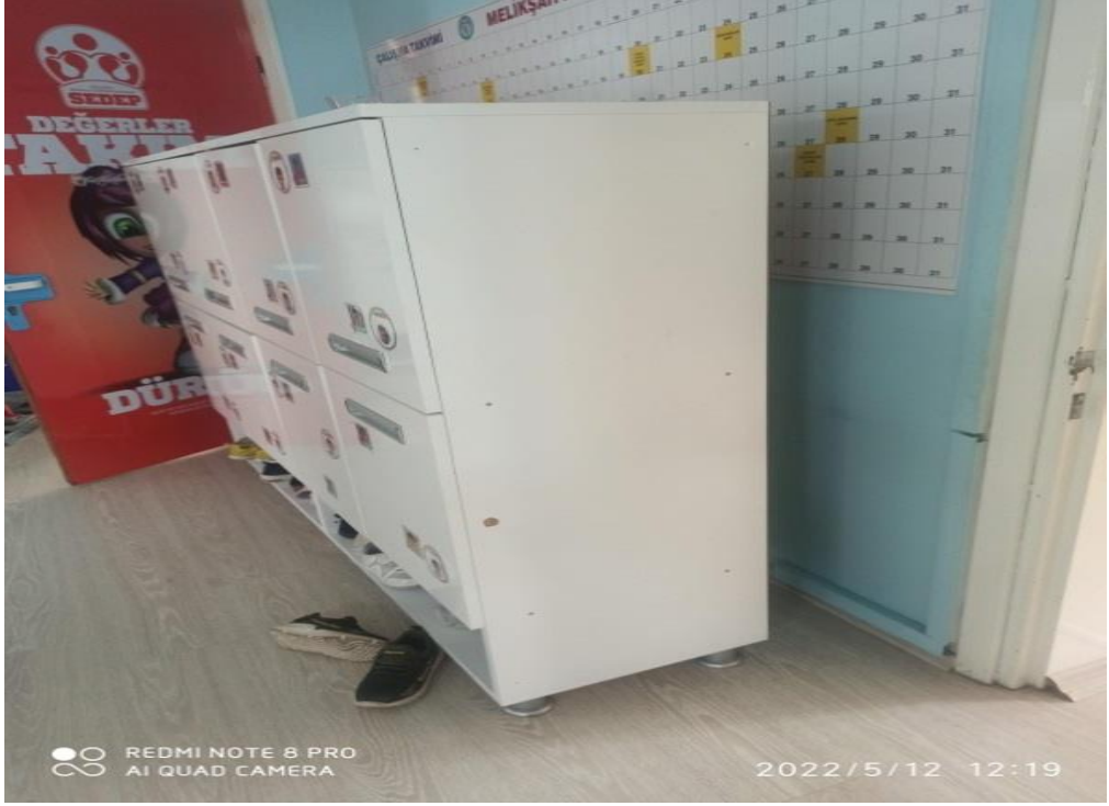
Şekil 4.38. Koridorlardaki dolapların sabitlenmemesi.
