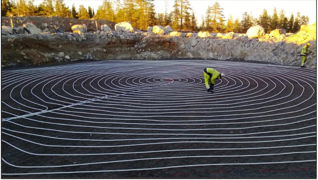
Şekil 2.22. Danimarka'da yapılan bir yeniden güçlendirme projesinde türbin temelinde olan bir çalışma [41].
