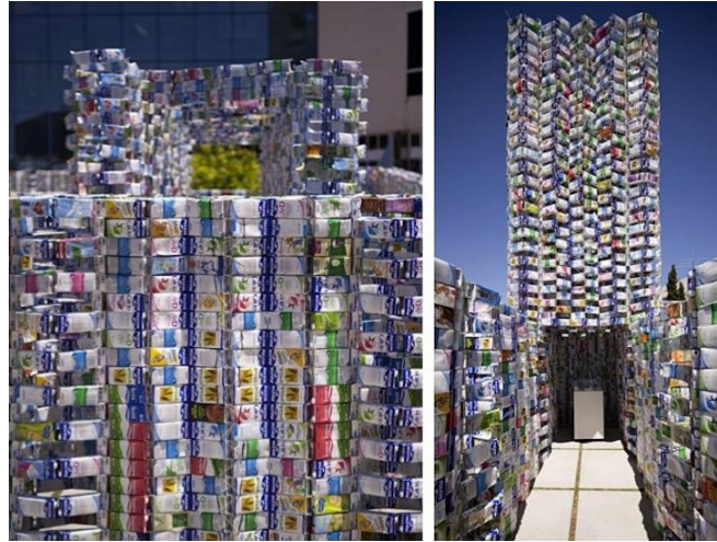
Şekil 2.8. İspanya Pavilion of tetra briks [16]
