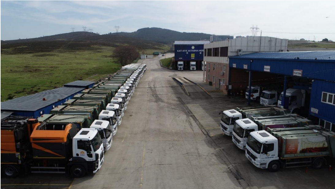
Şekil 4.17. Sultanbeyli Belediyesi Katı Atık Aktarma Merkezi
