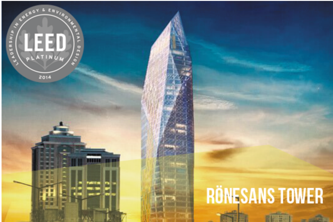
Şekil 4.18. Rönesans tower kule LEED CS platin sertifikalı (ERKE, 2022)
