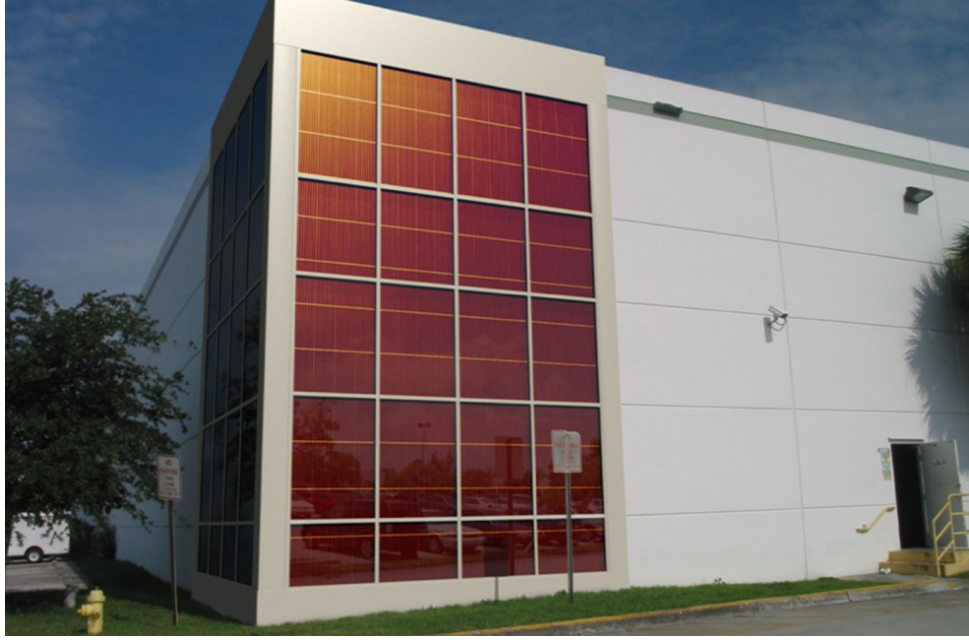
Şekil 2.7. Bina cephelerinde fotovoltaik cephe sistemleri (Yapı Kataloğu Dergisi, 2022)
