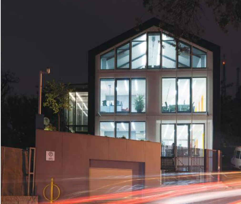
Şekil 4.17. Erke green akademi LEED NC platin sertifikalı (ERKE, 2022)
