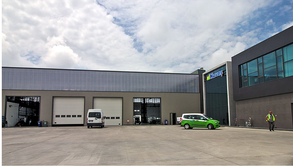
Şekil 4.10. Havaş İstanbul havalimanı antrepo binası (ALTENSİS, 2017)
