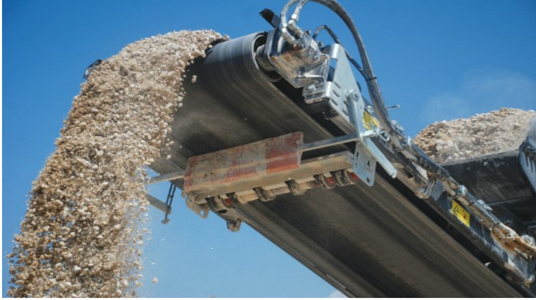
Şekil 2.13. İnşaat atıklarının geri dönüştürülmesi (Yalova Çevre Şehircilik Müdürlüğü, 2022)
