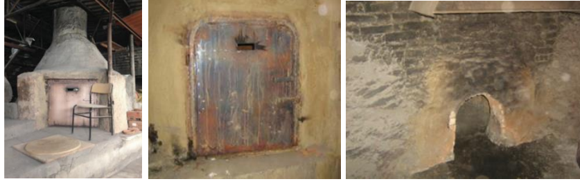
Görsel 124: Odunlu Fırın; Doldurma Kapısı ve Ateşlik Bölümü
