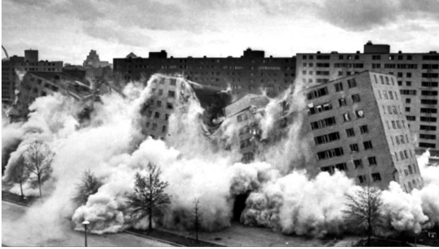
Resim 3: Pruitt-Igoe Konut Yerleşmesinin Yıkılma Anı, 1972
