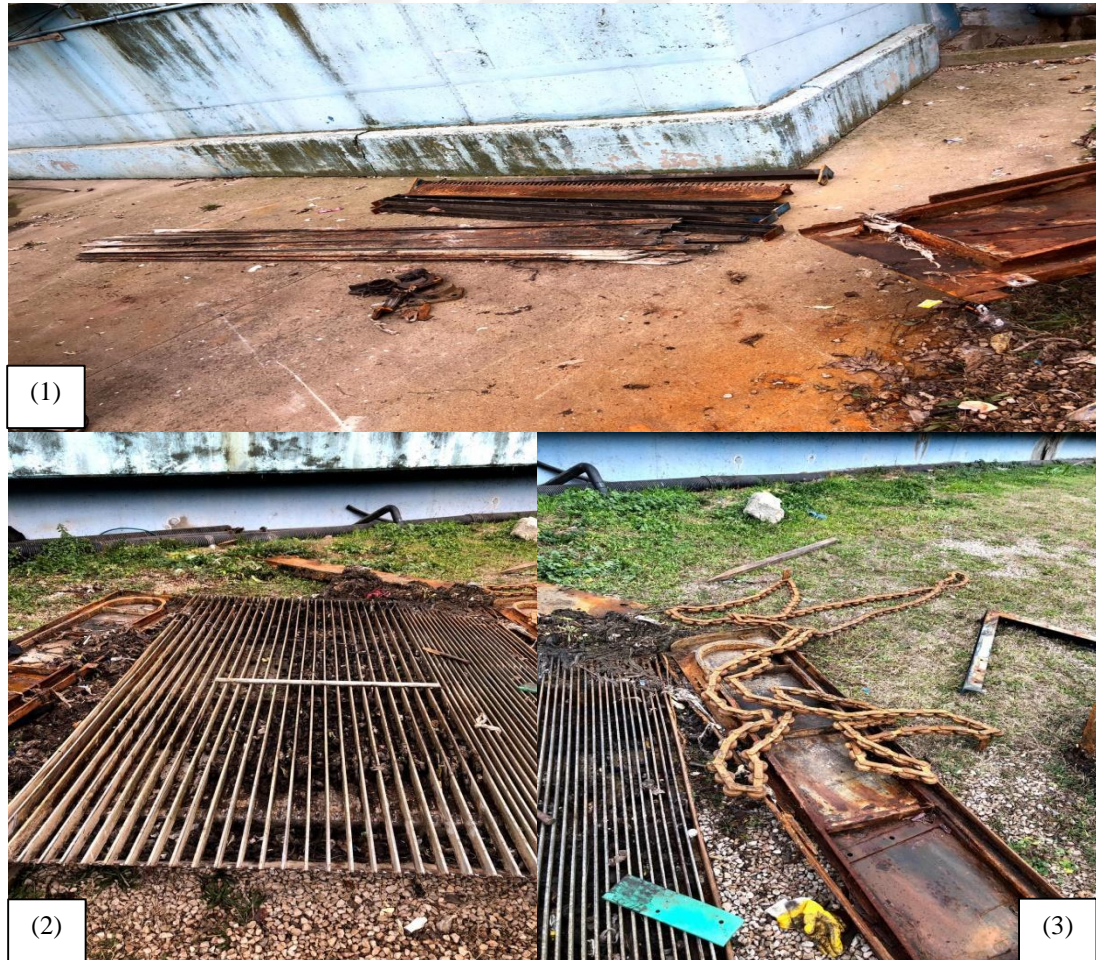
Şekil 3.1. Söz konusu tesiste kullanılmayan fakat yeniden kullanıma uygun bazı parçalar. (1) Kullanımdan kaldırılmış ızgara lamaları ve bir adet ızgara tırnağı. (2) Kullanım dışına ayrılmış ince ızgaranın kullanılabilir lamaları. (3) Bazı baklaları hala kullanılabilir durumda olan zincir parçaları.
