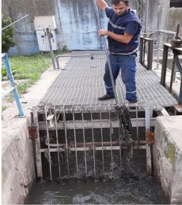
Şekil 1.2. Kocaeli ilinde bir tesisten alınmış kaba ızgaranın tuttuğu kirliliği gösteren örnek.
