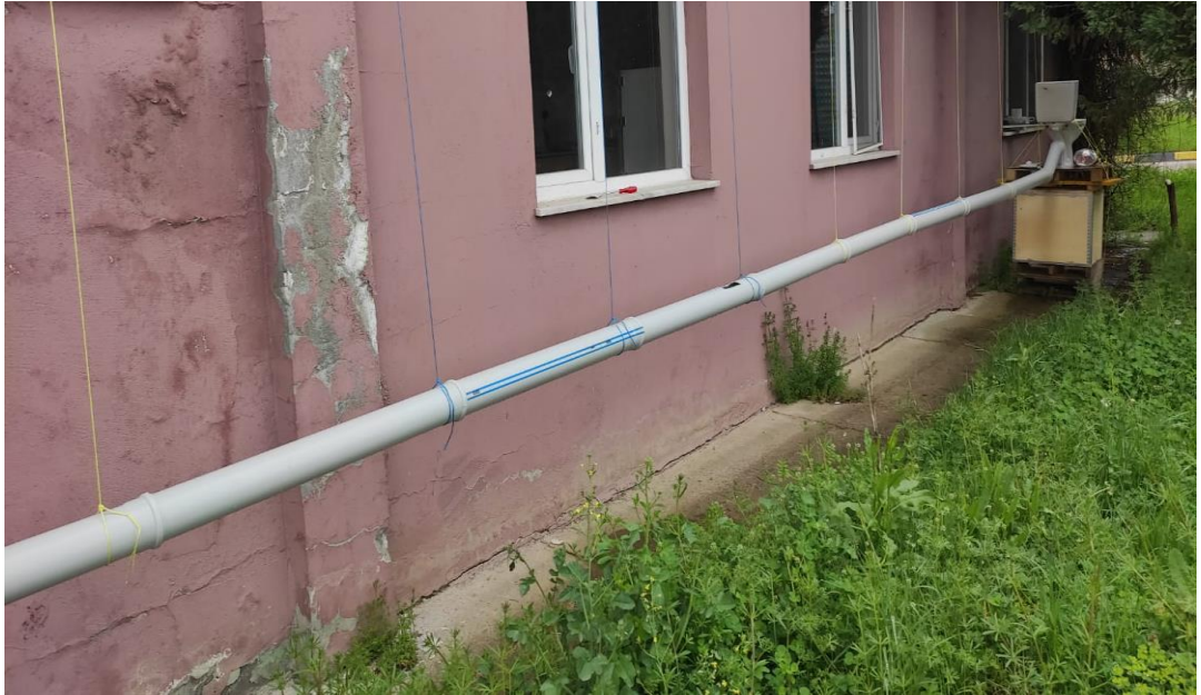
Şekil 3.1. Hendek atıksu arıtma tesisinde kurulan deney düzeneği
