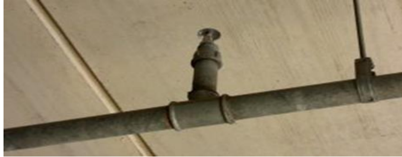
Şekil 3.1. Otomatik çalışan sprinkler sistemi
