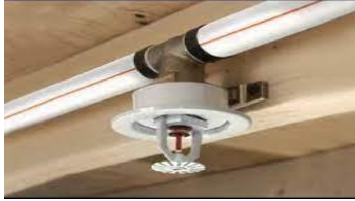
Şekil 3.2. Manuel çalışan sprinkler sistemi
