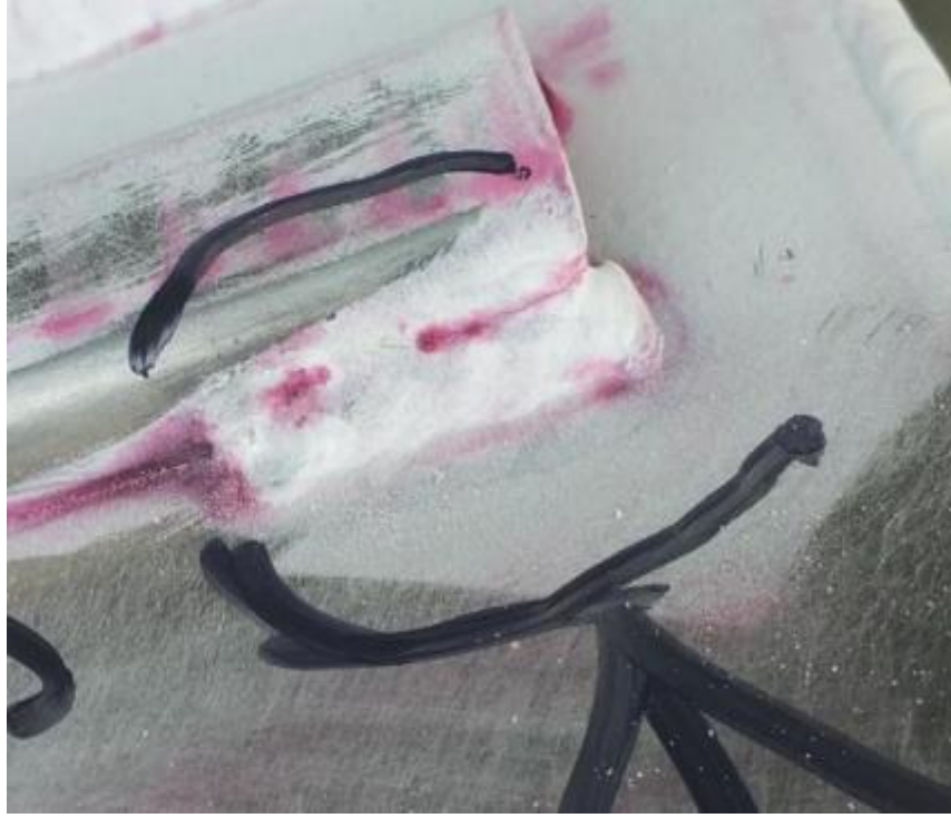
Şekil 6.4. Alüminyum kaynağı dikişinde penetrant muayenesi sonrası görülen krater çatlakları.
