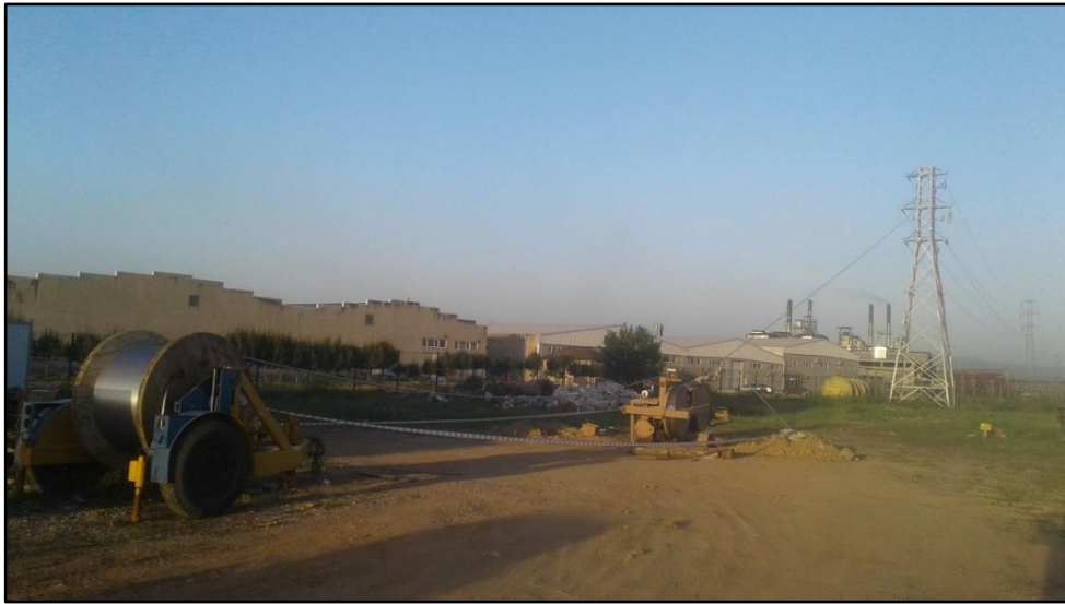
Şekil 2.29.ACCC saha uygulaması iletken kurulumu
