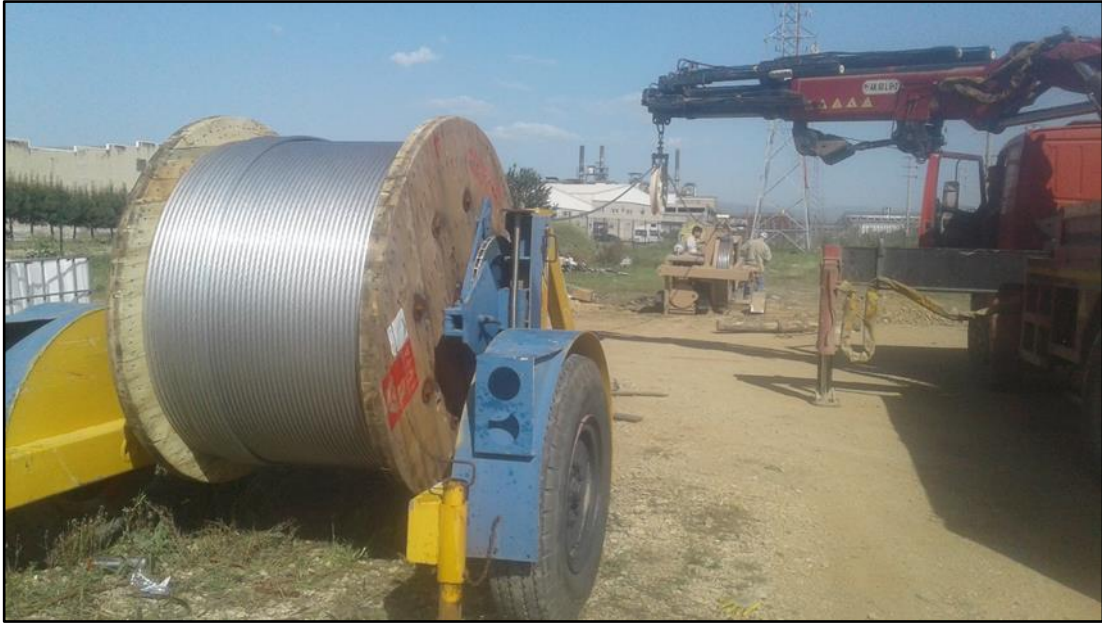
Şekil 4.6. ACCC Lisbon iletken kurulumu
