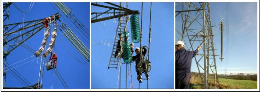
Şekil 2.25. Havai hat çekilmesi [4].
