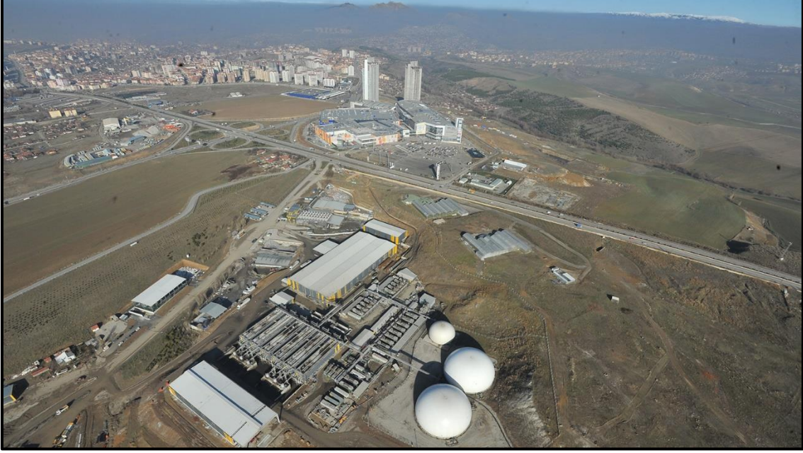
Fotoğraf 16: Mamak Entegre Katı Atık Yönetim Tesisi
