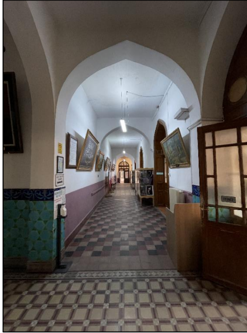
Fotoğraf 10: Edirne İttihat ve Terakki Kulübü Binası, (Halk Eğitim Merkezi Binası), Batı Girişin Sağ Tarafından Uzanan Koridor
