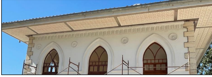
Fotoğraf 76: Karaağaç Jandarma Karakol Binası (Lojman) Doğu Cephesinden Süsleme Detay
