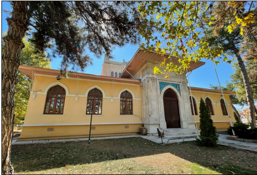
Fotoğraf 4: Edirne İttihat ve Terakki Kulübü Binasi (Halk Eğitim Merkezi Binasi), Ön Cephe Görünümü
