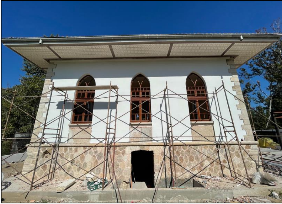
Fotoğraf 74: Karaağaç Jandarma Karakol Binası (Lojman) Güney Cepheden Görünüm
