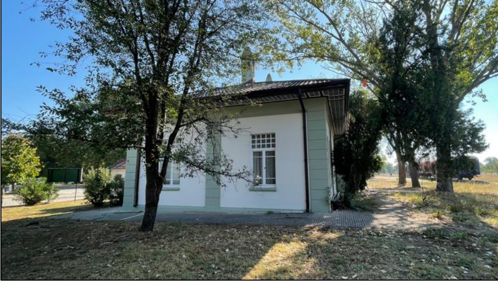
Fotoğraf 63: Karaağaç Eski İstasyon/Gar Binası (Trakya Üniversitesi Doğa Tarihi Müzesi), Kuzeybatı Yönünden Görünüm
