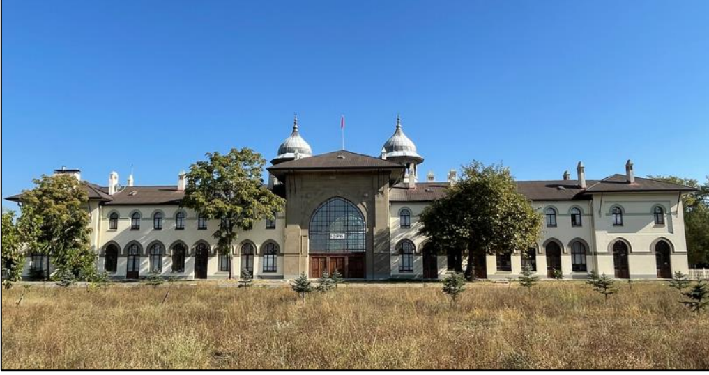
Fotoğraf 47: Karaağaç Gar Binası (Güzel Sanatlar Fakültesi) Arka Cepheden Görünüm
