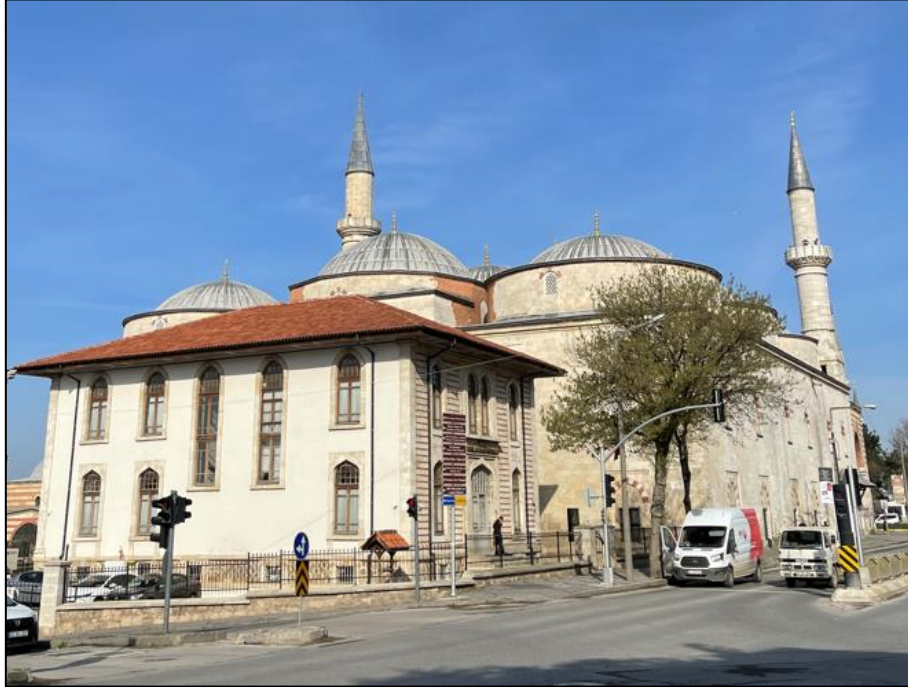
Fotoğraf 23: Edirne Vakıflar Bölge Müdürlüğü Binası Genel Görünüm
