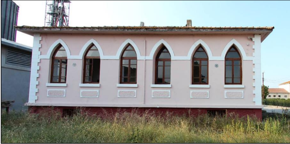
Fotoğraf 129: Tekirdağ-İnanlı Tarım İşletmesi (Eski Aygır Depo Binası) Güney Cepheden Görünüm
