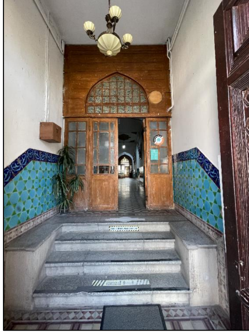
Fotoğraf 9: Edirne İttihat ve Terakki Kulübü Binası, (Halk Eğitim Merkezi Binası), Batı Cepheden Giriş Bölümü
