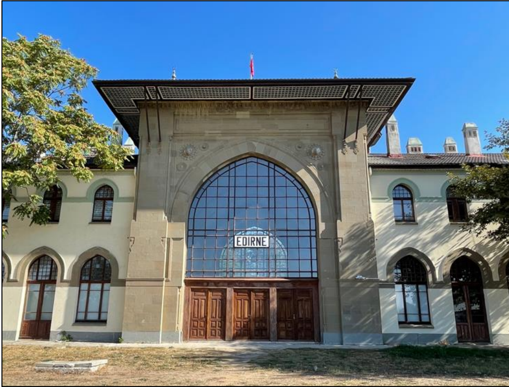
Fotoğraf 48: Karaağaç Gar Binası (Güzel Sanatlar Fakültesi) Arka Cephe Giriş Kısmı
