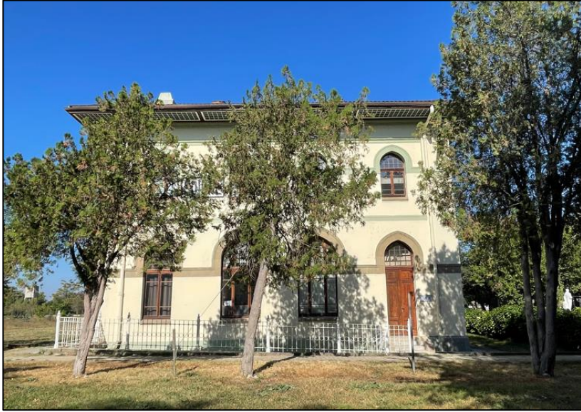
Fotoğraf 50: Karaağaç Gar Binası (Güzel Sanatlar Fakültesi) Güneydoğu Cephesi
