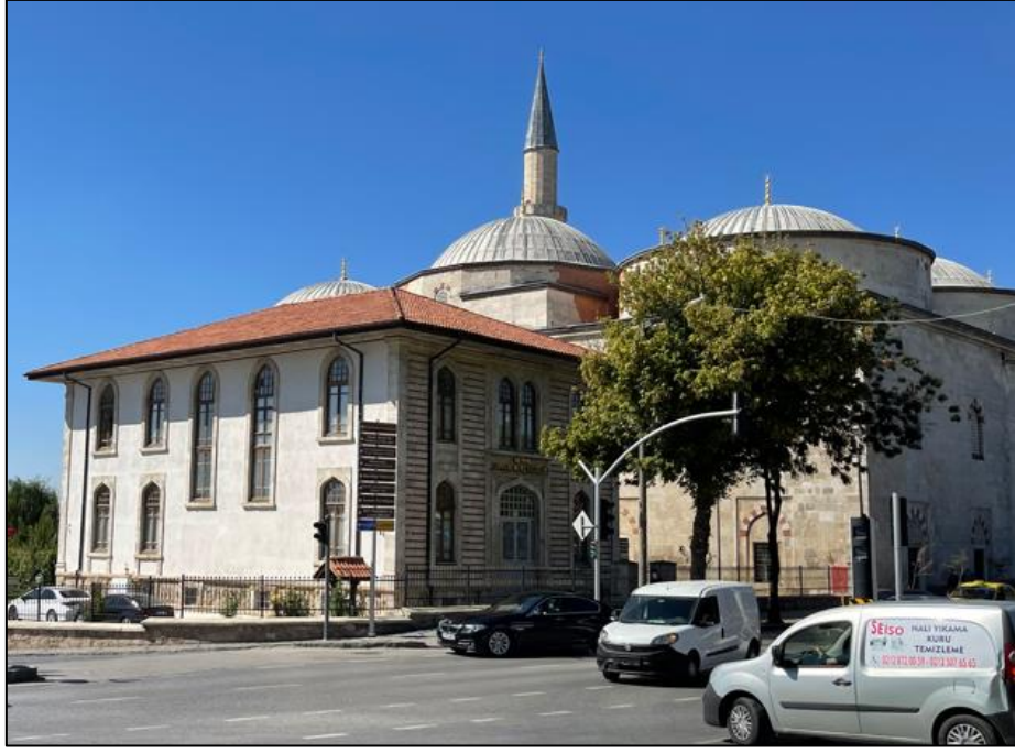
Fotoğraf 22: Edirne Vakıflar Bölge Müdürlüğü Binası Genel Görünüm
