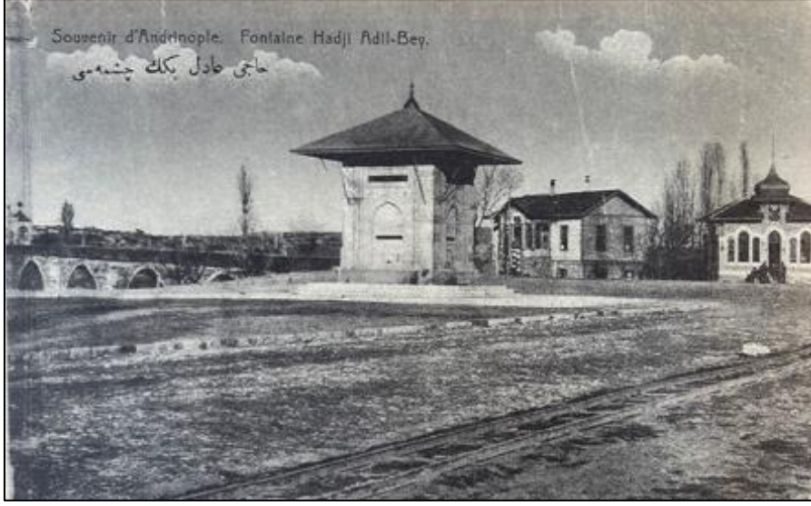
Fotoğraf 78: Karaağaç Hacı Adil Bey Çeşmesi ve Eski Tren Yolu
