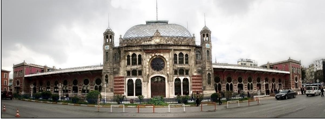
Fotoğraf 41: İstanbul Sirkeci Garı, Cephe Görünümü
