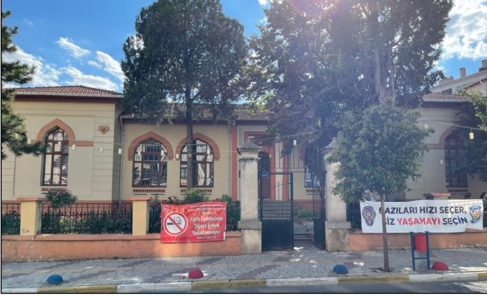
Fotoğraf 132: Kırklareli-Babaeski Atatürk İlkokulu (Atatürk Kültür Merkezi Binası), Ön Cephe Genel Görünüm
