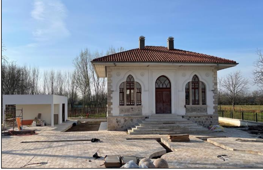
Fotoğraf 71: Karaağaç Jandarma Karakol Binası (Lojman) Ön Cepheden Görünüm, Nisan 2022
