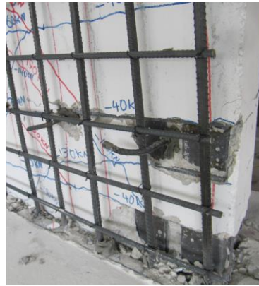
Şekil 6.26. RCSW-2 numunesi onarım mantosu donatılandırma aşamaları
