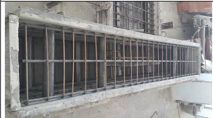
(b) Kompozit perde duvar temel donatısı yerleşimi
