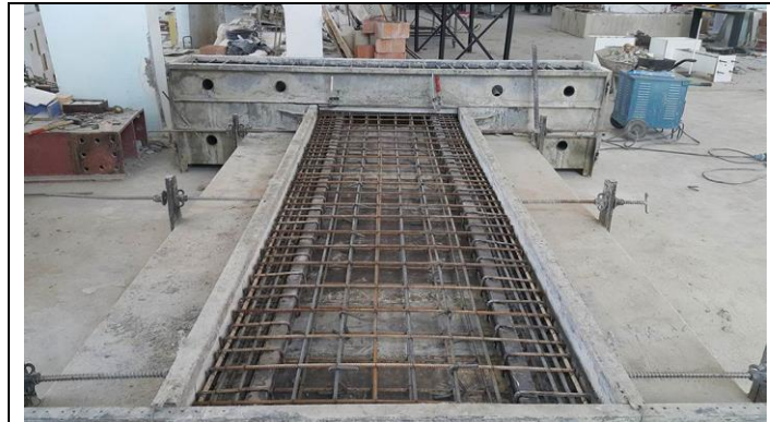
(a) Kompozit perde duvar gövde donatısı yerleşimi
