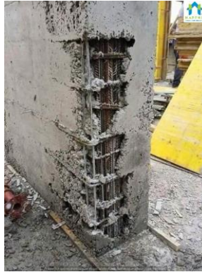
Şekil 1.1. Donatı yoğunluğundan kaynaklı segregasyon [2]
