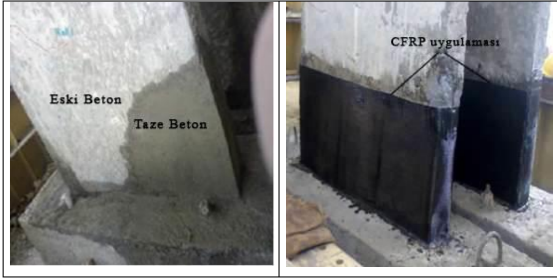
Şekil 2.3. Numune onarım aşamaları [5]
