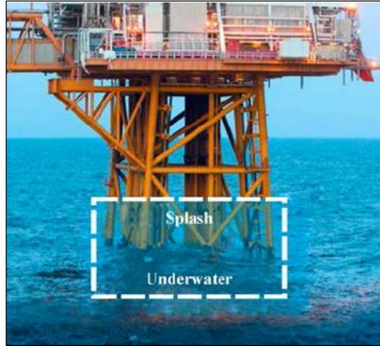
Şekil 2.5. Offshore platform yapısının sıçrama ve su altı zonları [46].
