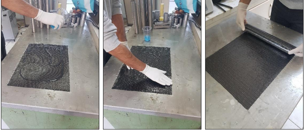
Şekil 3.15. Harcın dökülmesi, harcın kumaşa yedirilmesi ve kolona sarılması.
