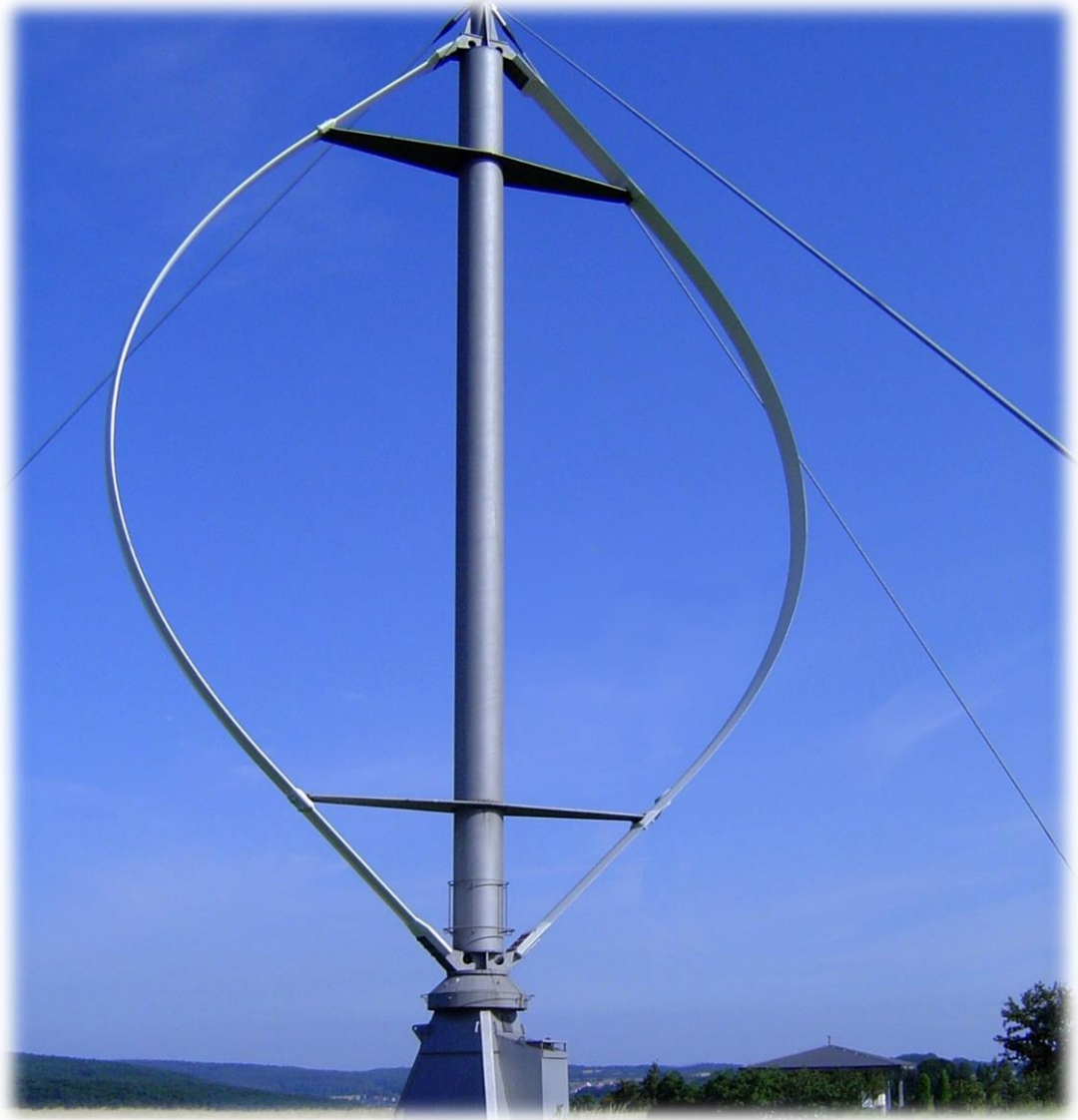
Şekil.3.3. Darrieus tipi düşey eksenli rüzgâr türbini [52]
