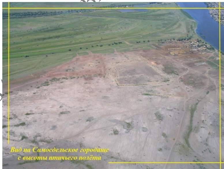
Resim 2. Samosdelska Şehrinin Kuş Uçuşu Yükseklikten Görünüşü
