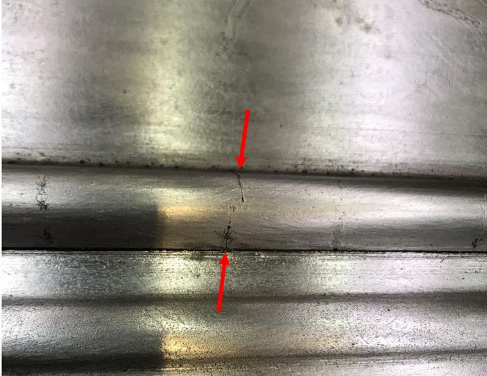
Şekil 3.6. Bir çekme kalıbı yüzeyinde oluşan çatlağın görünümü
