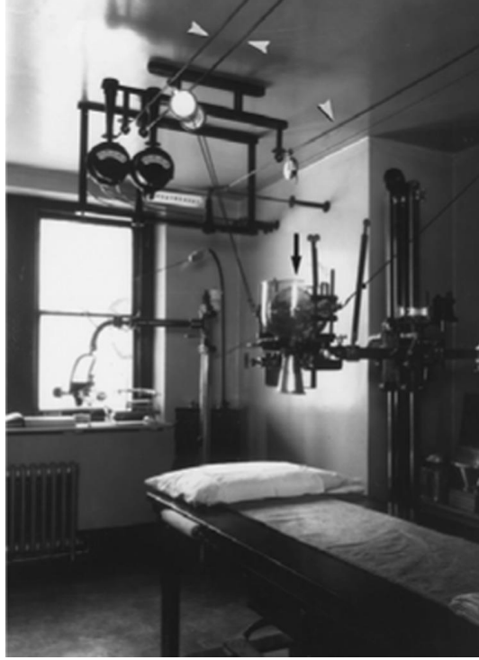
Şekil 2.4. 1925'te çekilmiş bir X-ışını muayene odası; yüksek voltaj kabloları beyaz okla, x-ışını tüpü duvarda siyah okla gösterilmektedir [20].
