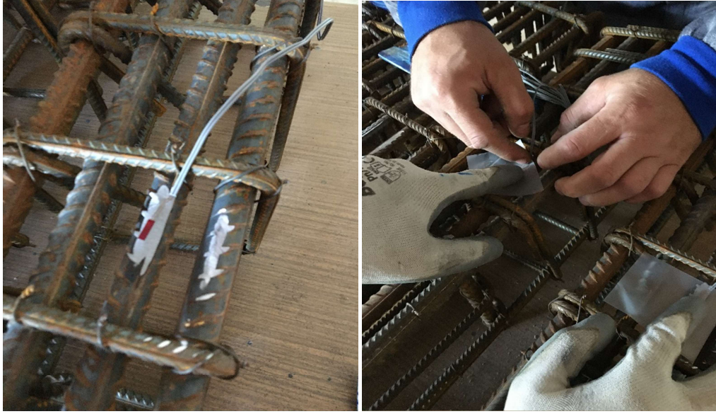
Şekil 4.4. Strain-gauge (gerinim ölçer) yerleştirilmesi
