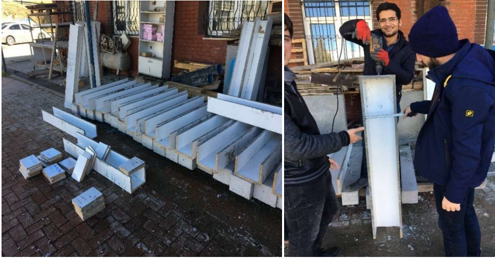
Şekil 4.2. Kalıpların hazırlanması
