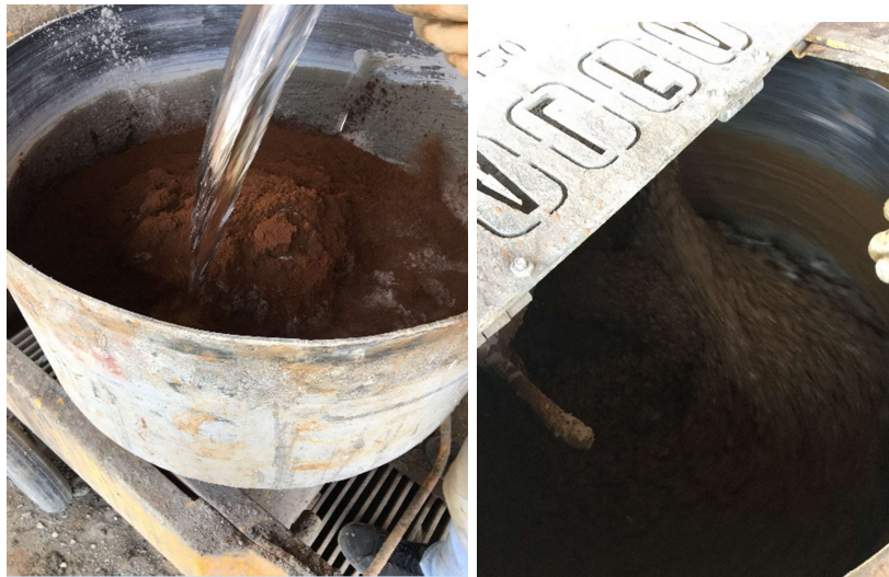
Şekil 4.9. Beton karma işlemi
