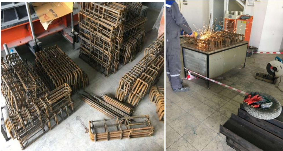
Şekil 4.3. Donatıların hazırlanması
