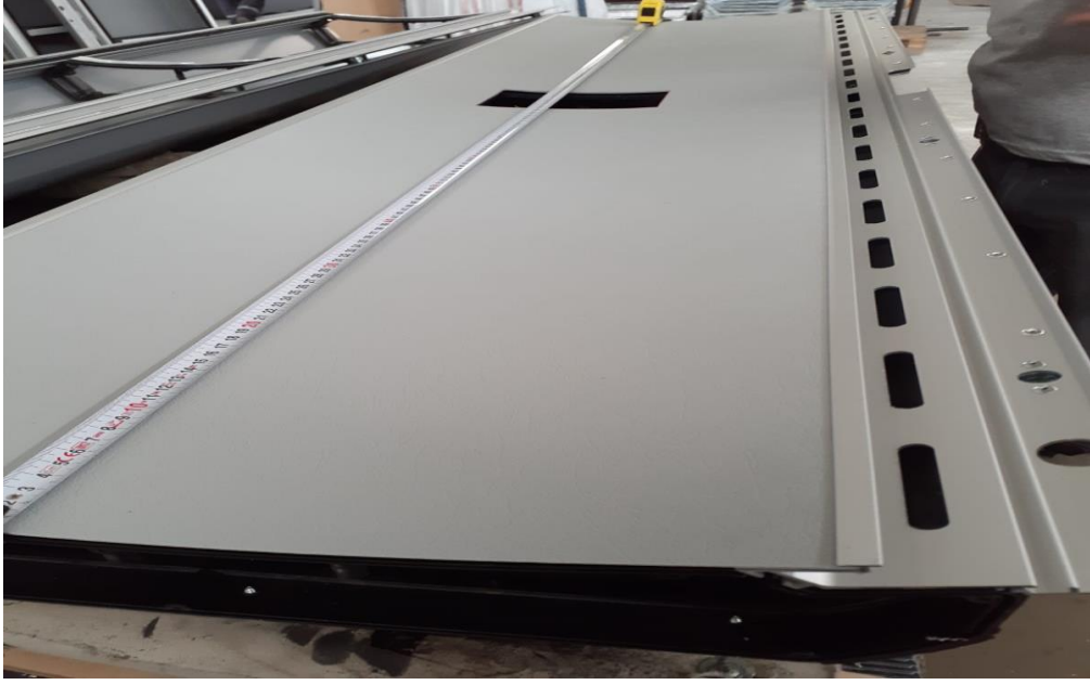
Şekil 4.12. Hava kanalı montajı
