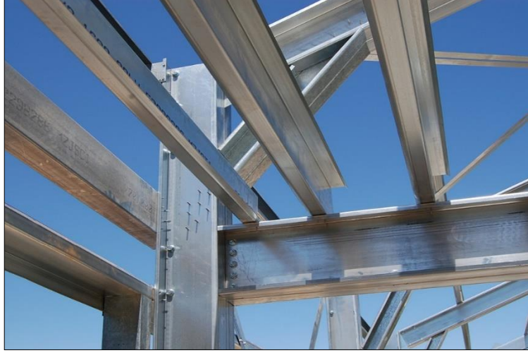
Şekil 3.12. Soğuk Şekillendirilmiş Çelik Elemanların Yapıda Kullanılması [50]
