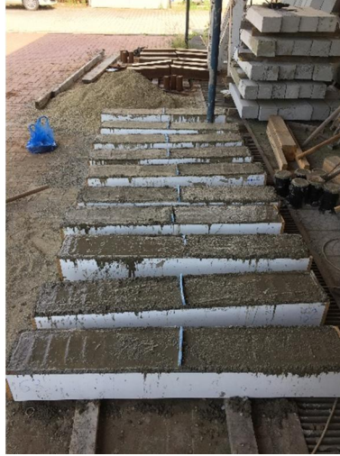
Şekil 3.19. Bazı numunelerin beton dökümünden sonraki halleri
