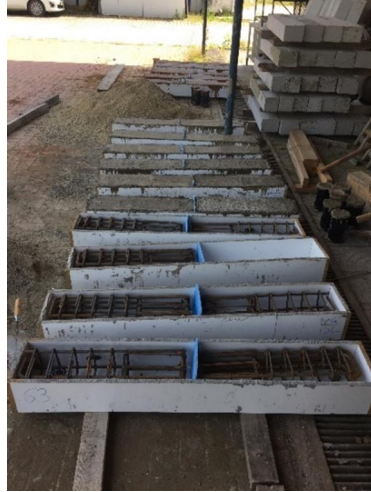
Şekil 3.18. Bazı numunelerin beton dökümünden önceki halleri
