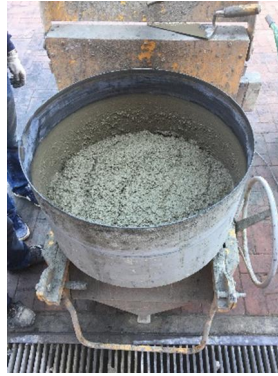
Şekil 3.14. Elde edilmiş betonun görüntüsü
