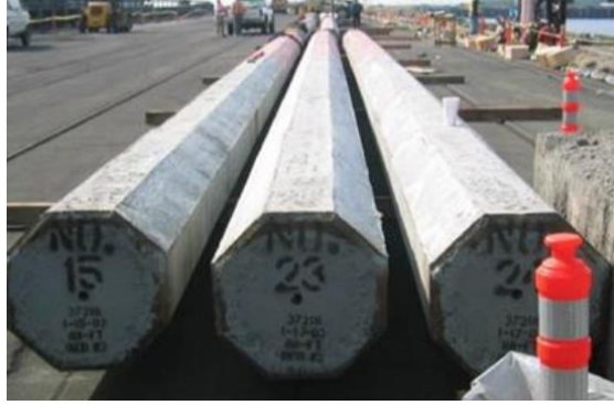
Şekil 3.8. Önceden dökme (prekast) kazıklar [11]
