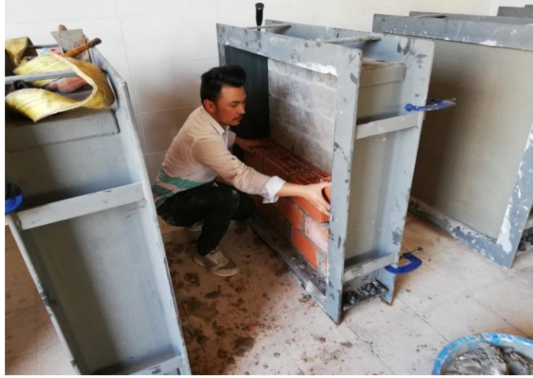
Şekil 3.19. Deneş elemanlarının yapım aşamasında tuęla duvar örülmesi
