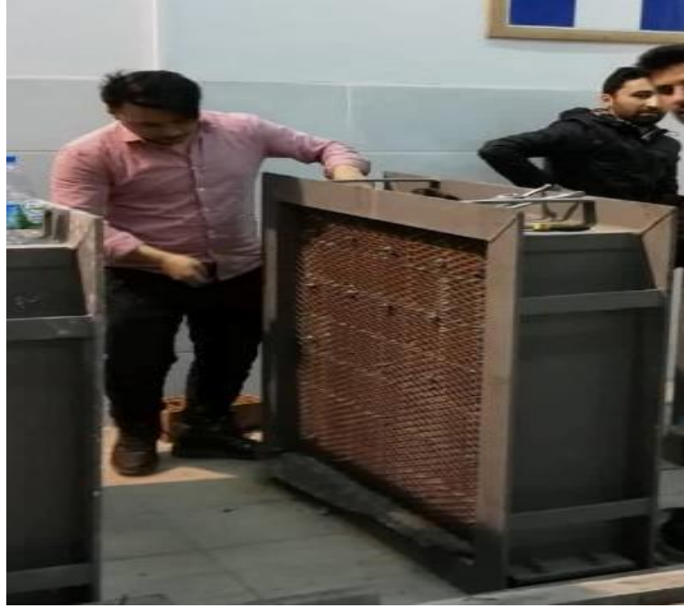
Şekil 3.21. Deneç elemanlarının yapım aşamasında ankaraj uygulaması
