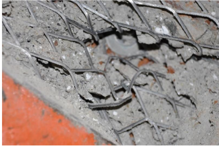
Şekil 4.6. MBW 2,0-200 deney sonu hasar durumu
