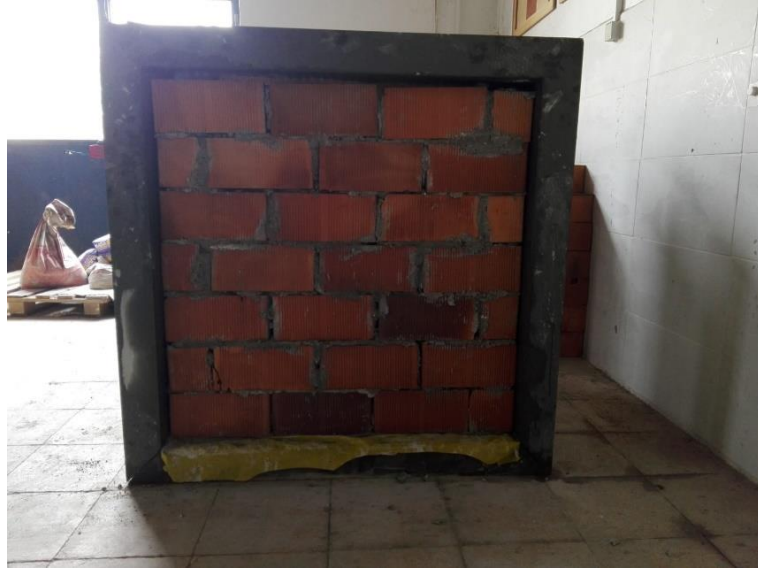
Şekil 3.20. Çerçeve içinde bitmiş tuęla duvar durumu
