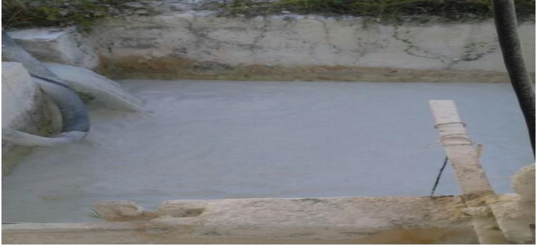
Şekil 4.12. Mermer işleme tesislerindeki betonarme çöktürme havuzu örneği
