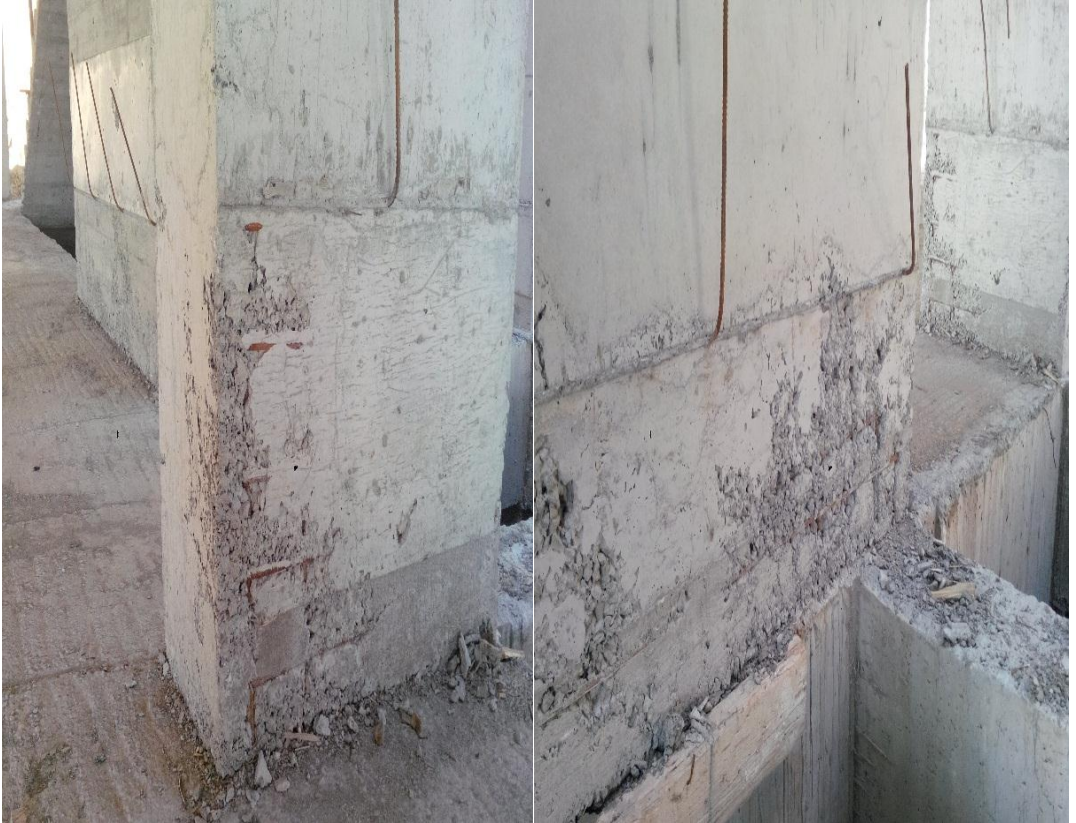
řekil 4.10. Pas payları uygun olmayan kolon rnekleri
