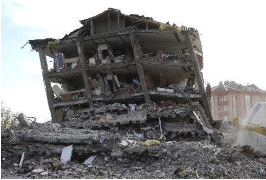
Şekil 3.1. Erciř ilçesinde ağır hasar görmüş/göçmüş bir asmolen yapı(C.Dönmez,2013)
