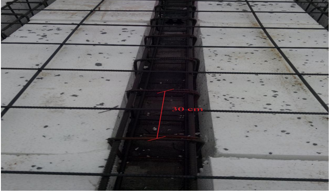
Őekil 4.23 Diřli döřemelerde diř için enine donatı aralıđına uyulmaması durumu
