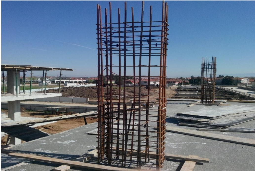
Şekil 4.9. Sarılma bölgesi yetersiz bir kolon örneği
