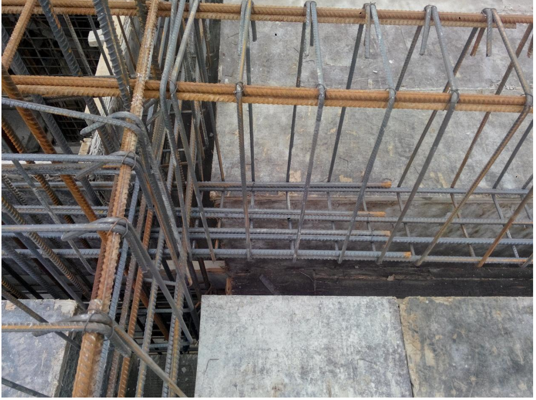
Şekil 4.16. Kiriş açıklık donatısının kenetlenme boyunun yetersiz olması durumu
