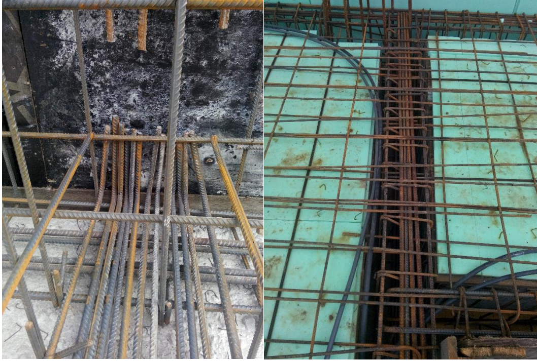
Şekil 4.13. Kirişlerde boyuna donatı arası mesafe şartına uymayan kiriş örnekleri
