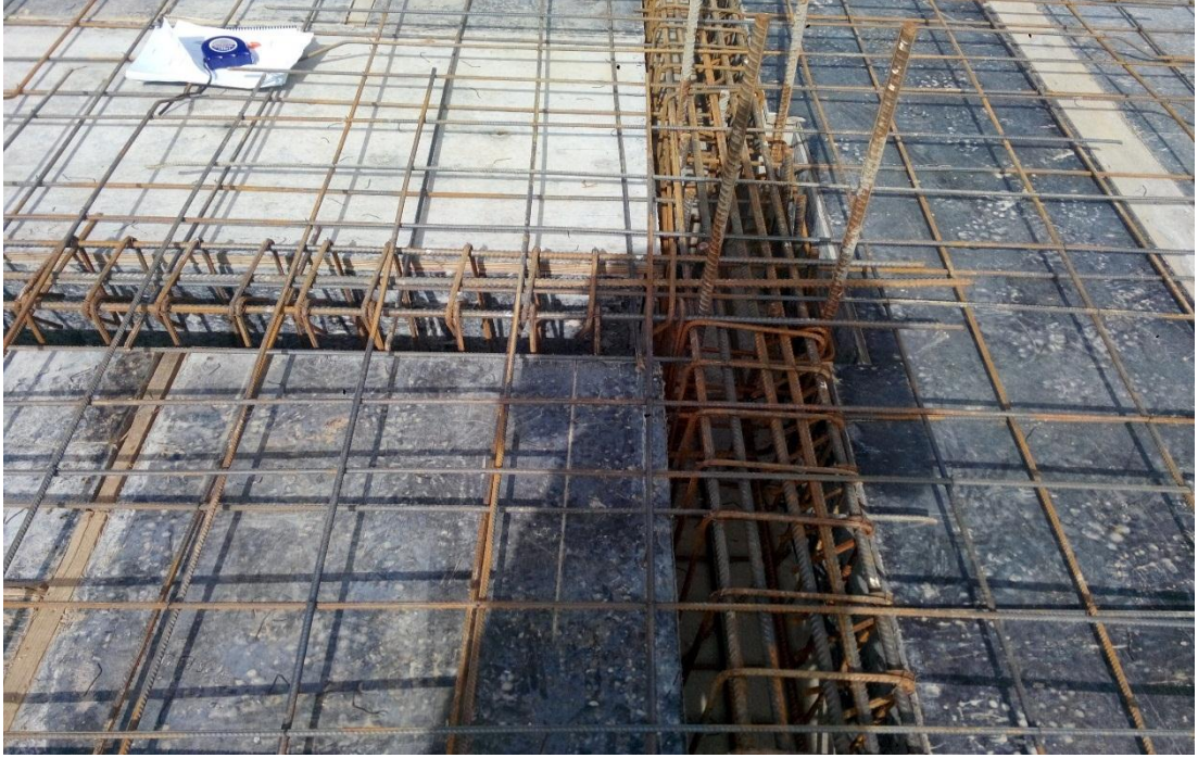
Şekil 4.14. Kirişlerde boy donatısının kolon bitiminde 90 derece bükülmemesi durumu
