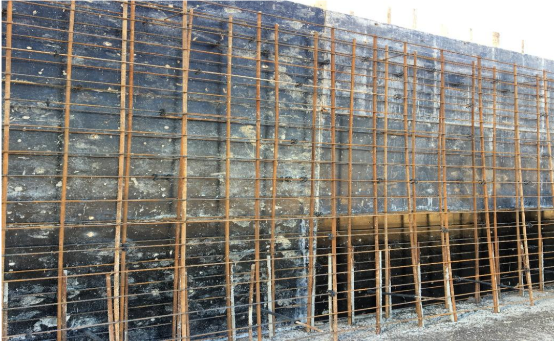
Şekil 4.30. Çiroz kullanılması şartına uyulmaması durumu
