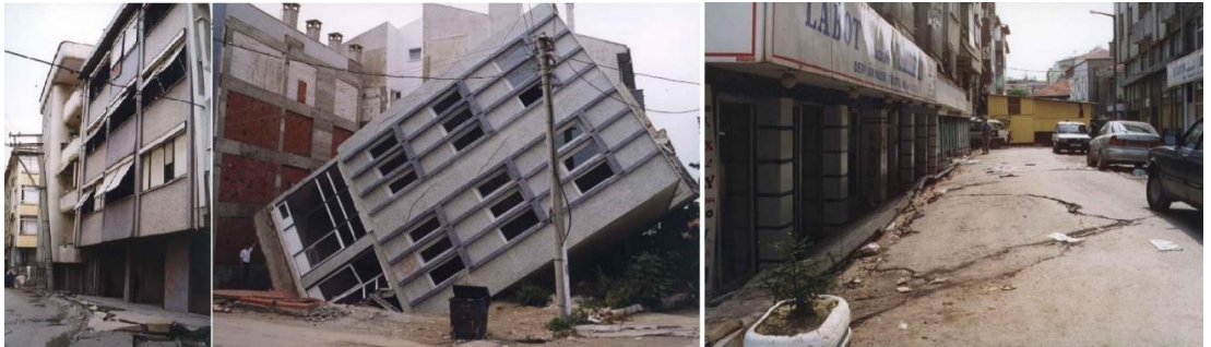
Şekil 2.1. Temel taşıma gücü yenilmesi (genel yenilme - yerel yenilme - zımbalama) [2]
