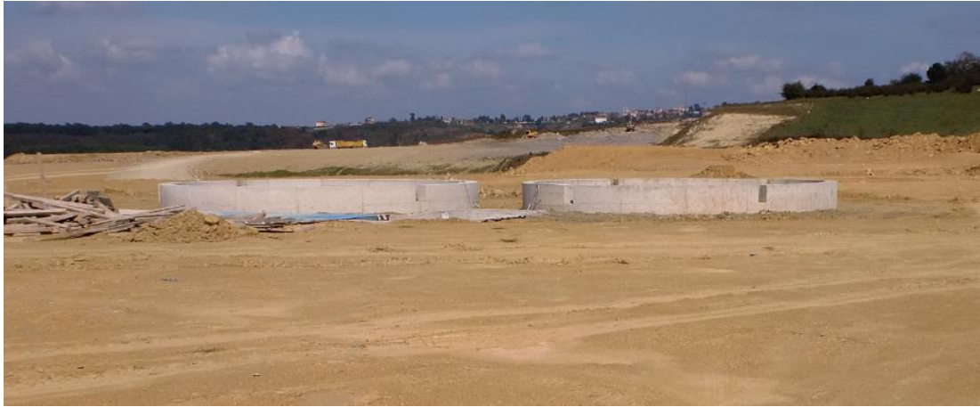
Şekil 2.2. Mevcut silo temeli altında zemin iyileştirmesi [3]
