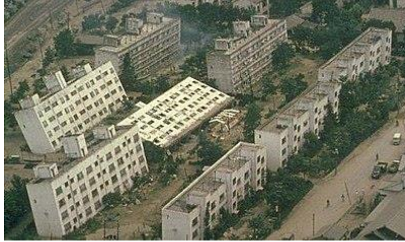
Şekil 2.4. 1964 Niigata (Japonya) depreminde zemin sıvılaşması [5]
