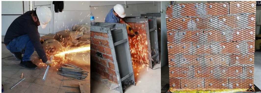
Şekil 4.16. Duvarlarda güçlendirme işlemleri - ankraj uygulaması
