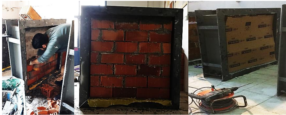
Şekil 4.15. Duvarların örülmesi ve matkapla delme işlemi için hazırlanması
