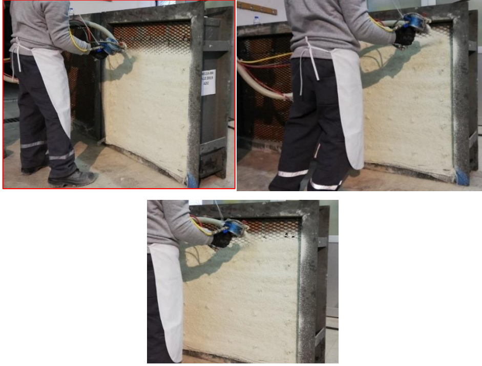
Şekil 5.3. Duvarlara cam lif katkılı püskürtme beton uygulaması
