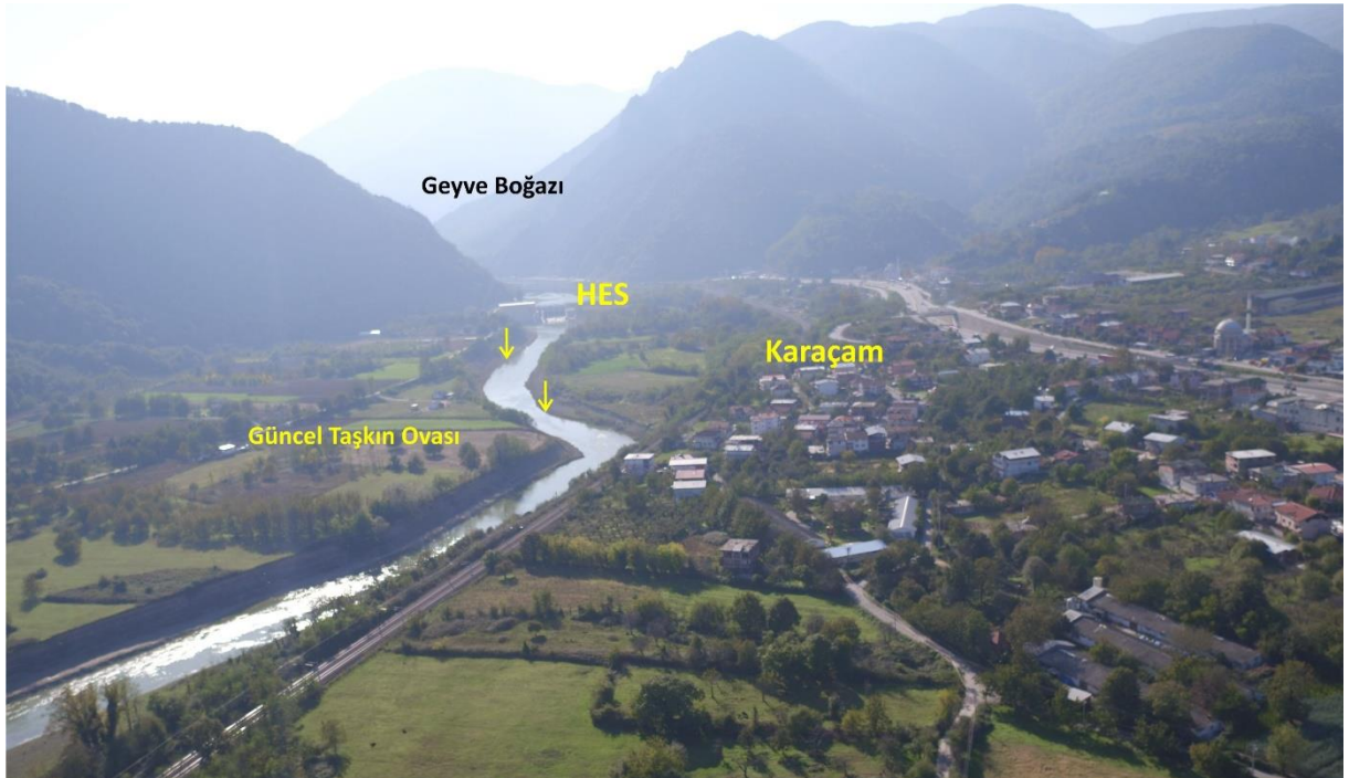
Şekil 54: Geyve Boğazi çıkışında yer alan Doğançay-2 Hidroelektrik Enerji Santrali. Sarı oklar HES çalışmaları sebebiyle yapılan kanal düzenlemeleri kapsamında Sakarya Nehri'nde gözlenen kot düşümünü göstermektedir. Yaklaşık 5 metre olan düşüm sebebiyle güncel taşkın ovası nehirten yukarıda yer almaktadır.
