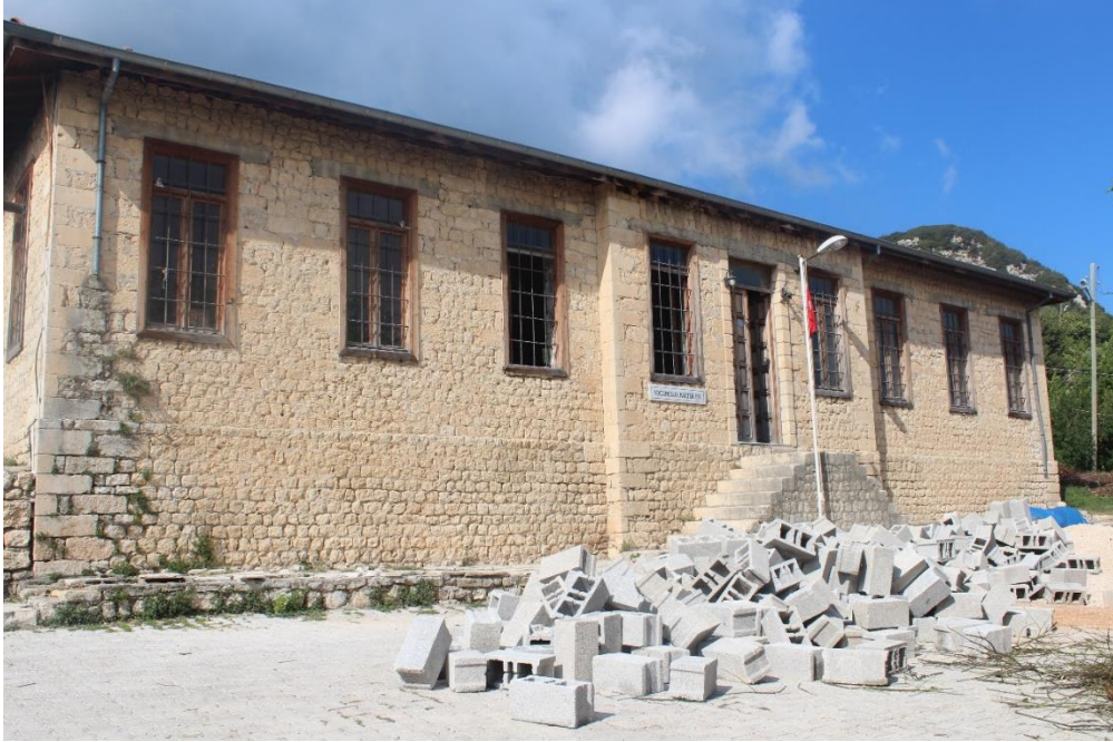
Resim 192: Yoğunluk Fransız Okulu Güney Cephe Giriş Bölümü (Müge Çiftyürek)
