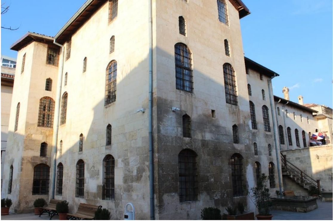
Resim 13: Kolejin Avludan Genel Görünüşü
