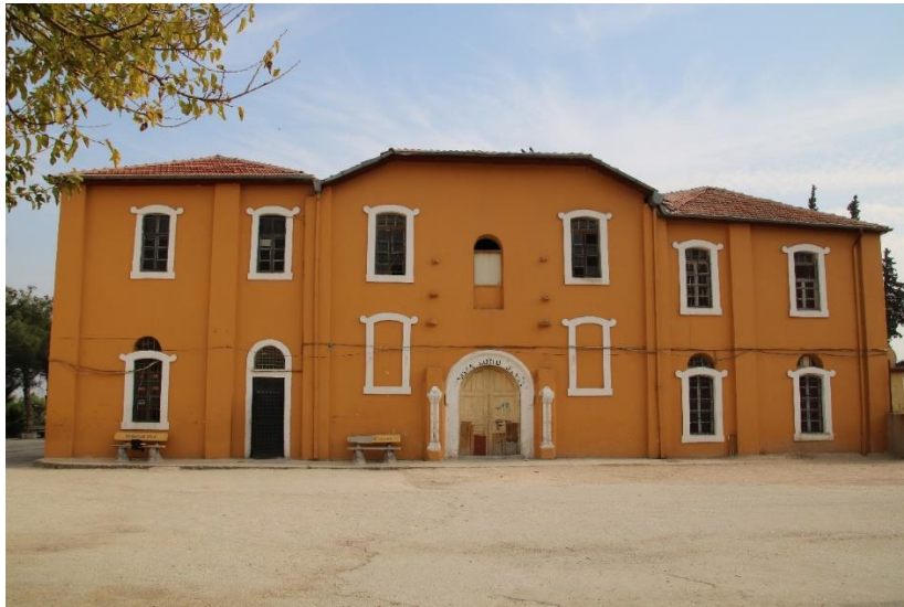
Resim 175: Okulun Kuzeybatı Cephesi (Servet Özkan)
