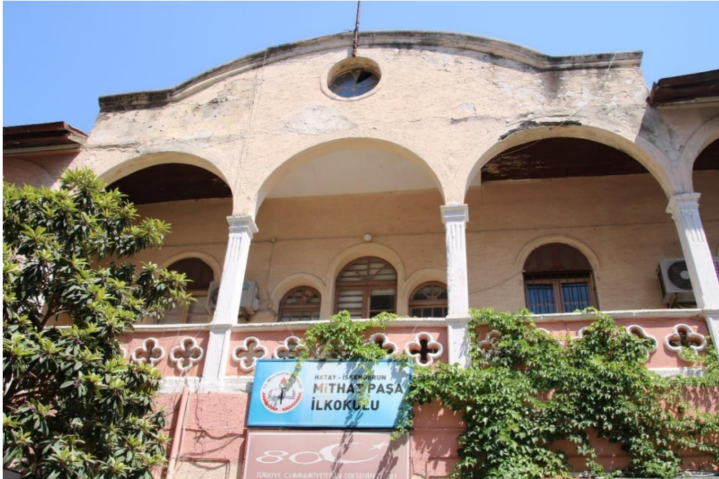
Resim 141: Yapının Batı Cephesindeki Birinci Kat Balkonu (Servet Özkan)
