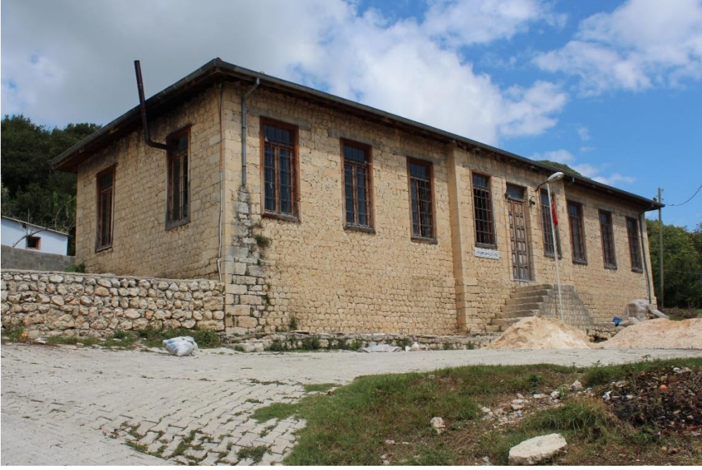
Resim 191: Yoğunluk Fransız Okulu Güney ve Batı Cepheler (Müge Çiftyürek)
