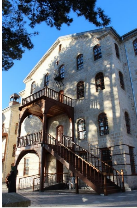
Resim 22: Doğudaki Yapının Güney Cephesi (Servet Özkan)
