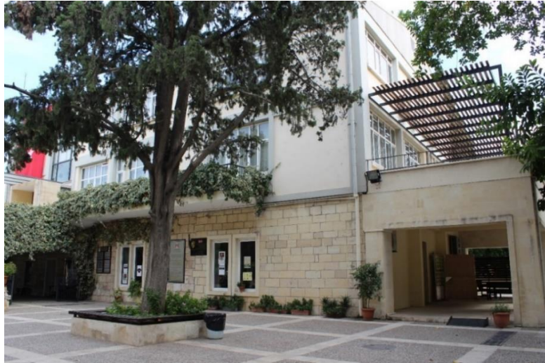
Resim 86: Shepard Hall'in Kuzeybatı ve Güneybatı Cepheleri (Servet Özkan)
