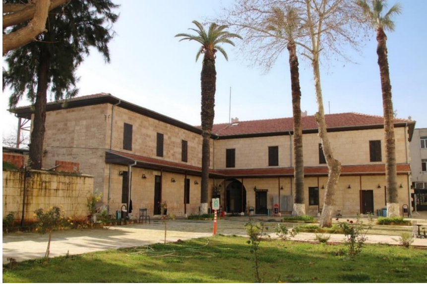
Resim 116: St. Joseph Kızlar Okulu'nun Doğu (Avlu) Cephesi (Servet Özkan)
