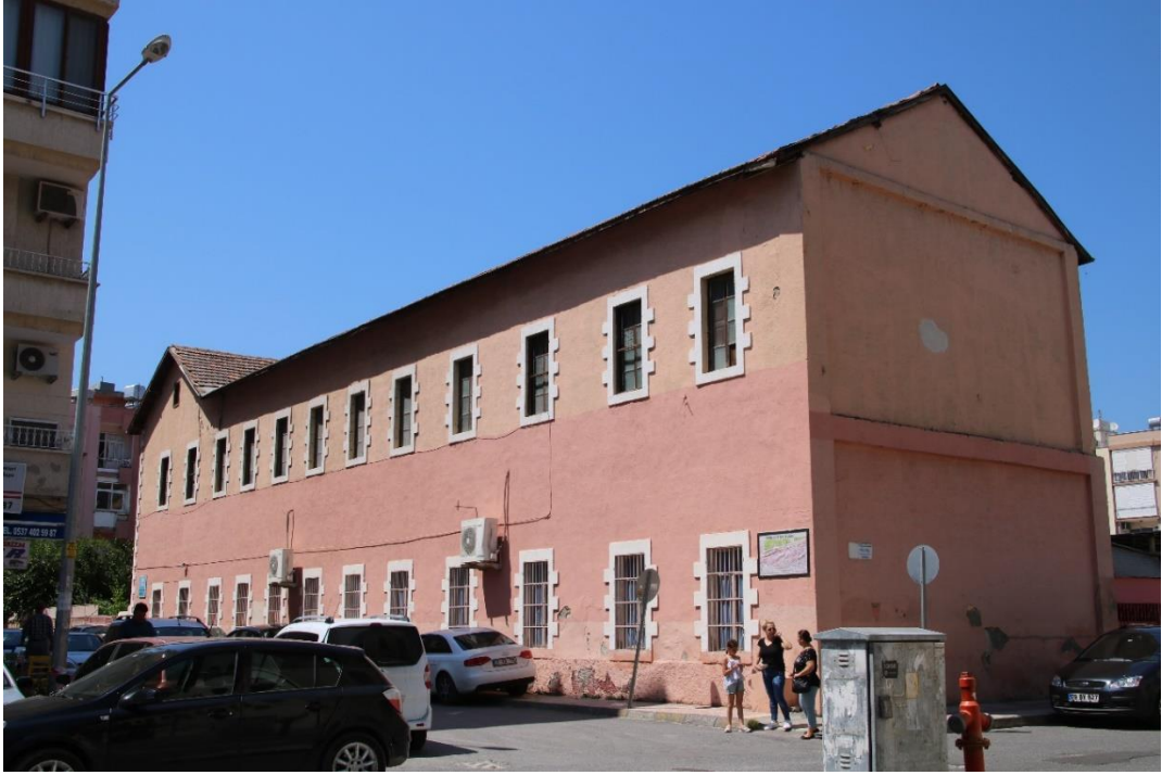
Resim 150: Yatakhane Binasının Güney ve Doğu Cephesi
