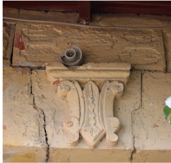
Resim 188: Kapı Kilit Taşındaki Süsleme ve Kitabe (Müge Çiftyürek)
