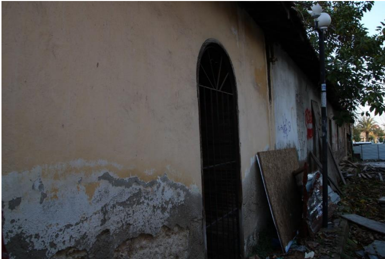
Resim 111: St. Antuan Erkek Okulu-Batı Yapının Batı Cephesi (Servet Özkan)
