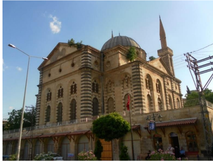
Resim 314: Gaziantep St. Mary Kilisesi (Kurtuluş Camii) (Servet Özkan)
