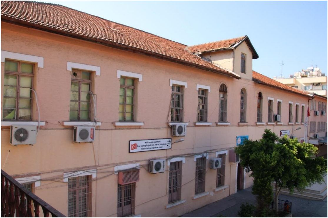
Resim 139: Yapının Doğu Cephesi (Avlu)
