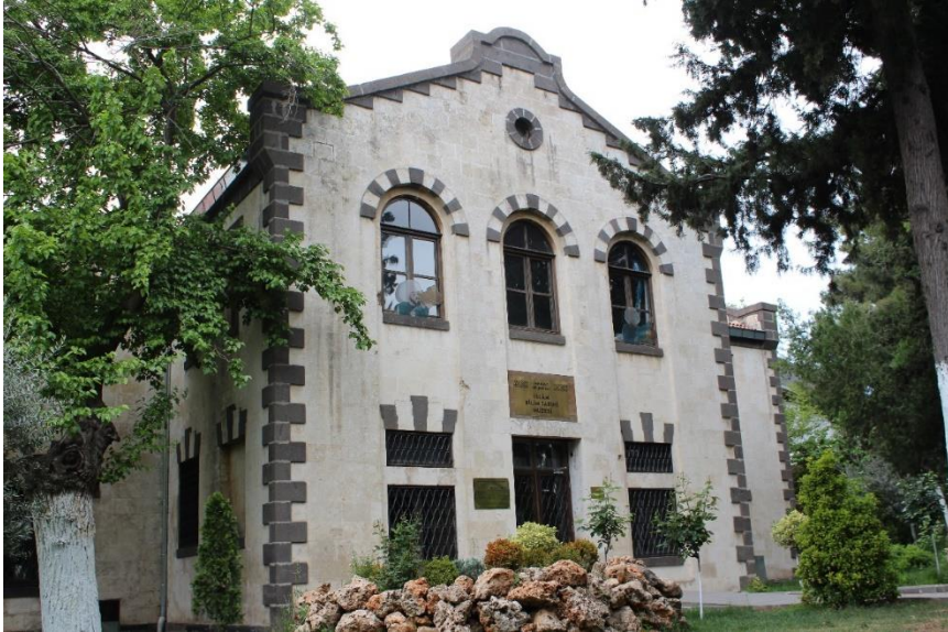
Resim 44: Kolejin Doğu (Giriş) Cephesi
