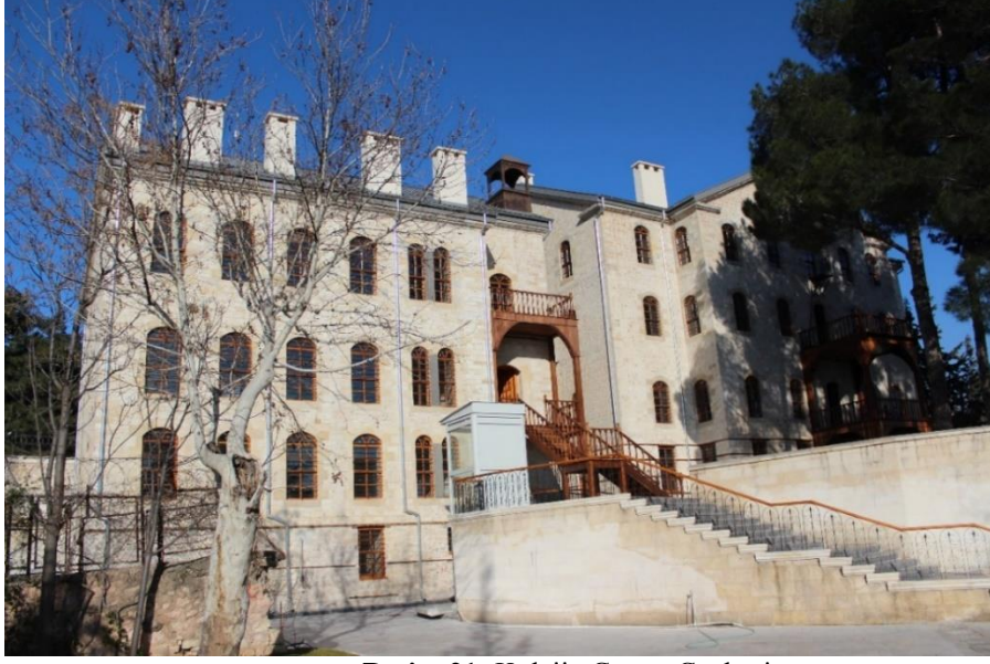
Resim 21: Kolej'in Güney Cephesi
