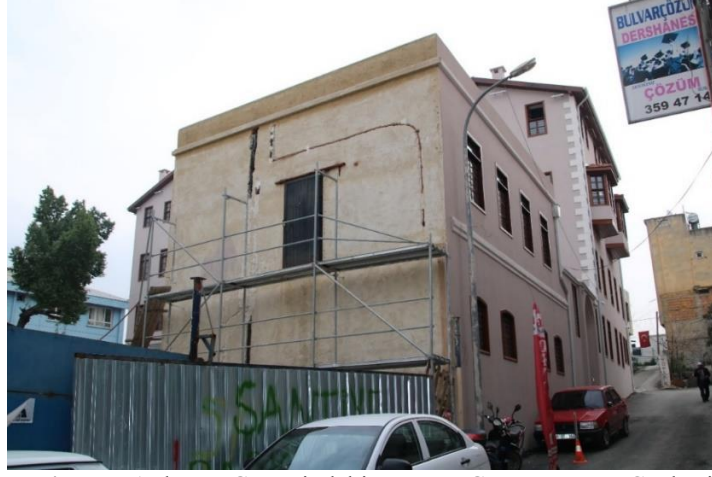
Resim 77: Avlunun Güneyindeki Yapının Güney ve Batı Cephesi (Servet Özkan)
