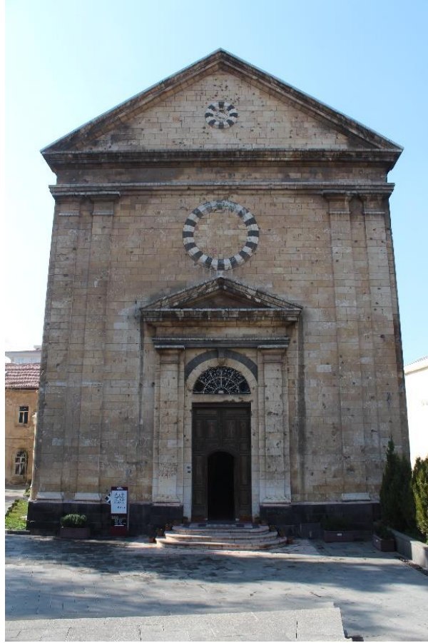
Resim 127: Kilisenin Doğu Cephesi (Servet Özkan)
