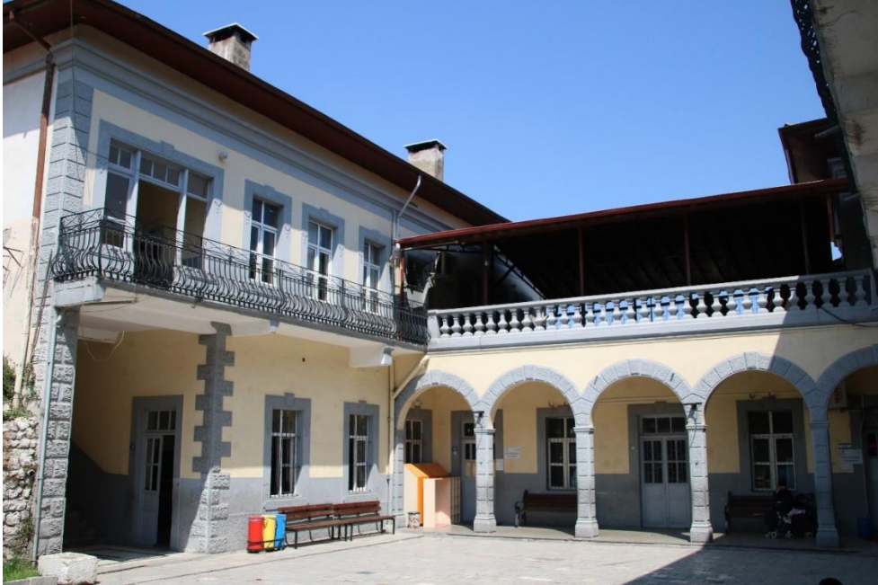
Resim 151: Kuzeybatı ve Güneybatı Kütlelerin Avlu Cephesi
