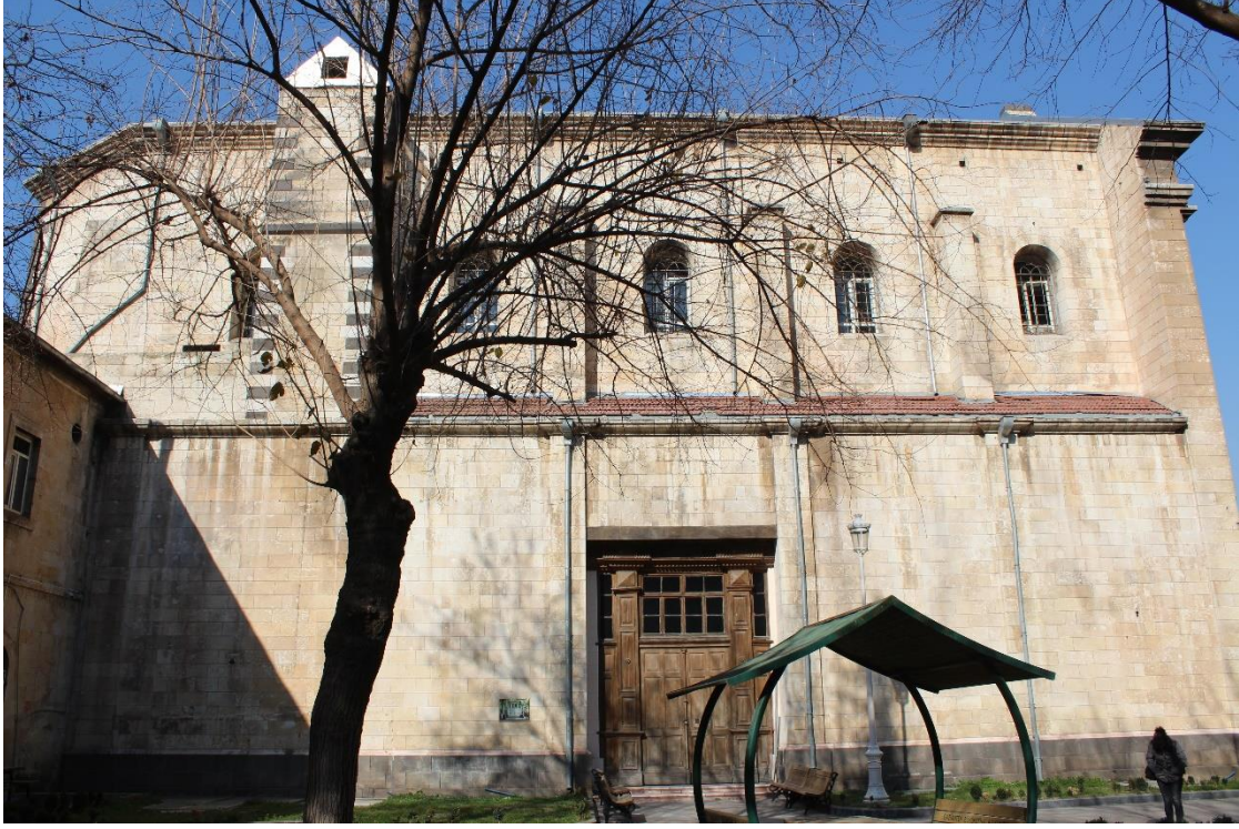
Resim 131: Kilisenin Güney Cephesi
