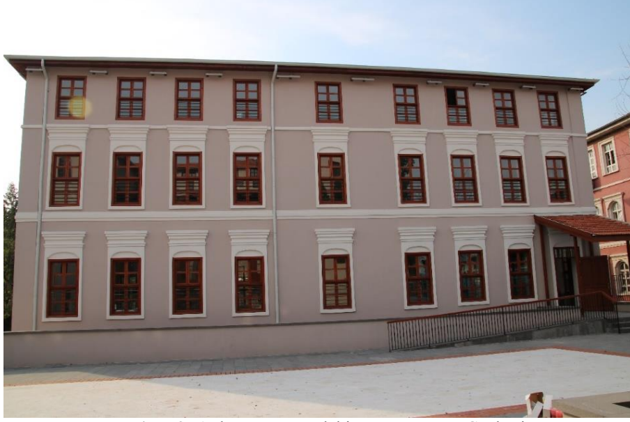
Resim 73: Avlunun Batısındaki Yapının Doğu Cephesi (Servet Özkan)
