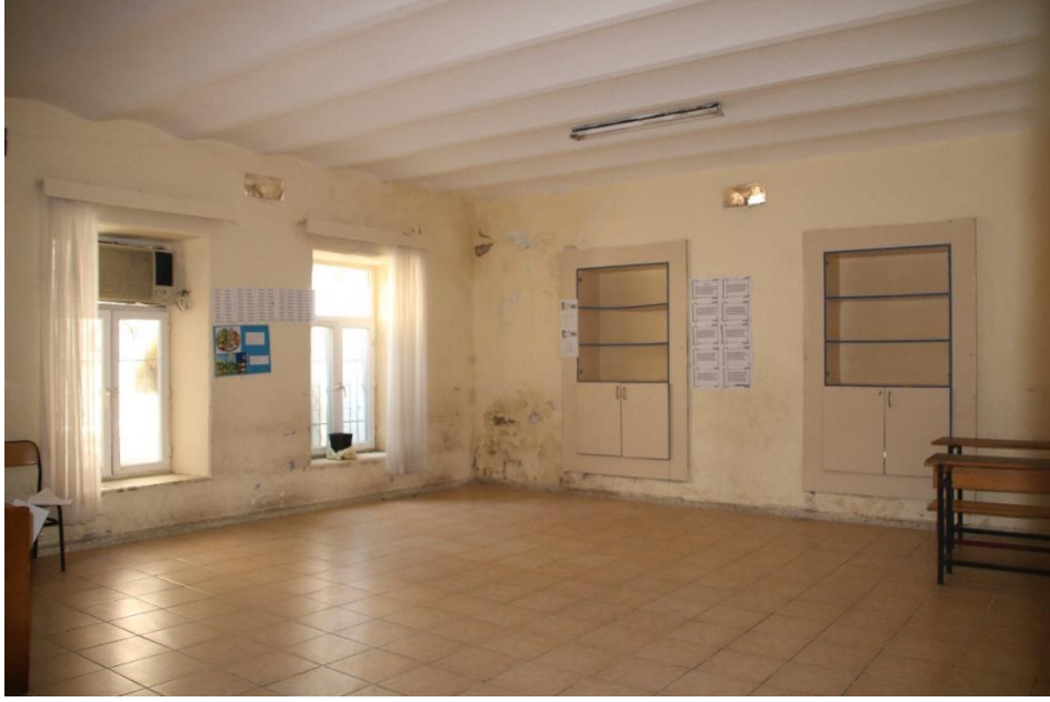
Resim 203: Zemin Kat Güneydoğu Derslik
