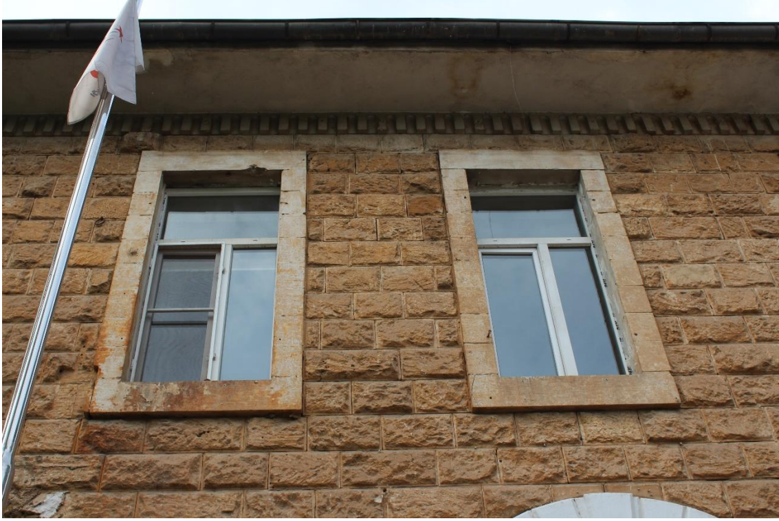
Resim 103: Yetimhane Birinci Kat Pencere Düzeni ve Saçak Altı Süsleme Detayı (Servet Özkan)
