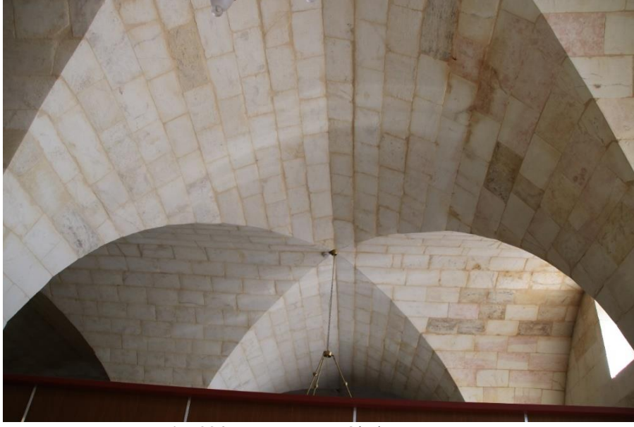
Resim 234: Hayganuşyan Okulu Tonoz Detayı (Servet Özkan)
