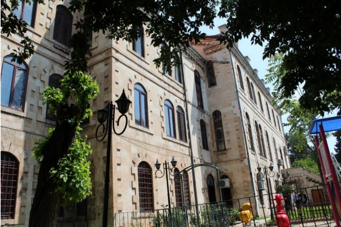
Resim 61: Yapının Güney Cephesi
