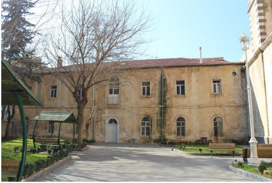
Resim 122: St. Joseph Erkek Okulunun Doğu Cephesi (Servet Özkan)
