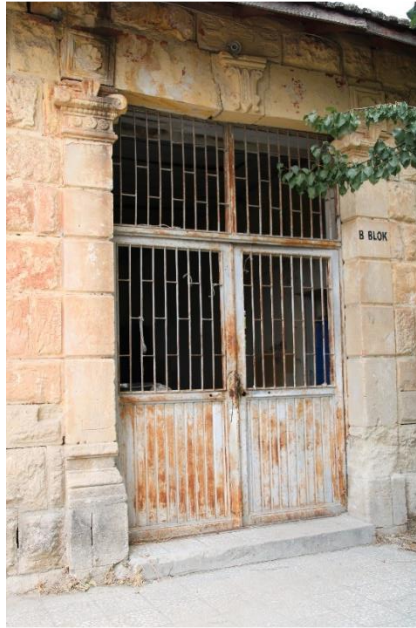
Resim 186: Okulun Giriş Kapısı (Müge Çiftyürek)
