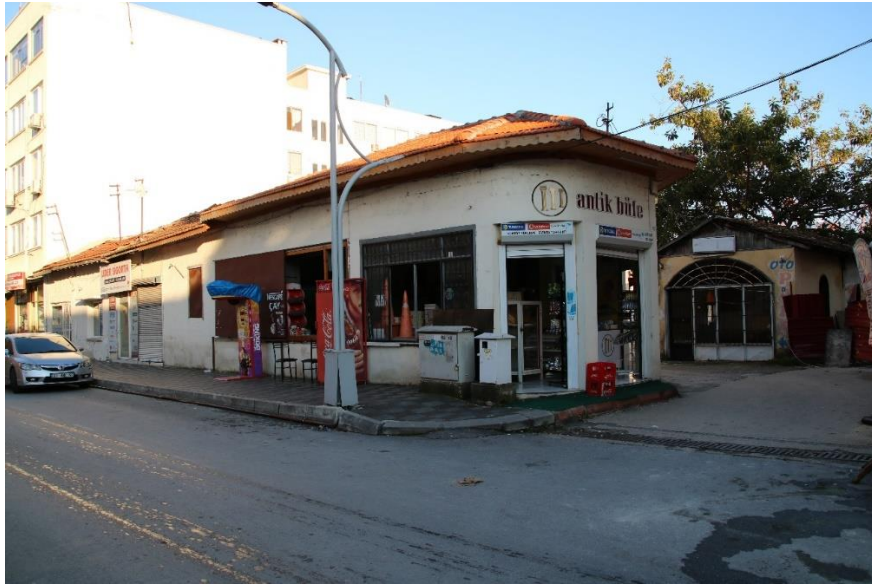
Resim 109: St. Antuan Erkek Okulu Kuzey ve Batı Cephesi (Servet Özkan)
