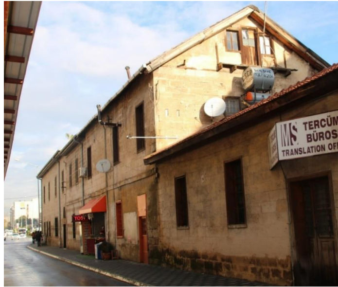
Resim 114: St. Joseph Kız Okulu'nun Batı (Sokak) Cephesi (Servet Özkan)
