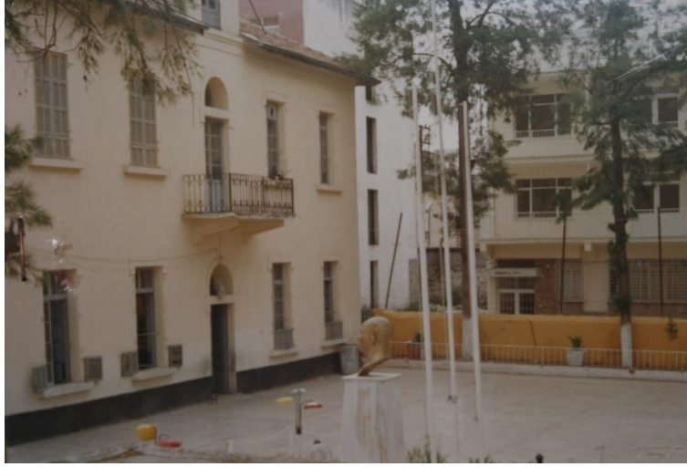
Resim 142: Yapının Kuzey Cephesini Gösteren Eski Bir Fotoğraf (Hatay Kültür Varlıklarını Koruma Kurulu Arşivi)
