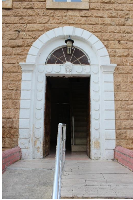
Resim 101: Yetimhane Giriş Kapısı (Servet Özkan)
