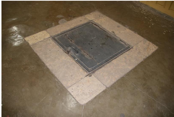
Resim 171: Zemin Kat Kuzeybatı Koridorun Zeminindeki Kapaklı Açıklık (Servet Özkan)
