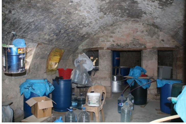
Resim 196: Yatakhane Binası Bodrum Katı (Servet Özkan)
