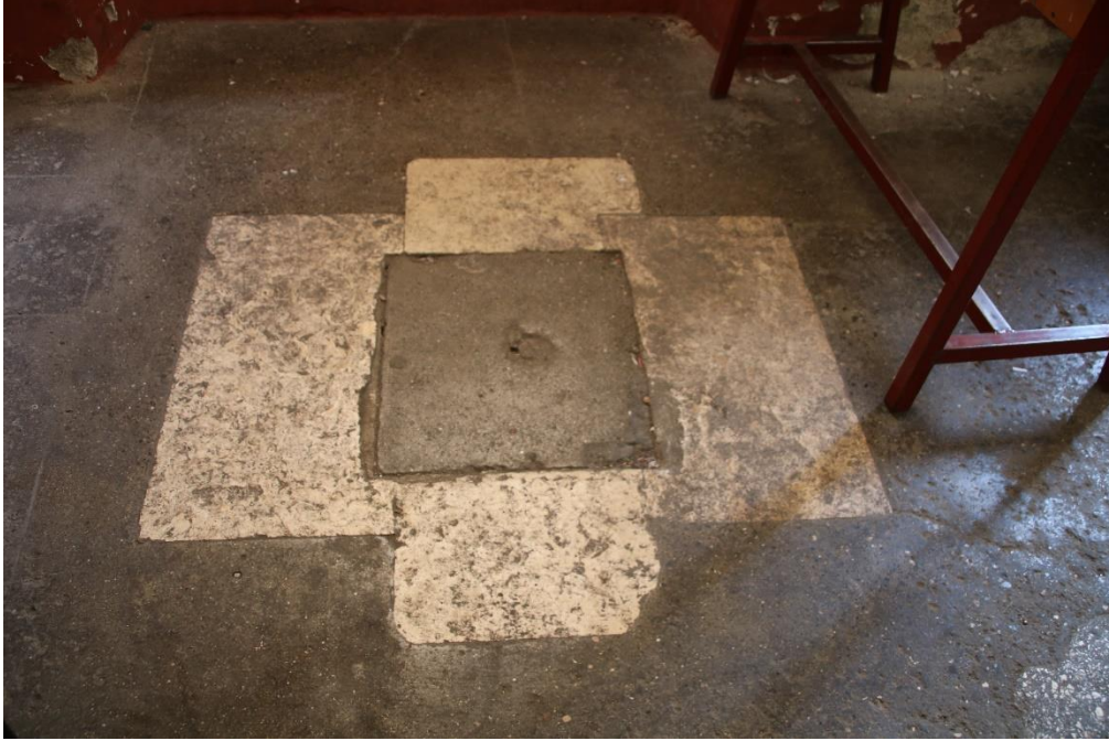
Resim 154: Avlunun Güneybatısındaki Derslik Zemininde Bulunan Kapaklı Açıklık (Servet Özkan)
