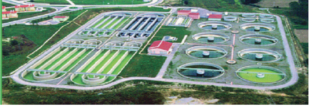
Şekil 7. Sakarya Karaman Atıksu Arıtma Tesisi
