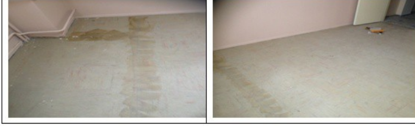
Şekil 9. Atölye zeminine mineflo kaplanmadan önceki hali 13 Kasım 2013
