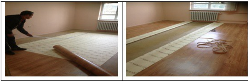
Şekil 10. Atölye zeminine mineflo döşemesi yapılırken 22 Kasım 2013
