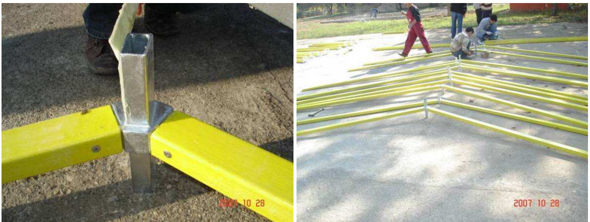
Şekil 80. CTP profillerin mahya birleştirme elemanlarına montajı
