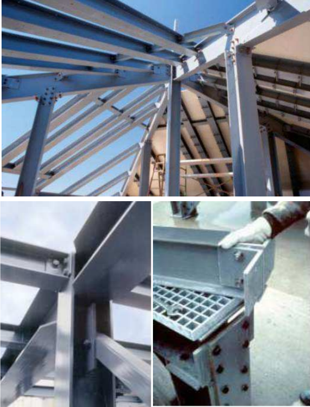
Şekil 61. CTP birleştirme detay uygulamaları
