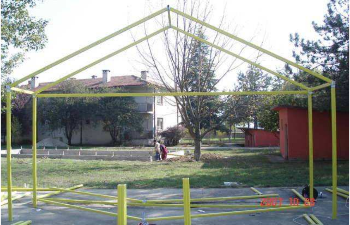
Şekil 83. CTP seranın çerçeve sistemlerinin oluşturulması
