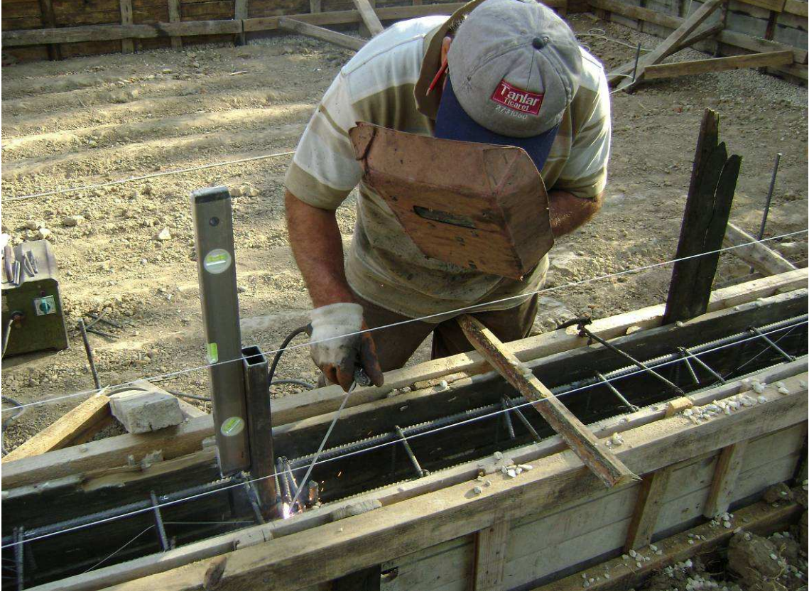
Şekil 73. Çelik kutu profillerin temele ankraji
