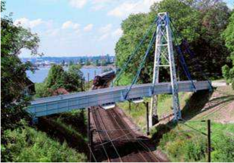
Şekil 24. CTP yaya ve hafif araç köprüsü
