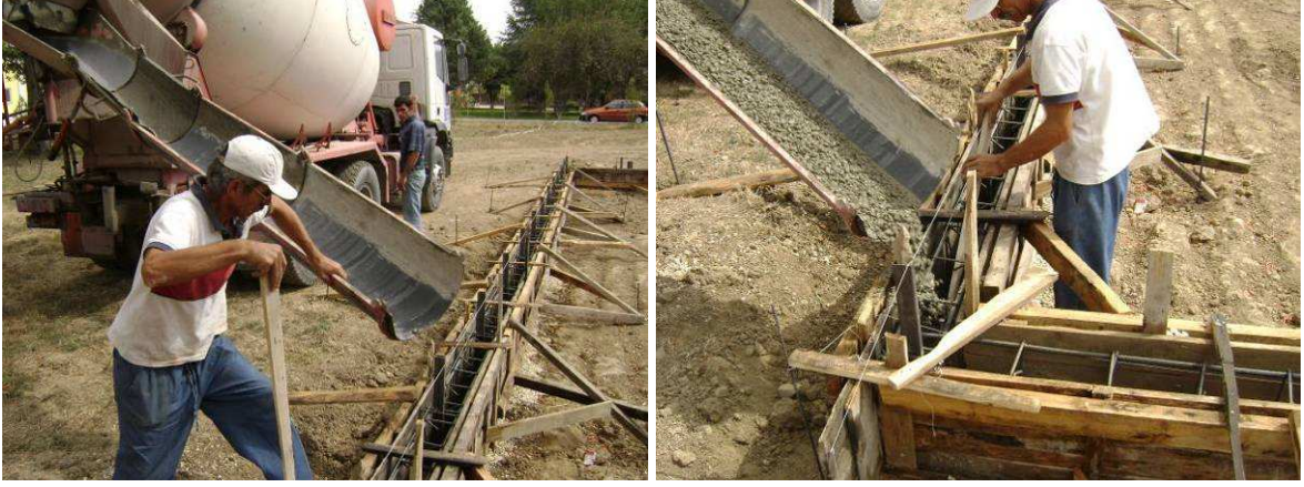
Şekil 75. Sera temel betonun dökümü
