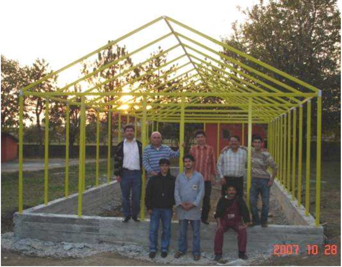
Şekil 88. Taşıyıcı kısmı tamamlanan CTP seranın ön görünüşü
