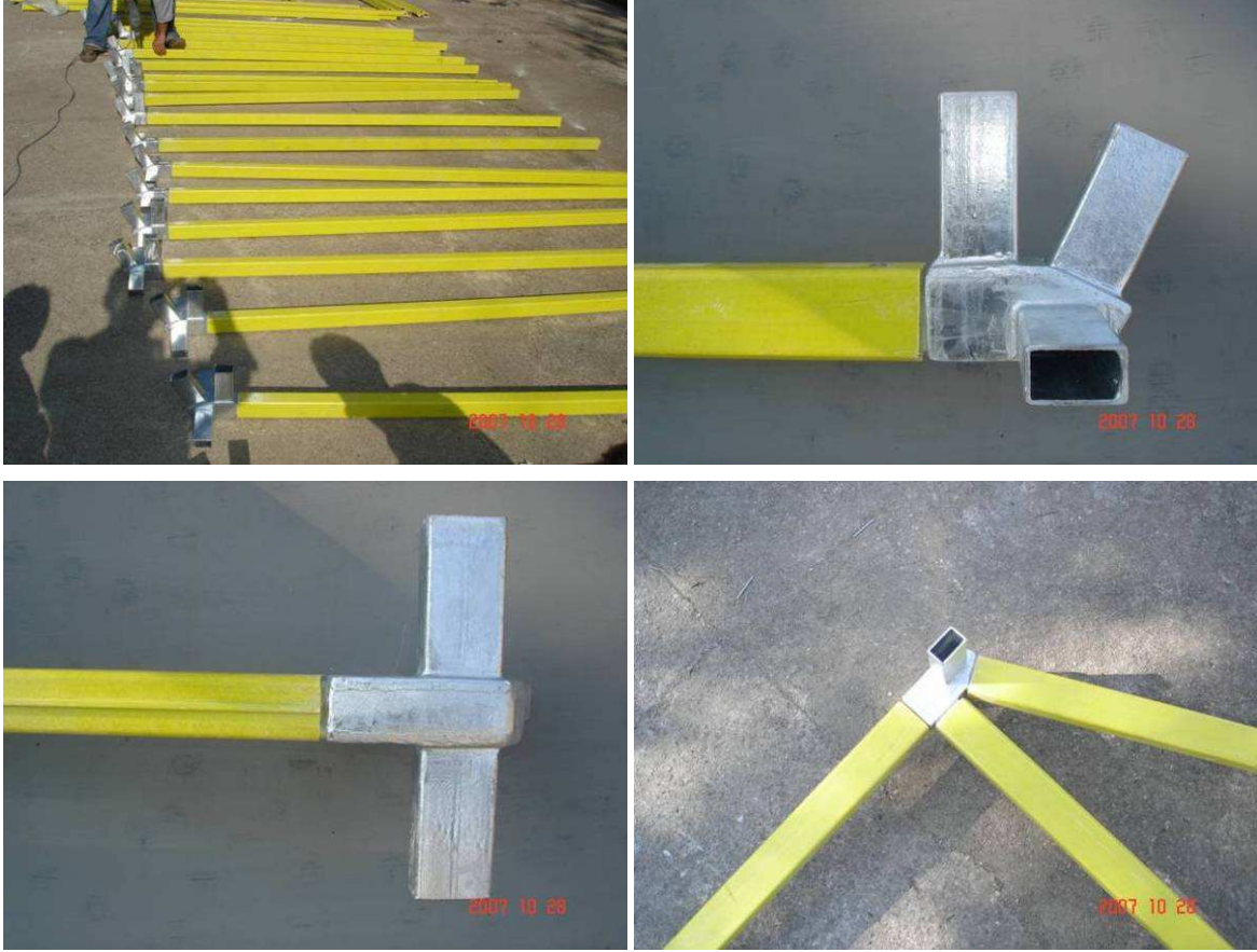
Şekil 79. CTP profillerin kolon-çatı birleştirme elemanlarına montajı
