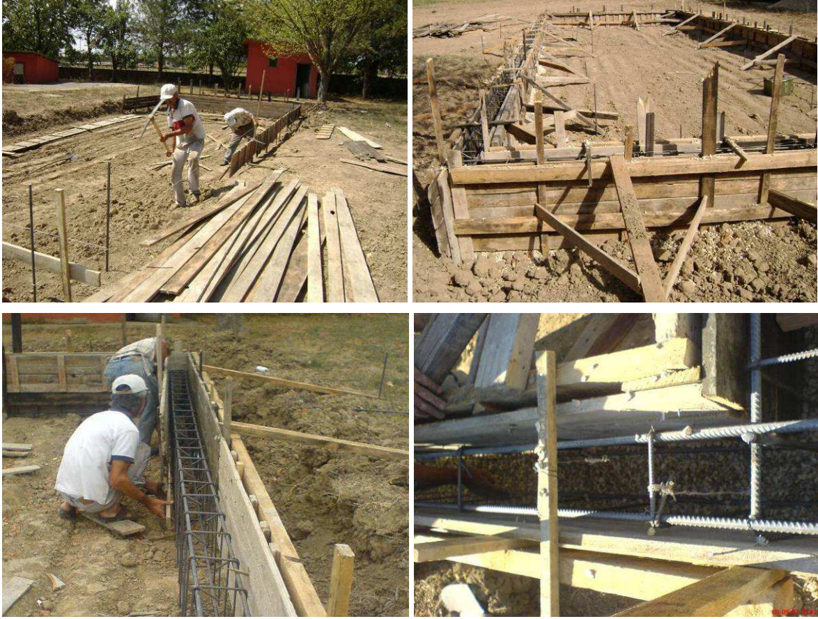
Şekil 72. Sera temel kalıbı hazırlanması ve demir donatının bağlanması
