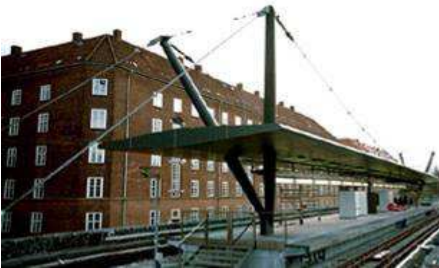
Şekil 23. CTP metro istasyonu
