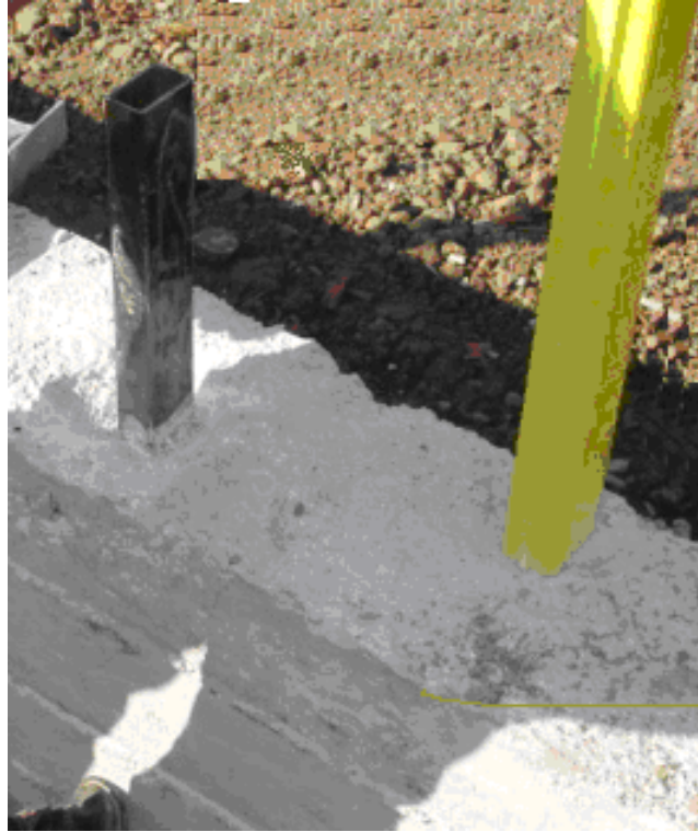
Şekil 70. CTP sera kolon-temel birleştirme
