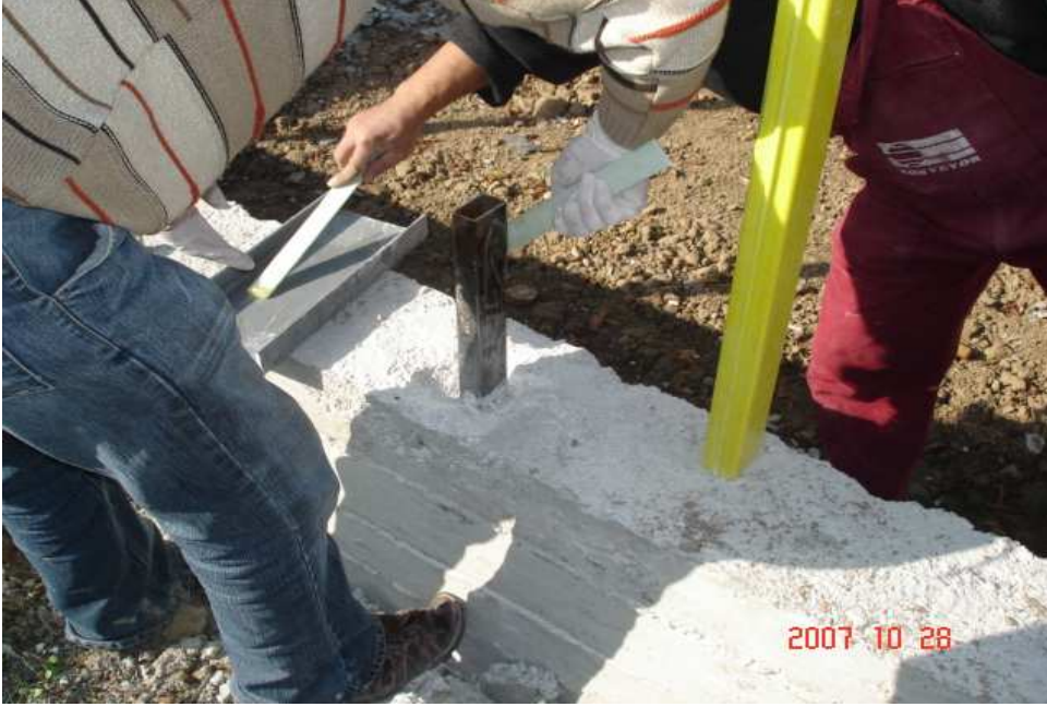
řekil 81. elik profil yzeylerine ift karıřımlı epoksi reine srlmesi
