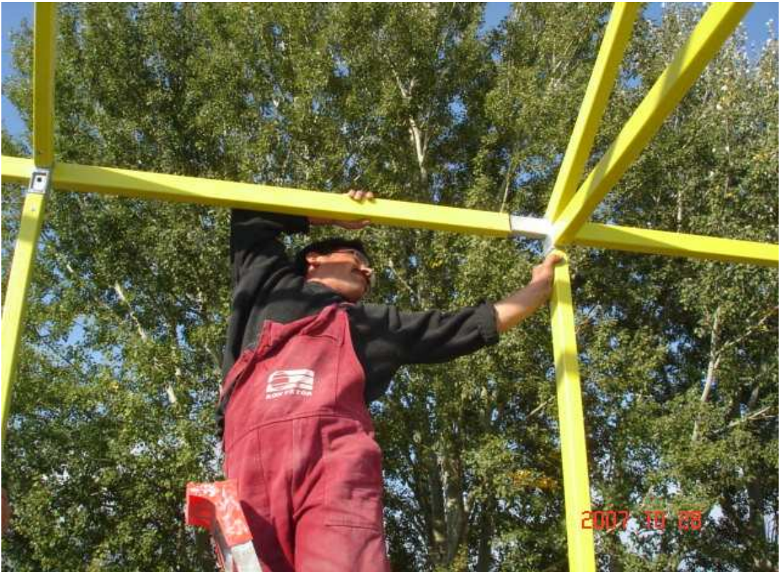
Şekil 86. Çerçeve aralarında kalan damlalık aşığı ve mahyaların montajı
