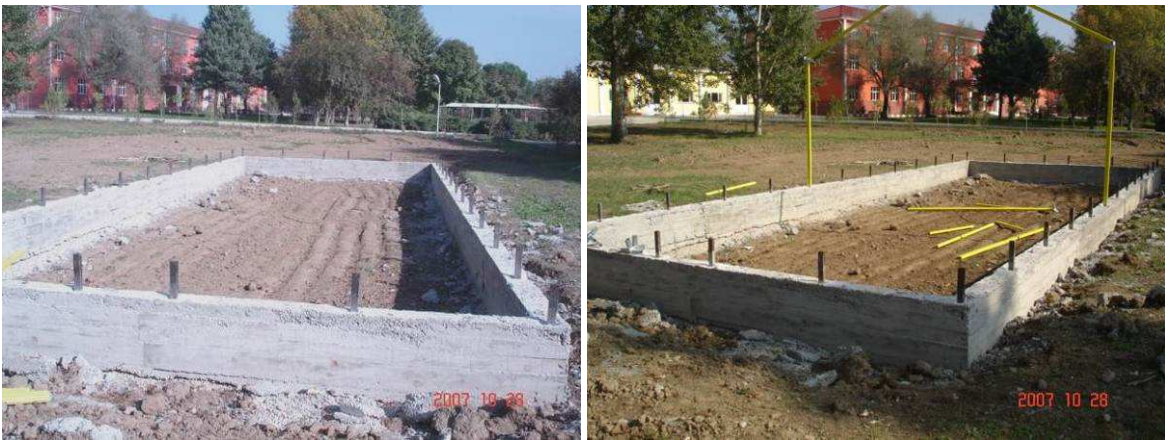
Şekil 77. Kalıbı sökülmüş temel betonu
