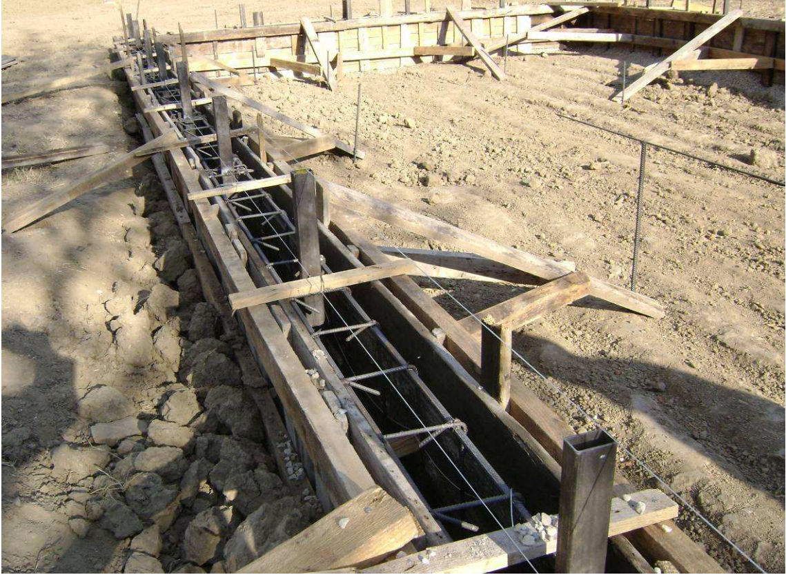
Şekil 74. Çelik kutu profillerin donatıya ankraji
