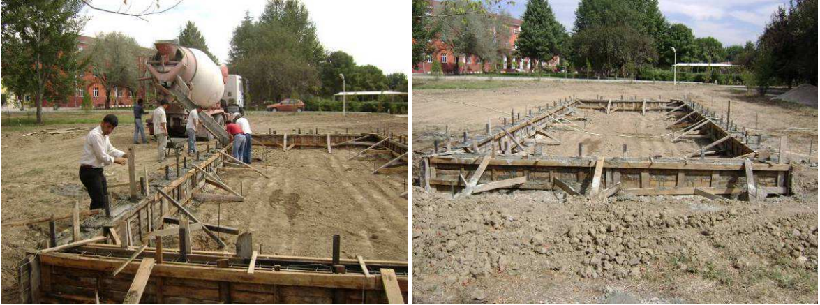
Şekil 76. Sera temel sıkıştırılması ve tesviye edilmesi
