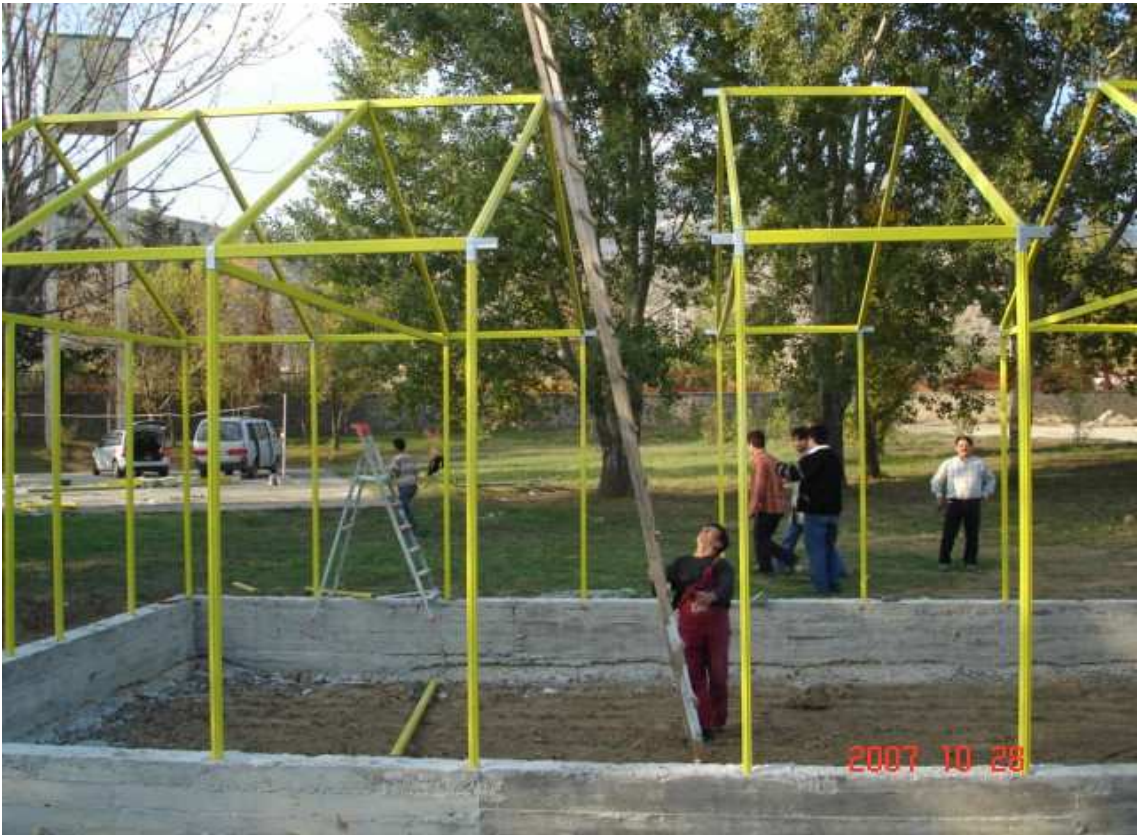
Şekil 85. CTP sistemlerinin taşınması ve kolonların temele montajı
