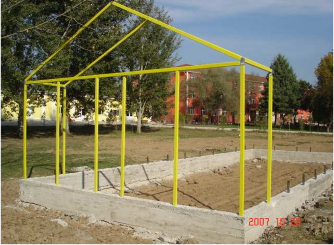
Şekil 84. CTP çerçeve sistemlerin taşınması ve kolonların temele montajı
