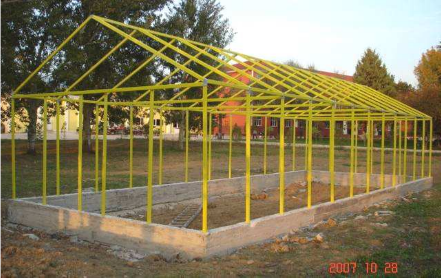
Şekil 87. Taşıyıcı kısmı tamamlanmış seranın yan görünüşü
