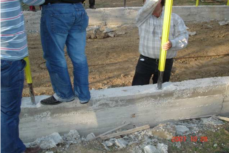
řekil 82. Kolonların temele montajının yapılması
