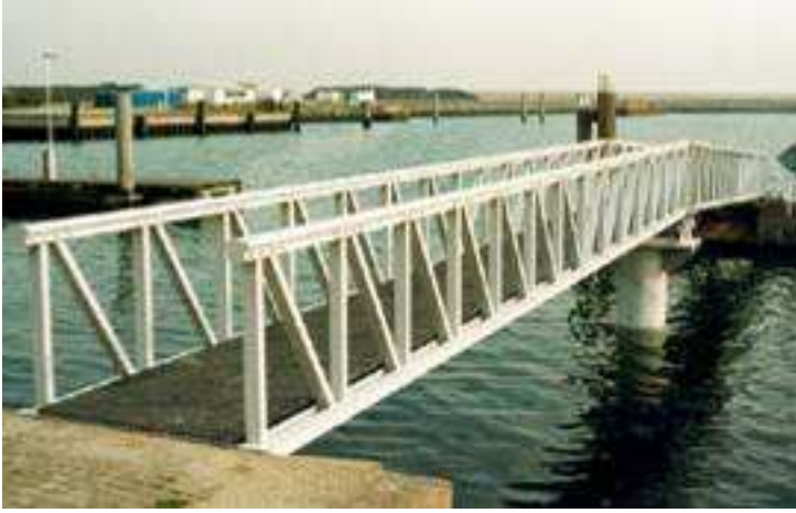
Şekil 22. CTP vapur iskelesi
