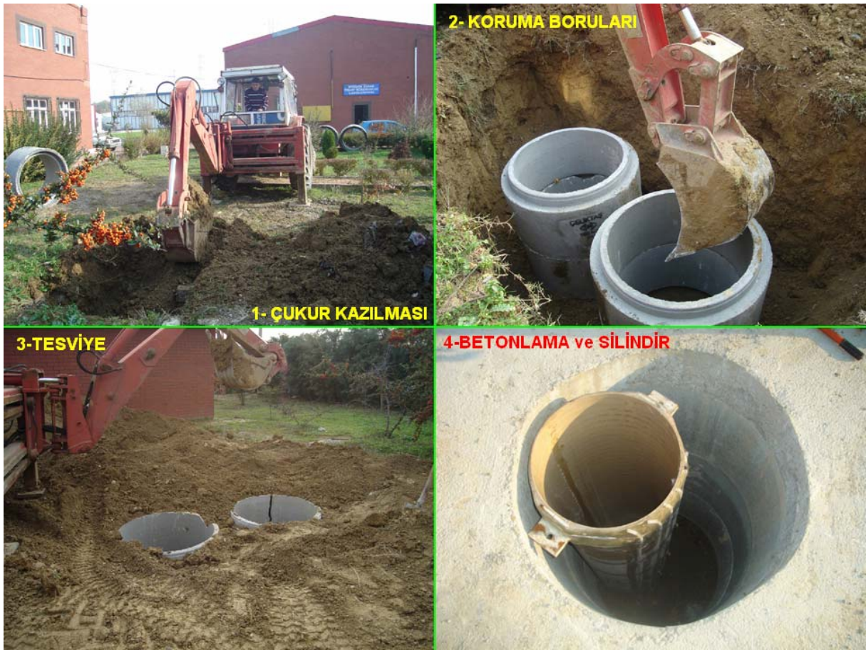
Foto 16. Silindirin yerleştirme aşamaları
