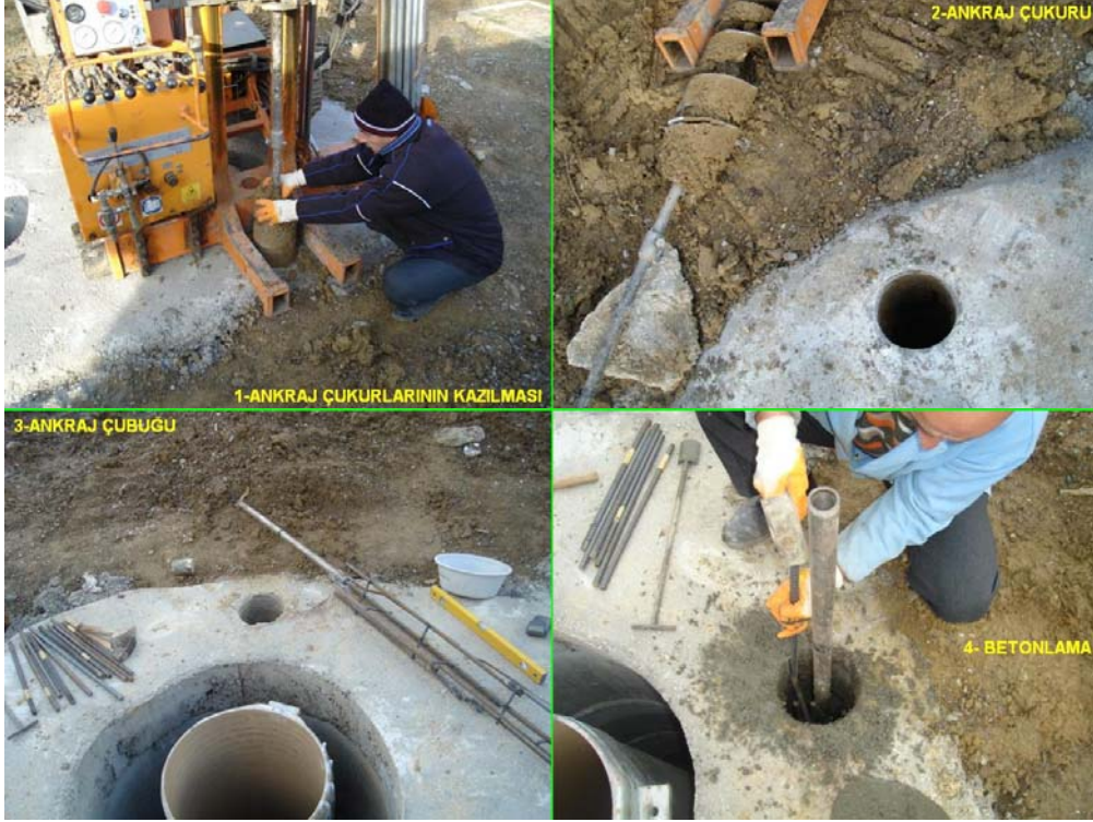
Foto 18. Yüklemeye kiriş için reaksiyon ankrajlarının hazırlanması
