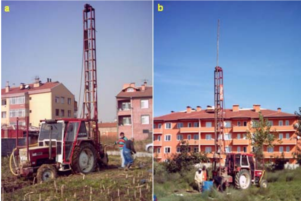
Foto 1. a) STYG04 ve b) STYG01 nolu araştırma sitelerinde sondaj çalışmaları
