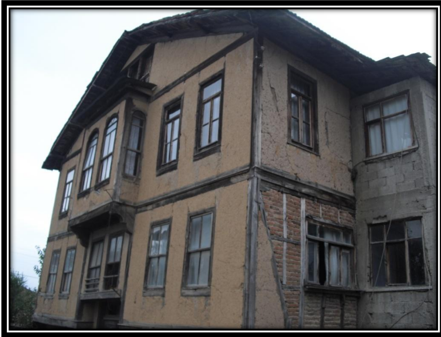
Resim 161: Hendek, İrfan Soylu Evi Çatı Örneği
