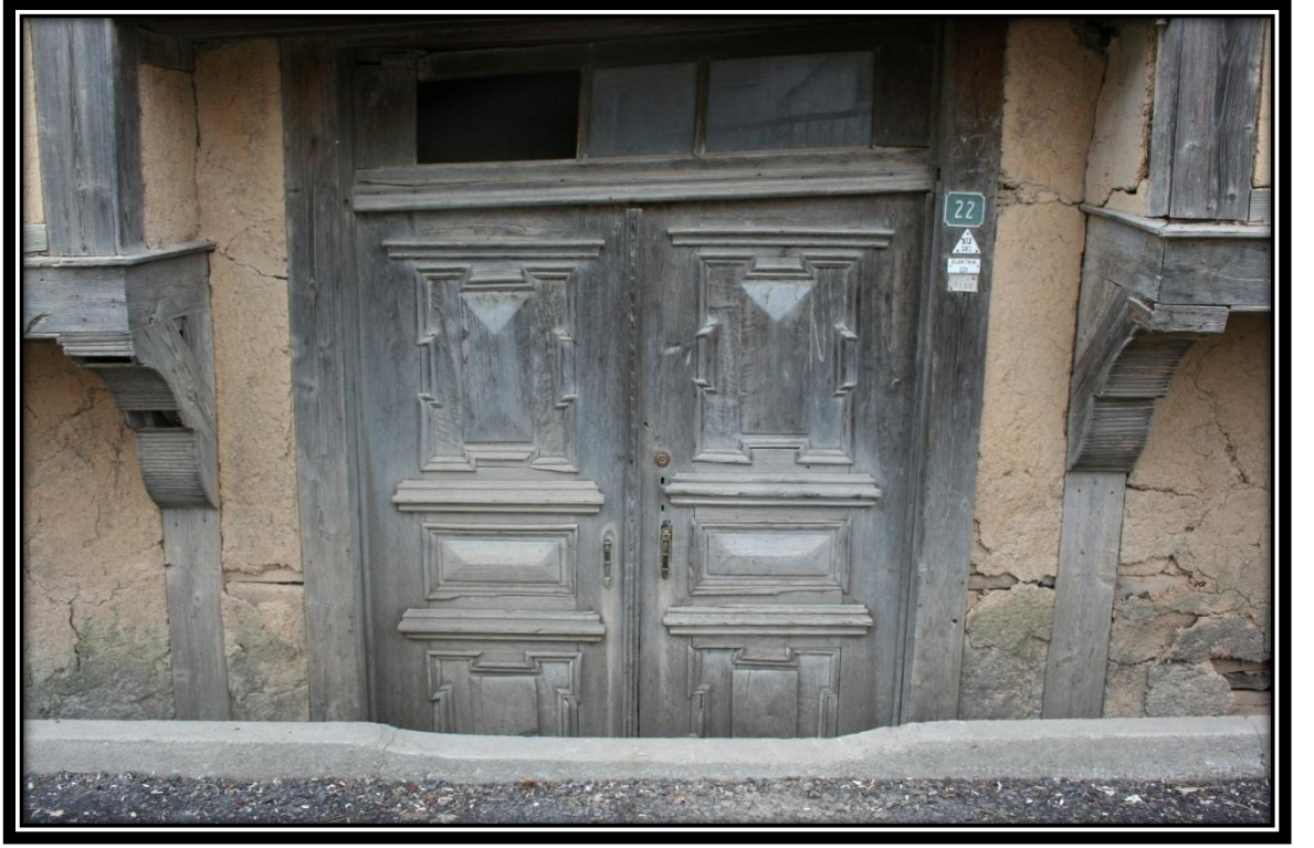
Resim 51: İrfan Soylu Evi; Doğu Dış Cephe Ana Giriş Kapı Detayı
