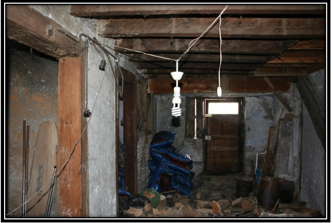
Resim 119: Sedat Tavşancı Evi; Zemin Kat Güney Girişi
