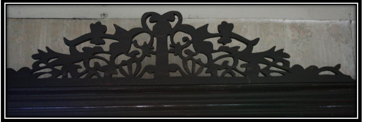
Resim 129: Sedat Tavşancı Evi; Kuzey Cephesi 1.Kat Oda Pencere Alınlığı
