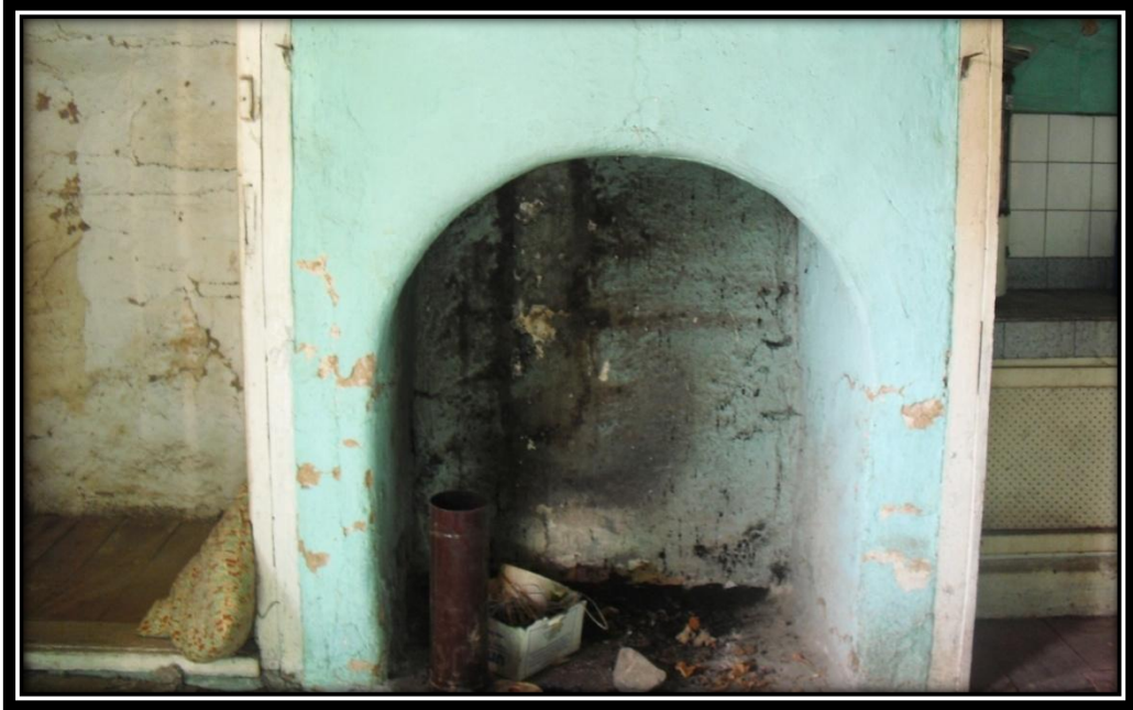
Resim 108: Temel Yıldız Evi, Güney Cephesi Zemin Kat Mutfak
