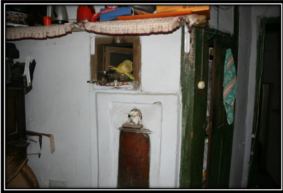
Resim 154: Ali Soylu Evi; Zemin Kat Batı Cephesi Banyo
