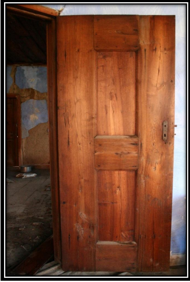
Resim 84: Mehmet Başel Evi; 2.Kat Güney Cephesi Oda Kapısı
