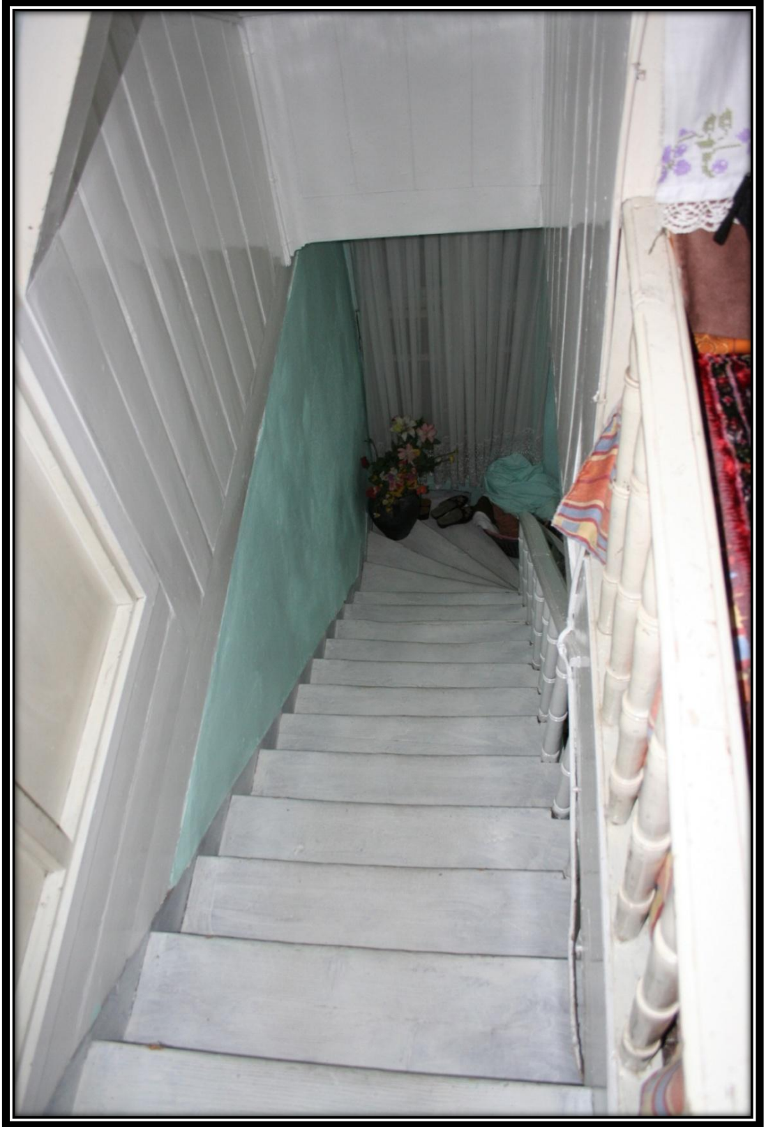
Resim 150: Ali Soylu Evi; 1.Kattan Çatı Katına Çıkış Merdiveni
