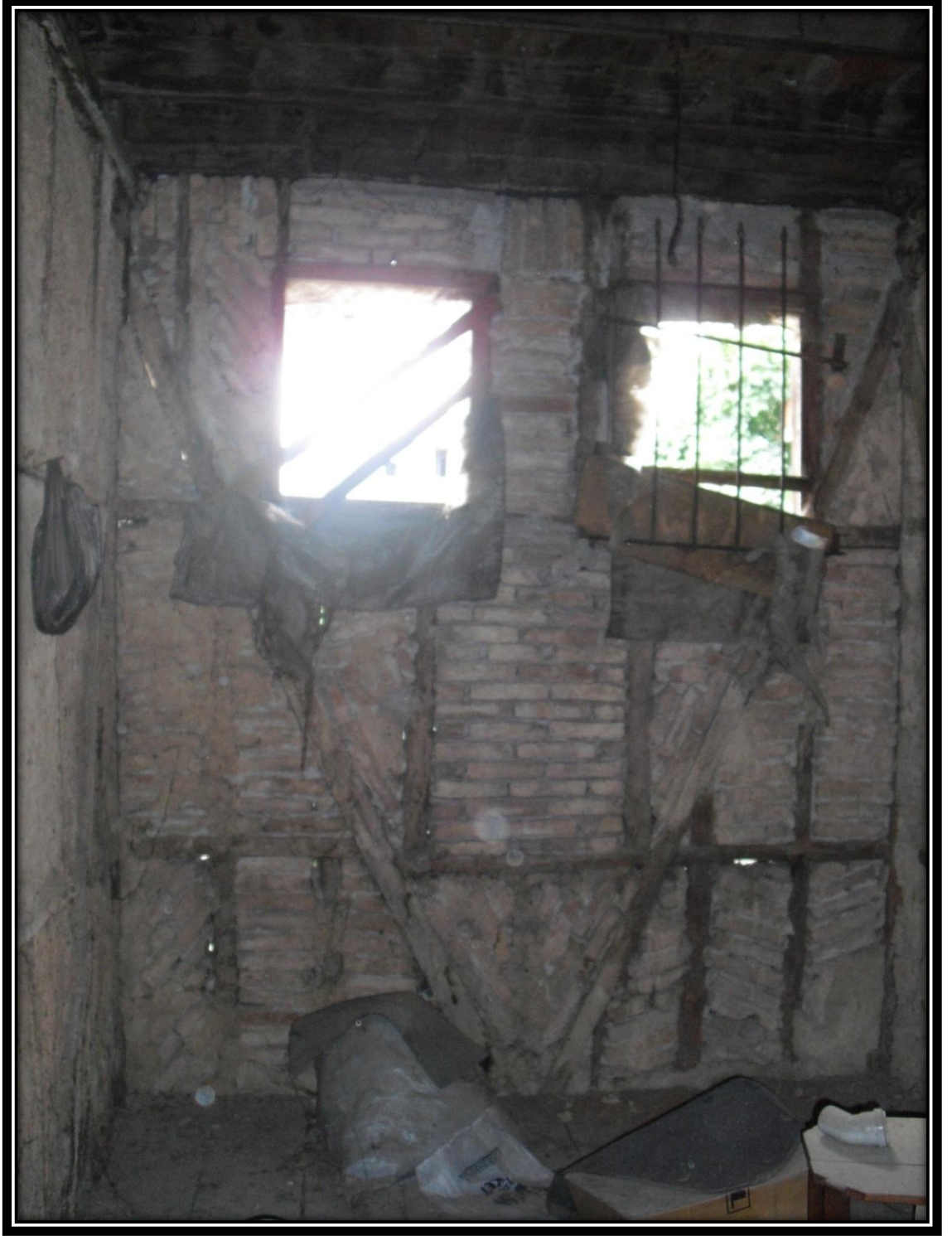
Resim 137: Rabia Acar Evi; Batı Cephesi Odası
