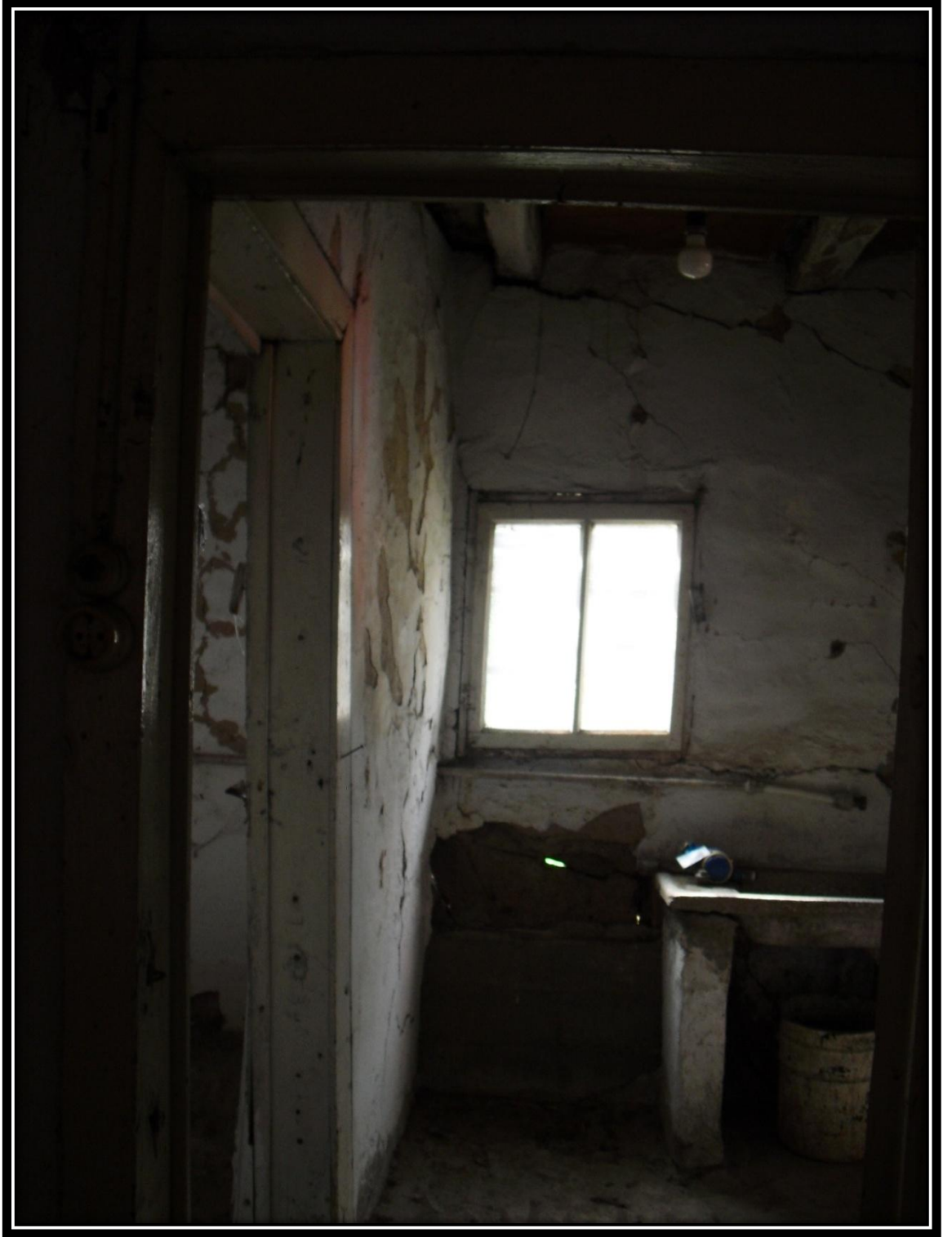
Resim 111: Temel Yıldız Evi; Güney Cephesi Zemin Kat Lavabo
