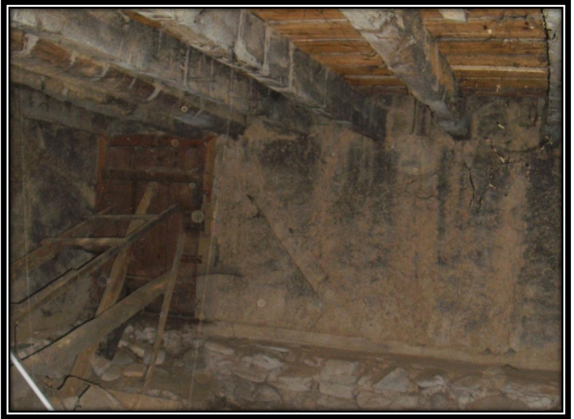
Resim 38: Cüneyt Öztan Evi; Zemin Kattan 1. Kata Çıkış Merdiveni
