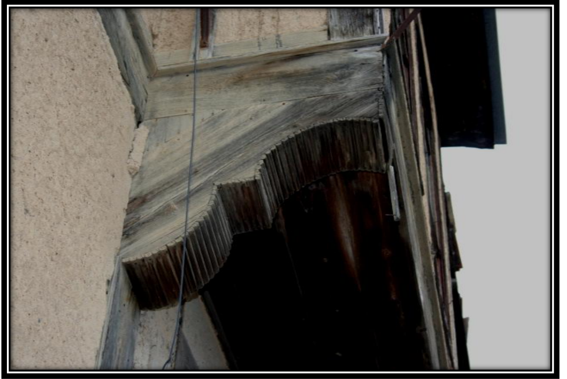
Resim 52: İrfan Soylu Evi; Güney Doğu Dış Cephe Cumba Altı Eli Böğünde Detayı
