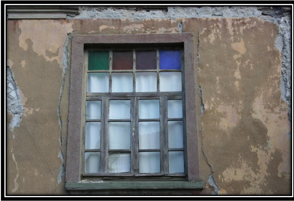
Resim 116: Sedat Tavşancı Evi; Batı Cephesi Pencere Detayı
