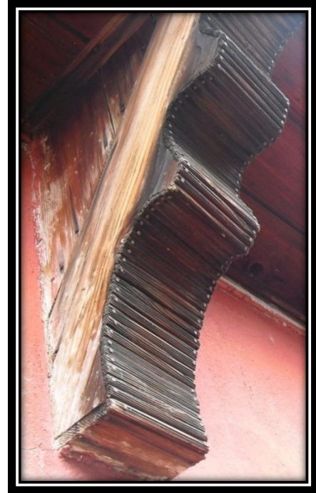
Resim 99: Sabahat Büyüktaş Evi Güney Cephesi Saçak Altı Eli Böğründe
