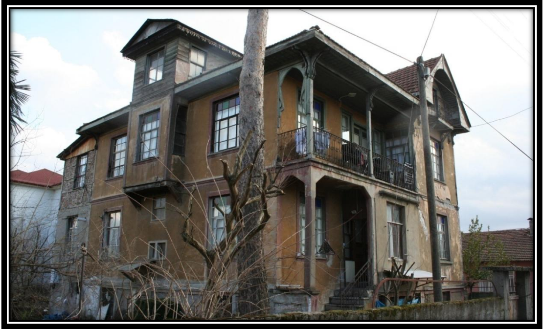
Resim 114: Sedat Tavşancı Evi; Doğu ve Güney Dış Cephesi
