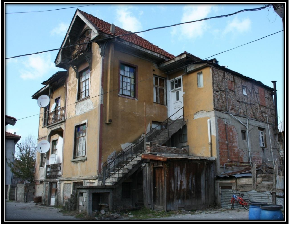
Resim 115: Sedat Tavşancı Evi; Batı Cephesi
