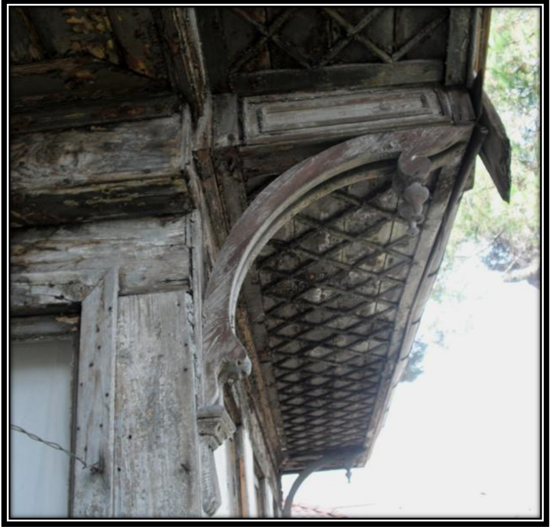
Resim 14: Mustafa Asım Konađı; Dođu Cephesi Saçak Altı Ahşap Süsleme
