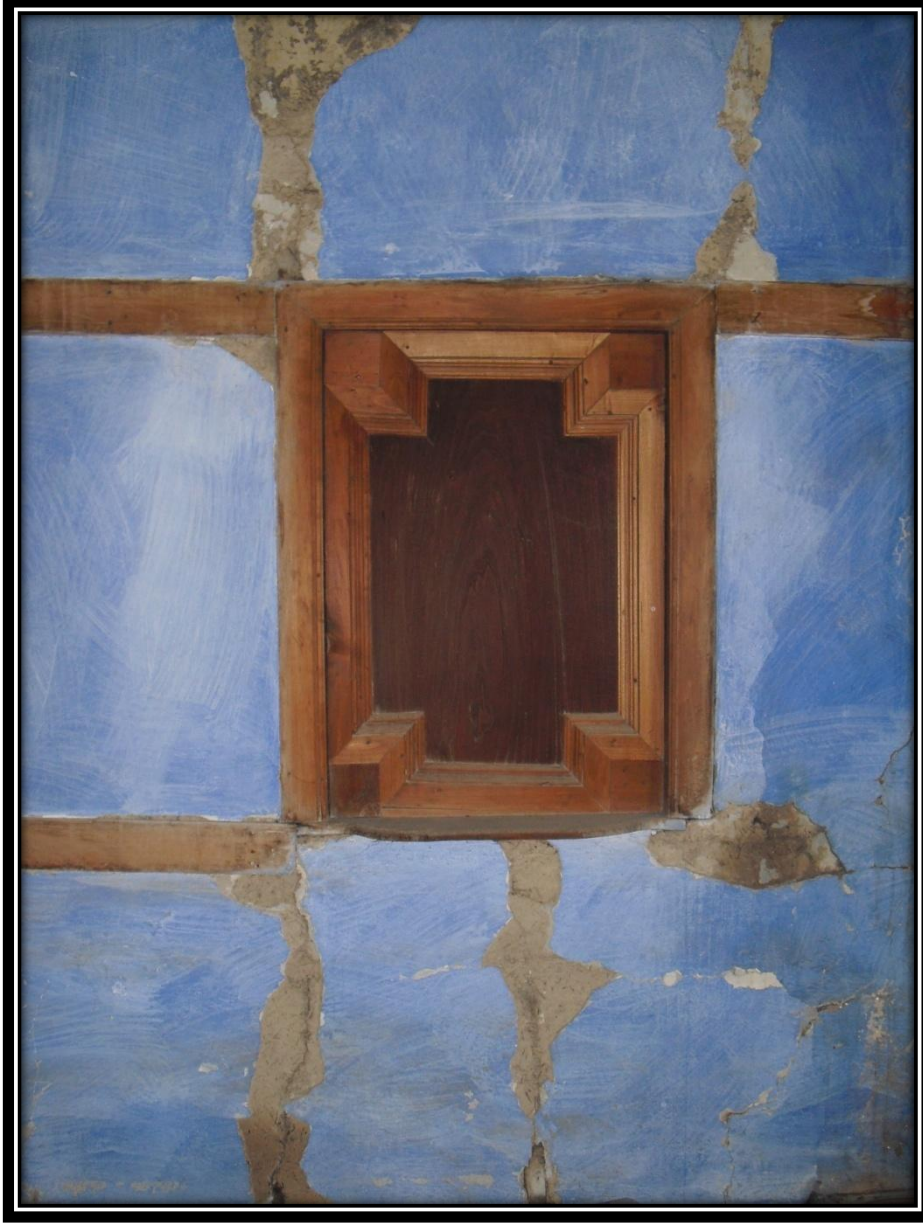
Resim 169: Duvar Nişi Örneği, Hendek (Mehmet Başel Evi)
