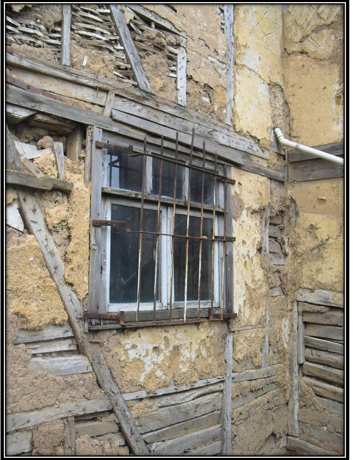
Resim 105: Temel Yıldız Evi; Batı Cephesi Malzeme ve Pencere Detayı
