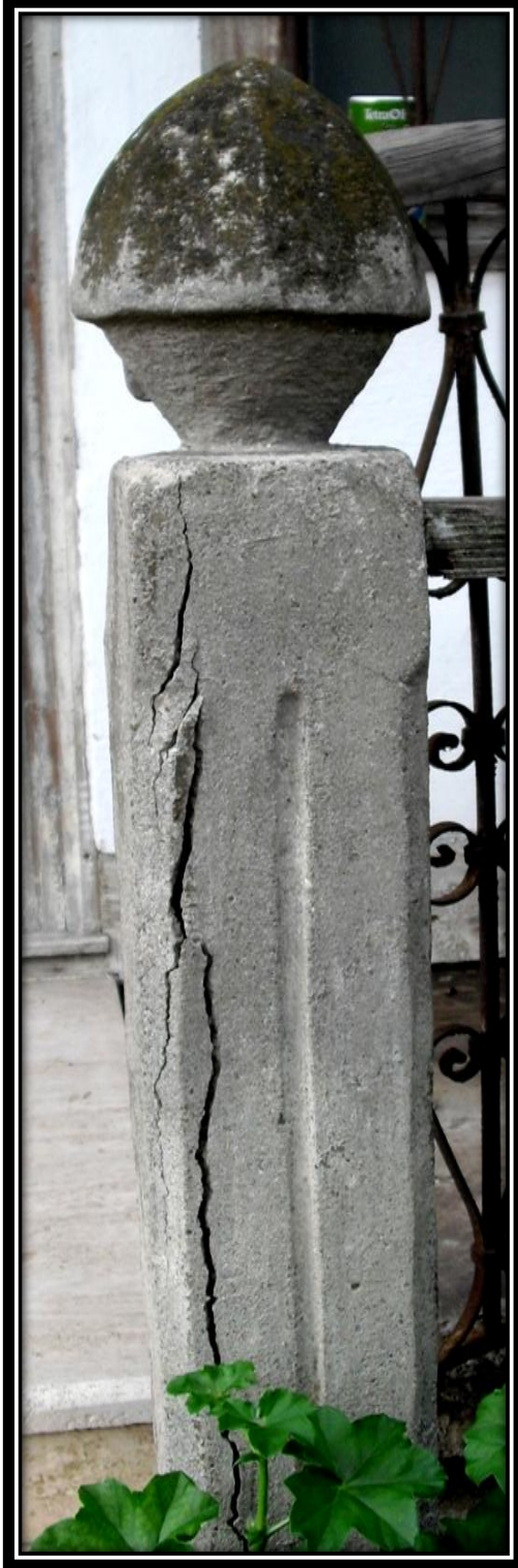
Resim 15: Mustafa Asım Konađı; Dođu Cephesi Balkon Korkuluđu
