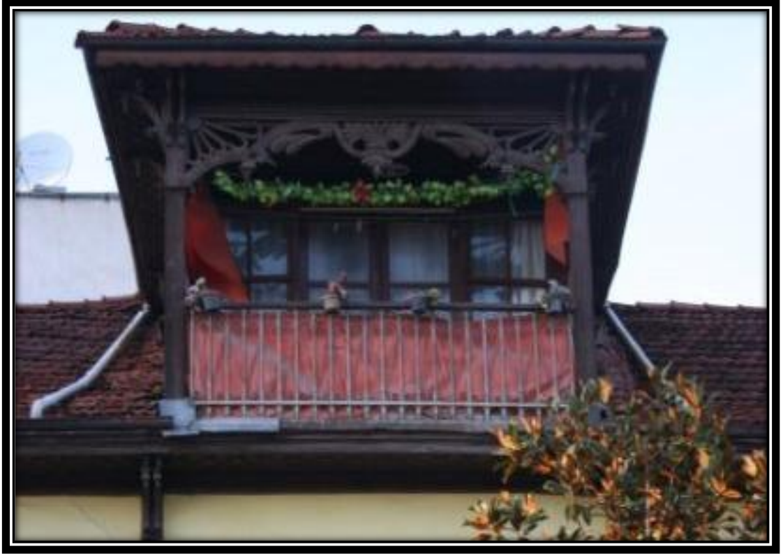
Resim 141: Ali Soylu Evi; Doęu Cephesi Balkon
