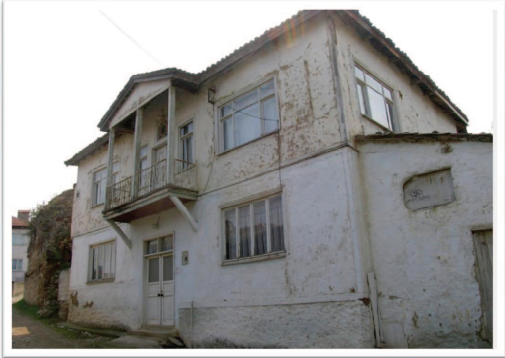
Resim 14. 2. Kasım Çavuş evi doğu ve kuzey cephesi
