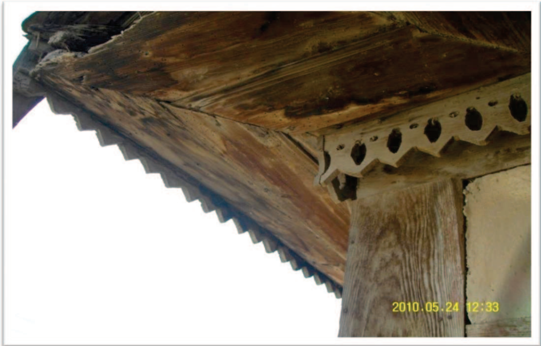
Resim 12. 4. İdris Öztürk evi doğu cephesi saçak detayı
