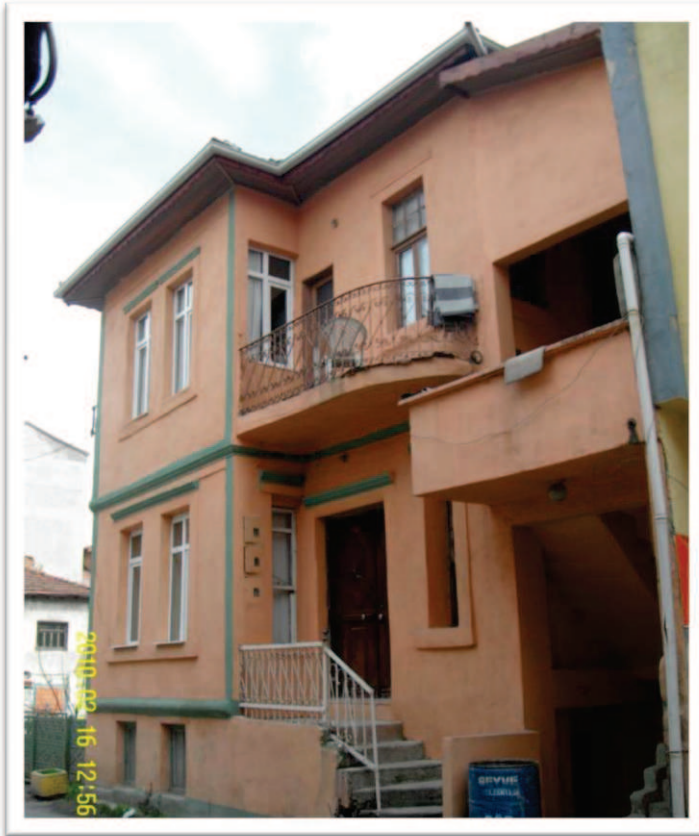
Resim 6. 2. Avukat Cemalettin evi kuzey cephesi
