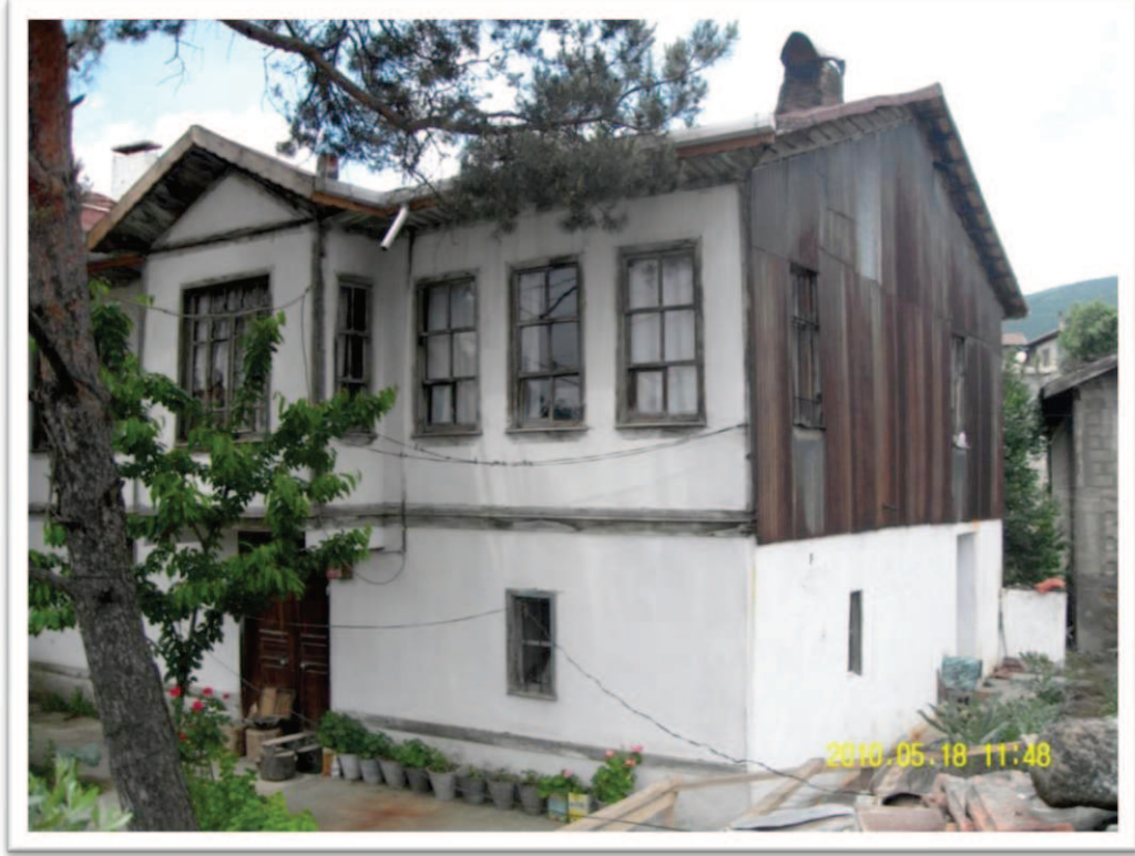
Resim 7. 3. Ali Rıza Tarakçıođlu evi dođu ve kuzey cephesi
