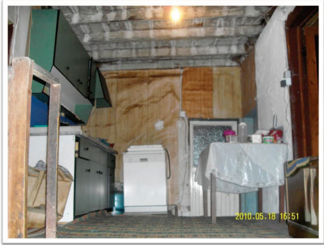
Resim 11. 7. Necmi Araz evi zemin kat
