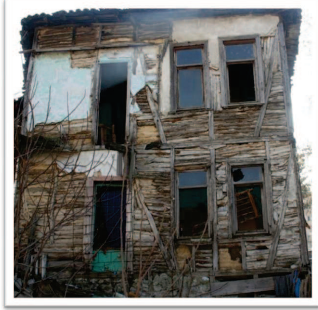
Resim 28. Meryem Boğcan evi, ahşap çatkı arası ahşap dolgu duvar (Sapanca)
