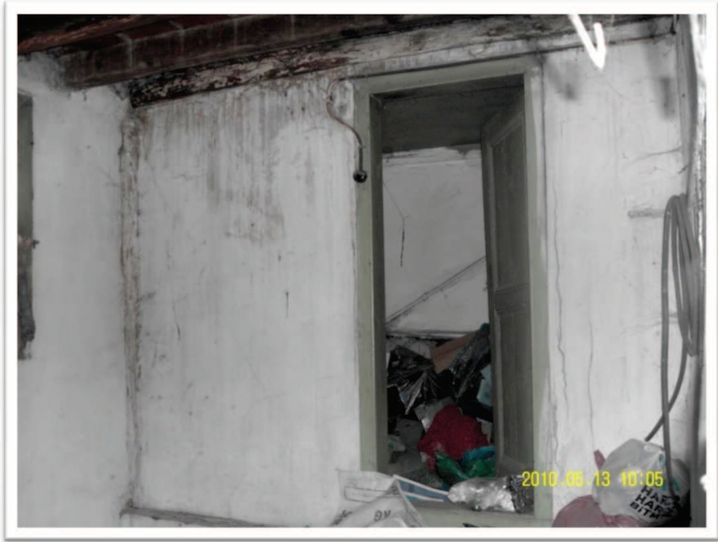
Resim 5. 11. Şaban Çakır evi zemin kat hamam bölümü
