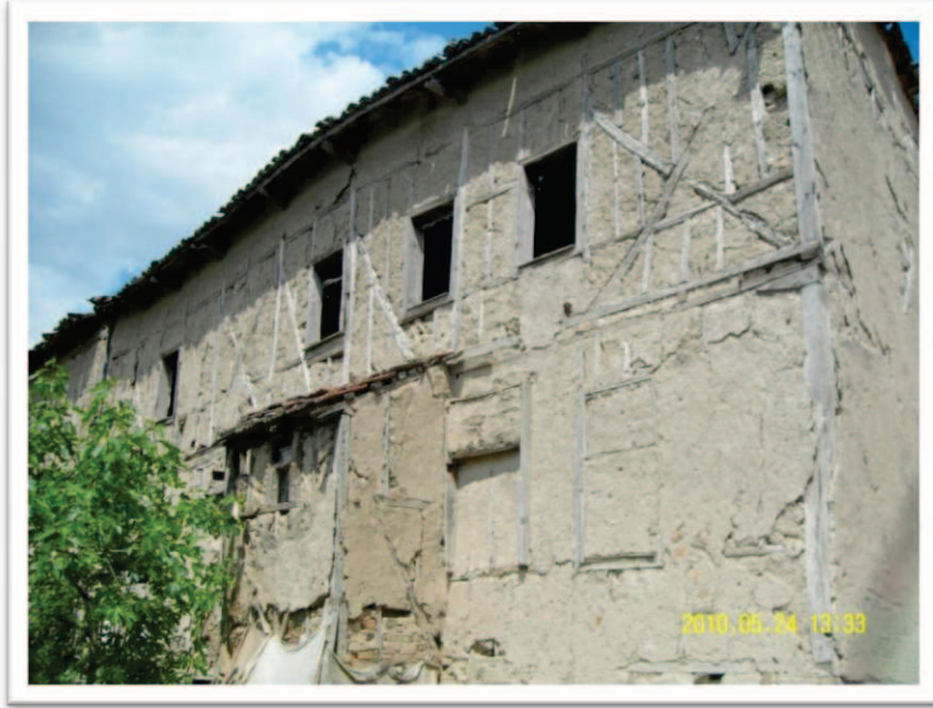
Resim 37. Ahşap çatkı arası kerpiç dolgu, İdris Öztürk evi (Bayat köyü-Geyve)
