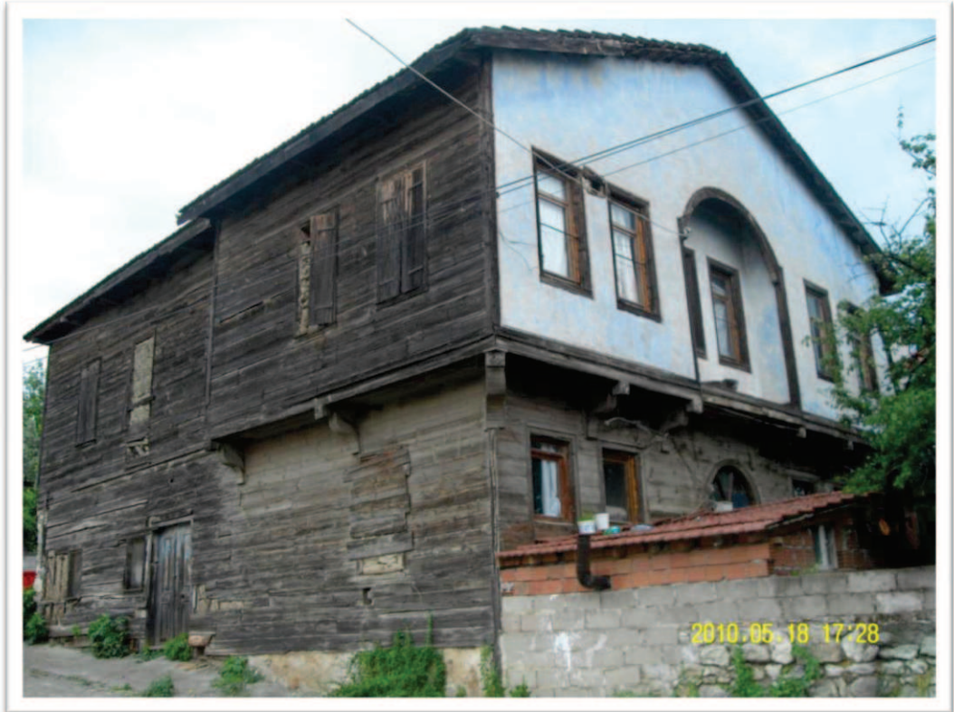
Resim 11. 2. Necmi Araz evi batı ve güney cephesi
