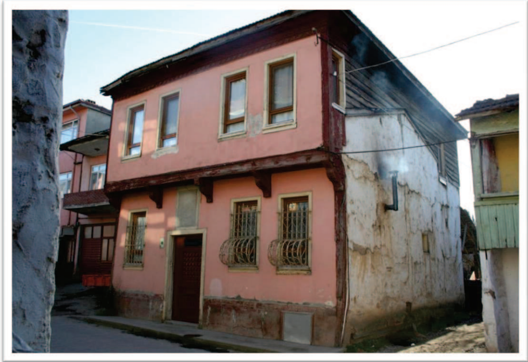
Resim 4. 2. Yüzbaşı Ali evi doğu ve kuzey cephesi
