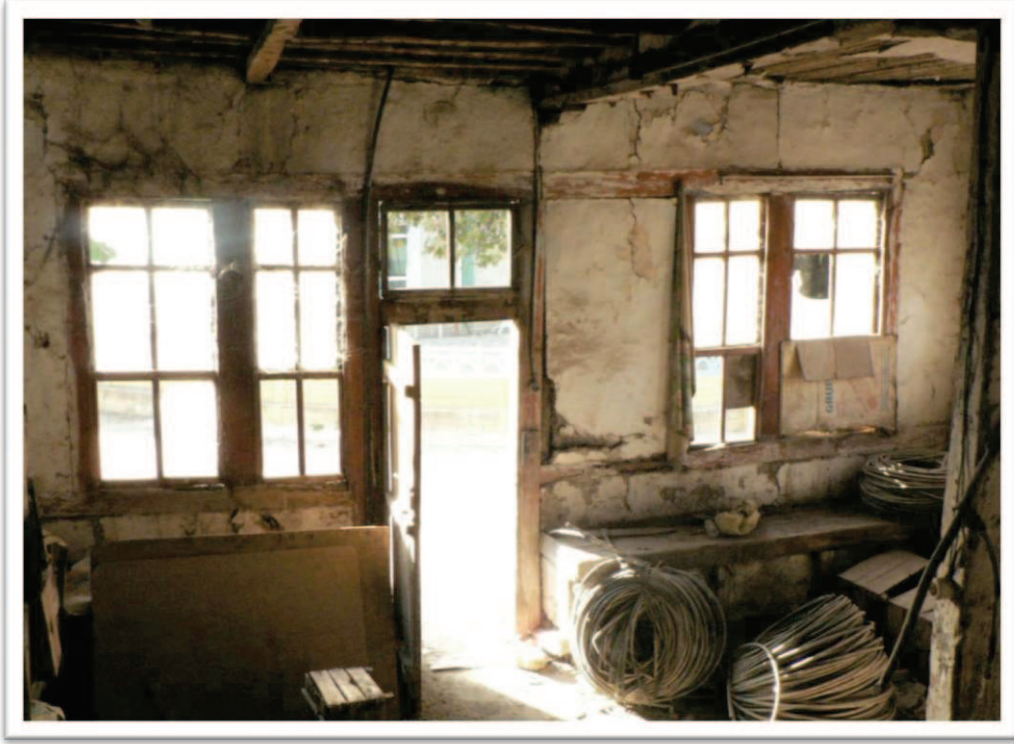
Resim 10. 5. Şakir Oktay evi zemin kat dükkân
