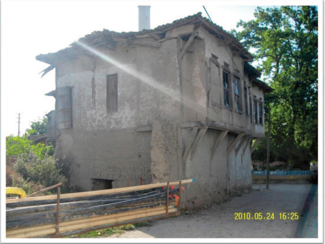
Resim 9. 4. Ali Rıza Oktay evi güney cephesi
