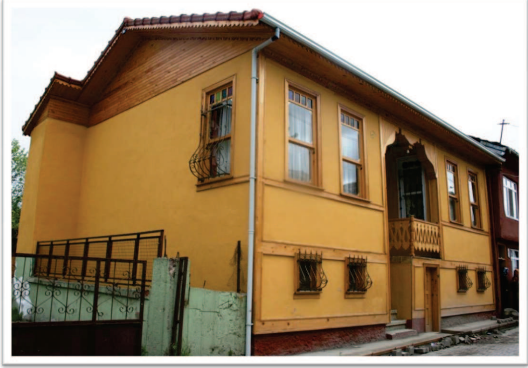
Resim 3. 3. Rıza Bey evi batı ve kuzey cephesi onarım görmüş hali
