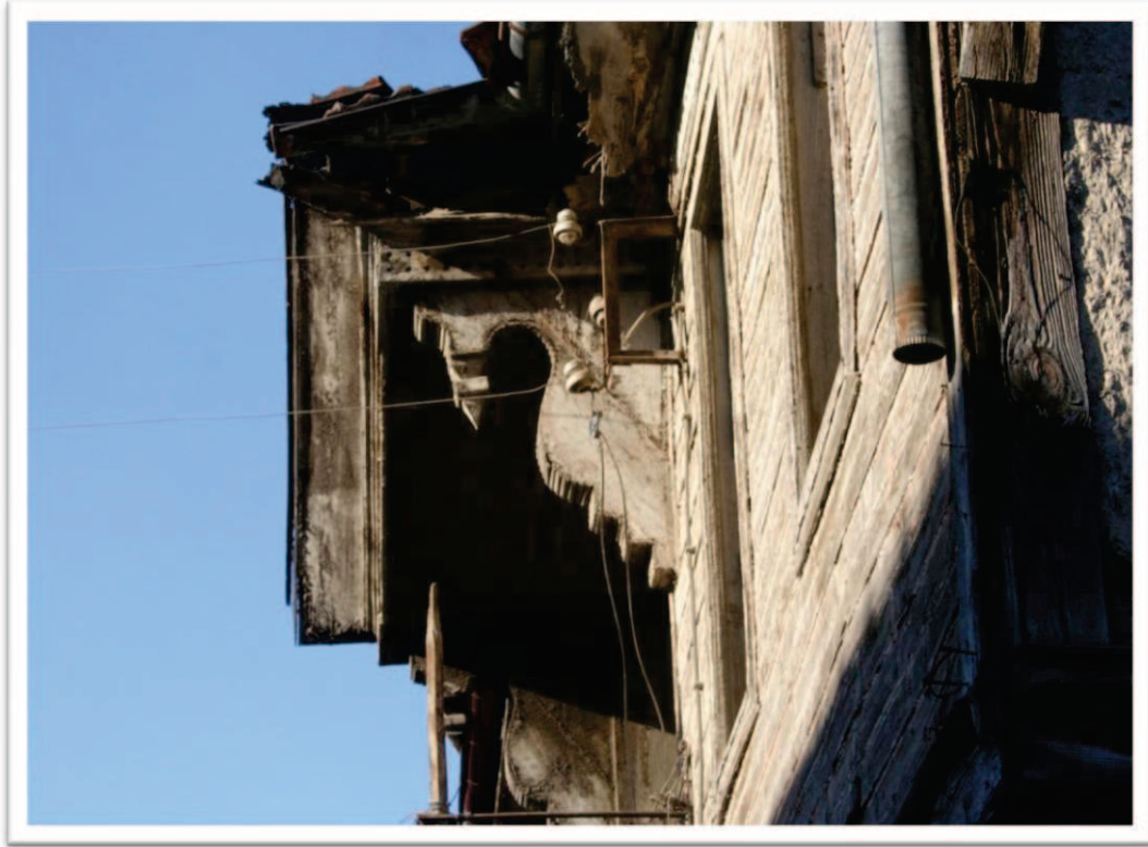
Resim 5. 4. Şaban Çakır evi giriş cephesi çıkma ve saçaklar
