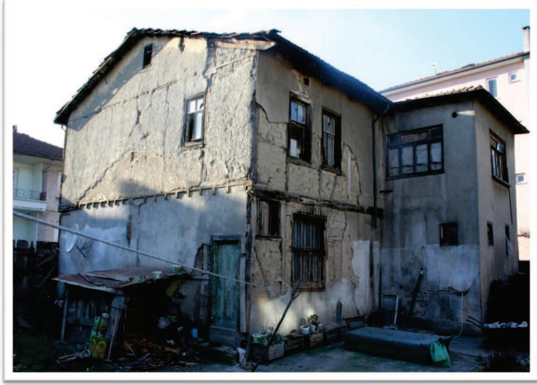
Resim 5. 3. Şaban Çakır evi doğu ve güney cephesi
