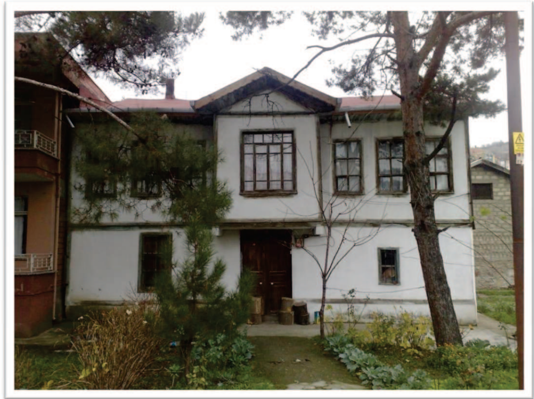
Resim 7. 2. Ali Rıza Tarakçıođlu evi dođu cephesi
