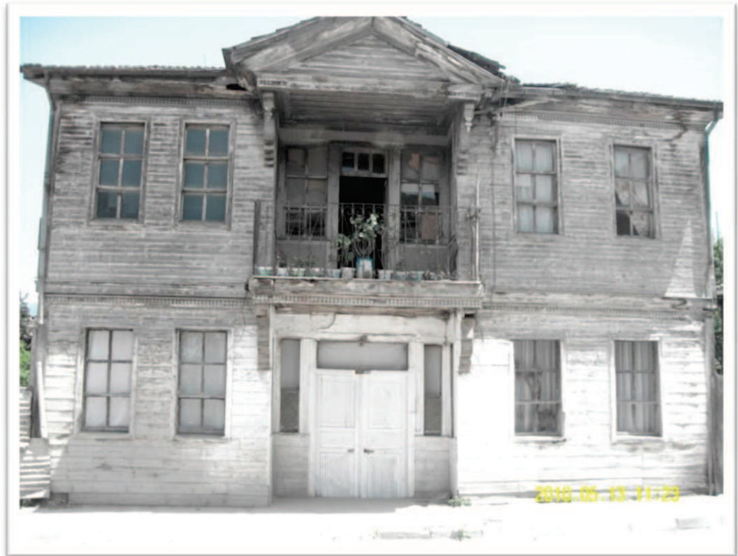
Resim 5. 2. Şaban Çakır evi batı cephesi
