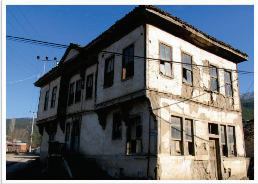
Resim 10. 2. Şakir Oktay evi kuzey ve batı cephesi
