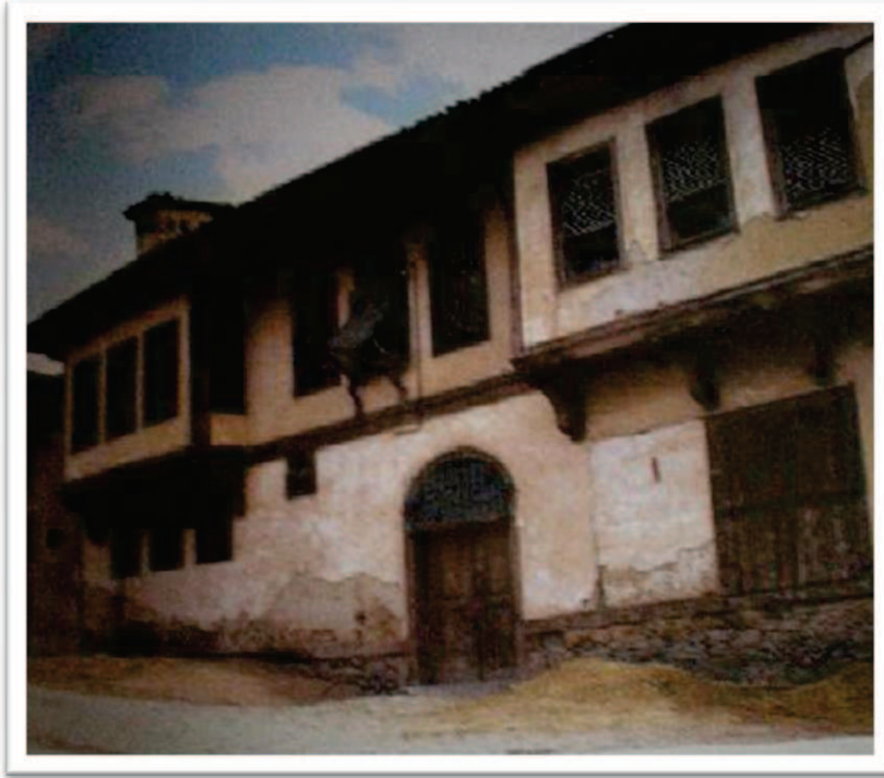
Resim 25. Türk evinde ahşap kafesli pencere örneğı (Bursa)
