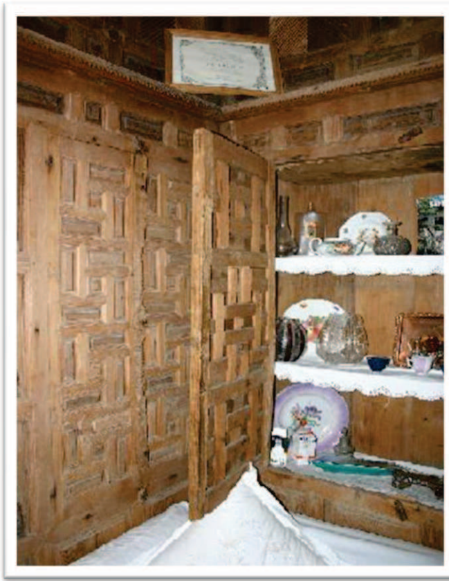
Resim 23. Türk Evinde Dolap ve Yüklük Örneği (Safranbolu )
