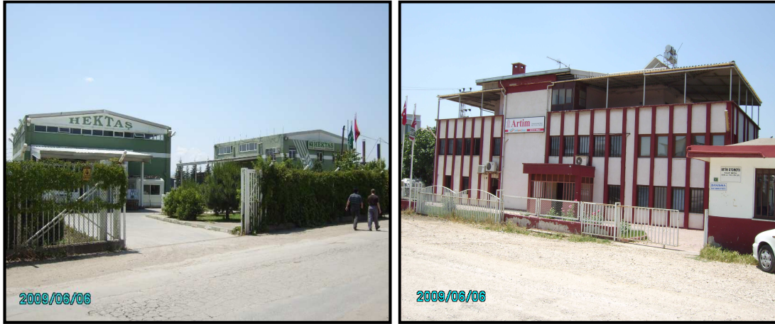
Foto 11. Nilüfer Köy Sınırları İçerisinde Yer Alan Sanayi Tesisleri
