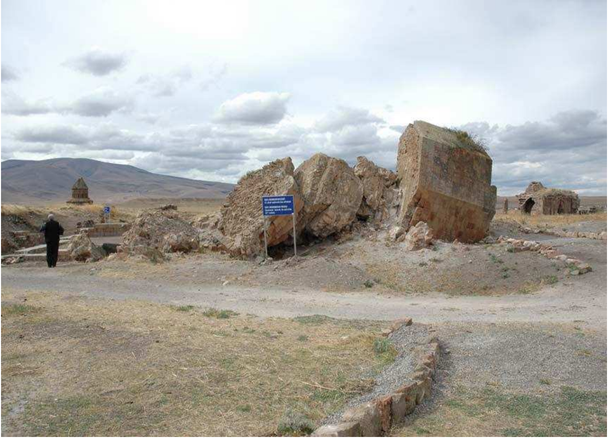
Resim-19. Ebu'l Muammeran Camii Yıkık Minaresi
