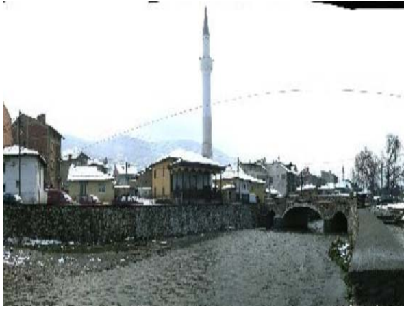
Suzi Çelebi (Tabakhane) Köprüsü Yeni Hali
