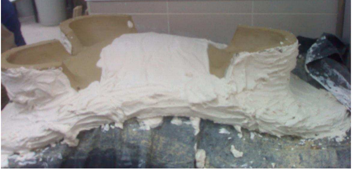
Fotoğraf 138: Lavabo Kalıp Güçlendirme Çalışması
