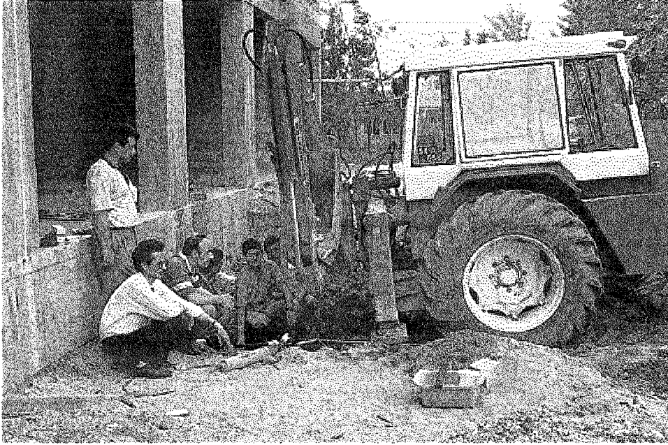
Fotoğraf 7: Mevcut bina ve plaka taşıma deneyinin uygulaması
