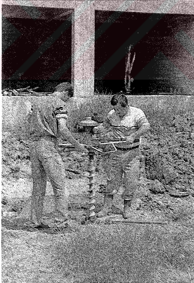
Fotoğraf 2: Zeminden örselenmemiş numune almak için motorlu burgu ile zeminin delinmesi
