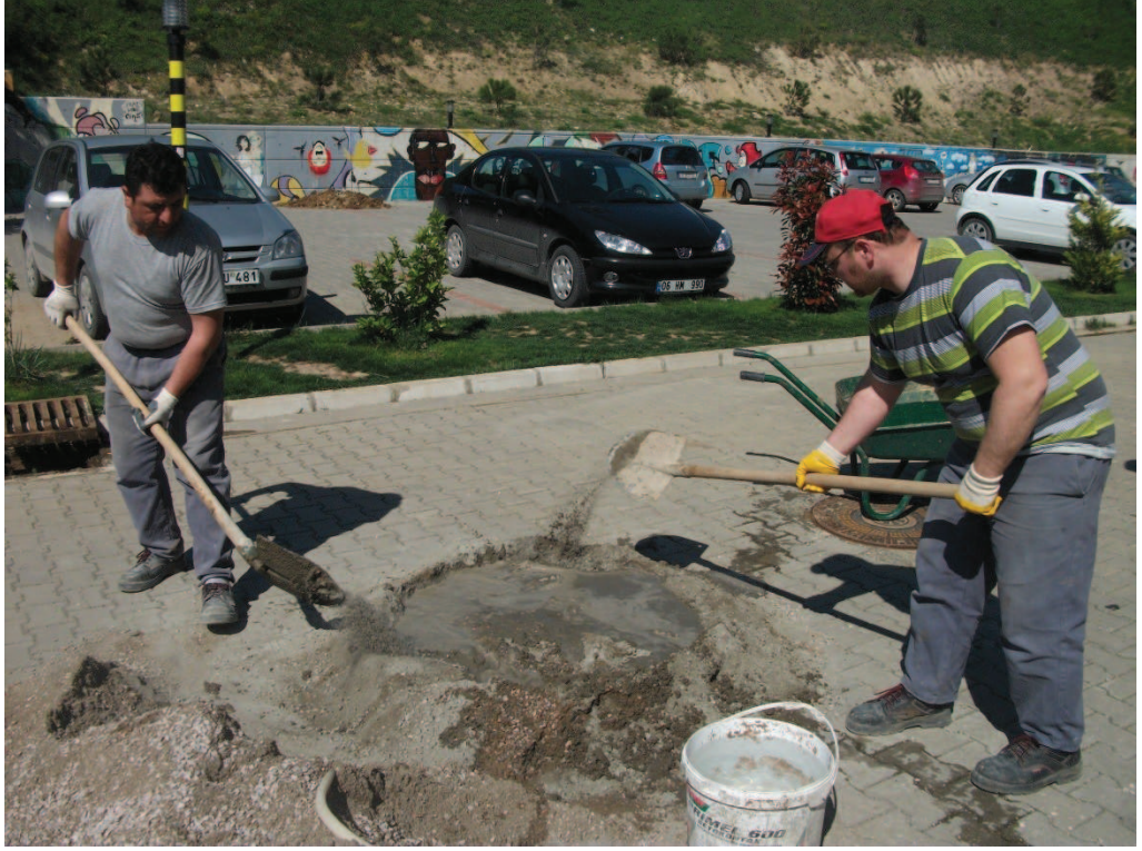
Resim 180: Uygulama Projesi: “Ateşin Çiçekleri”, Beton Atma İşlemleri ve Montaj
