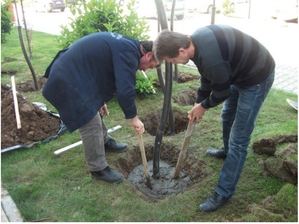
Resim 182: Uygulama Projesi: “Ateşin Çiçekleri”, Beton Atma İşlemleri ve Montaj
