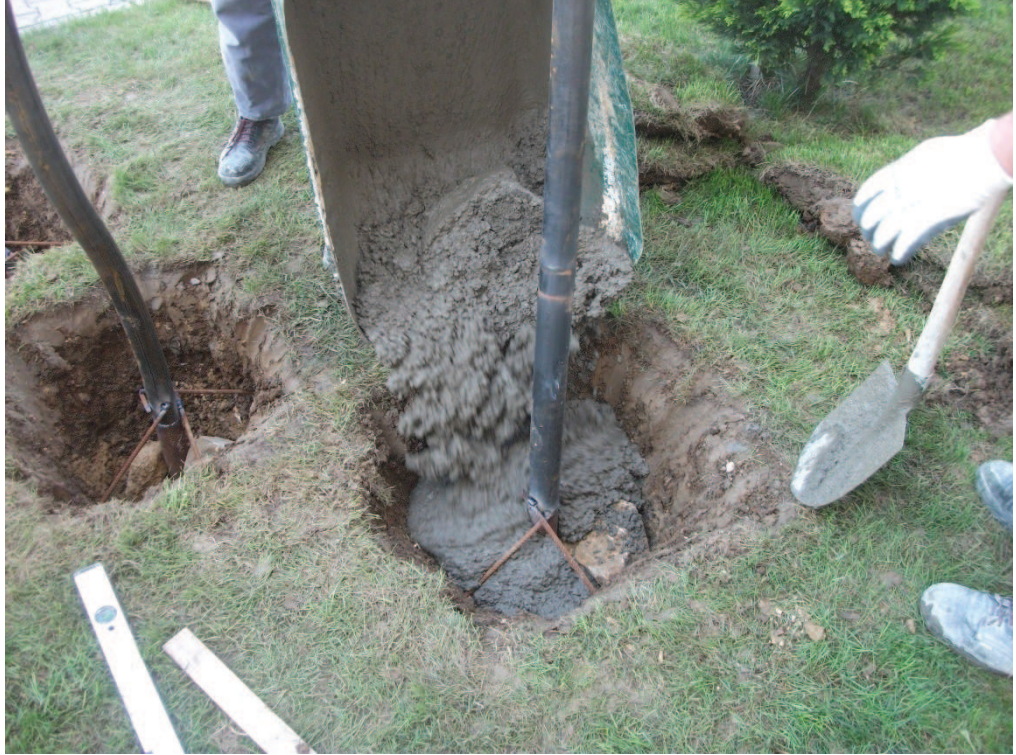
Resim 181: Uygulama Projesi: “Ateşin Çiçekleri”, Beton Atma İşlemleri ve Montaj
