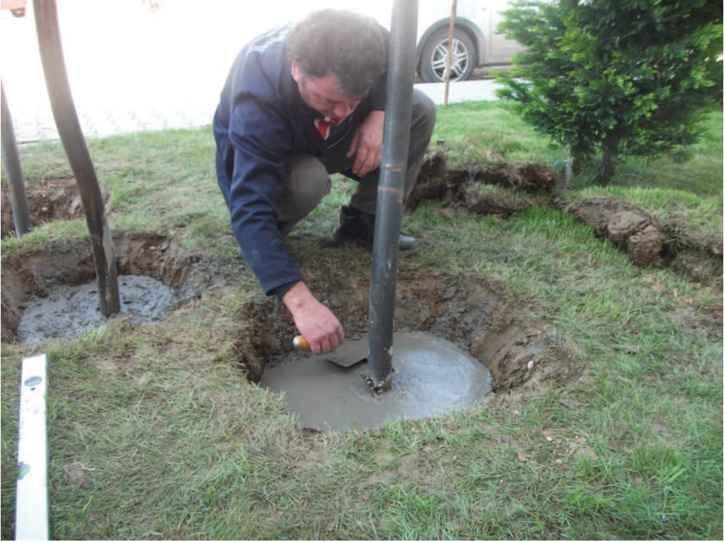
Resim 183: Uygulama Projesi: “Ateşin Çiçekleri”, Beton Atma İşlemleri ve Montaj
