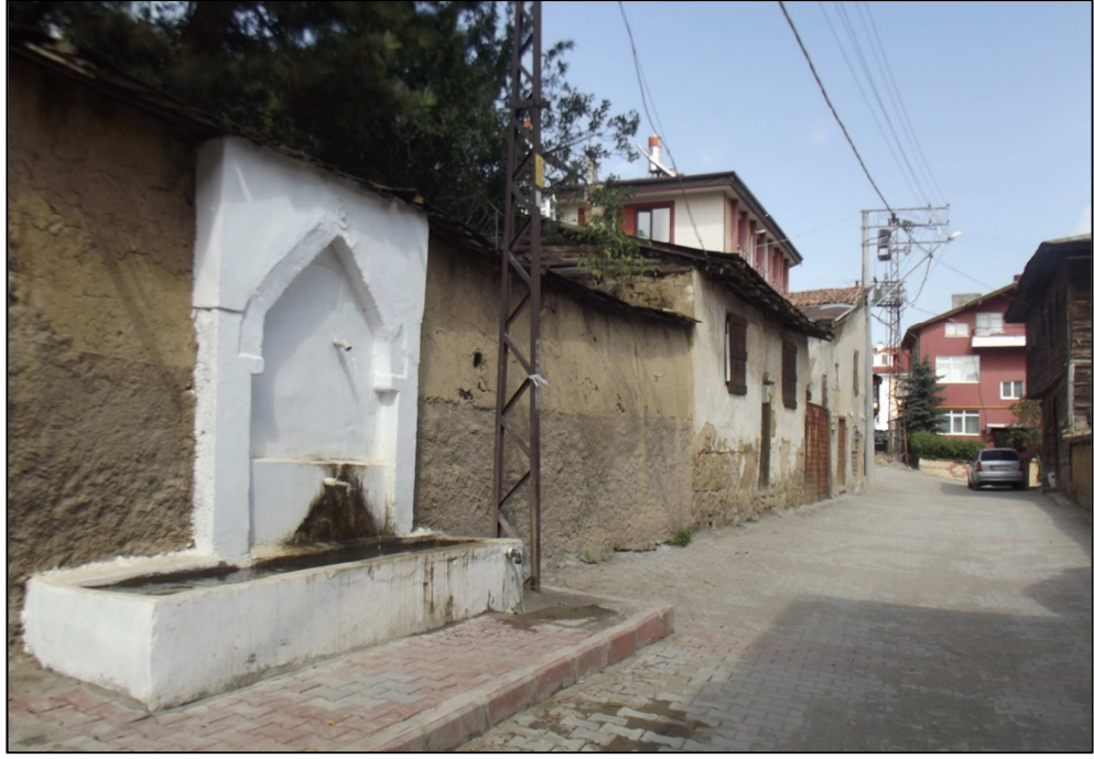
Fotoğraf 55: Kabiller Mahallesi Çaybaşı Sokak II. Çeşmesinin Konumu
