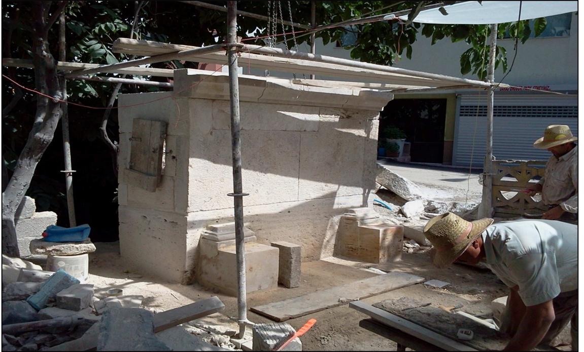
Fotoğraf 7: Karamanlı Cami Çeşmesinde Restorasyon Çalışmaları (Sim Mimarlık)
