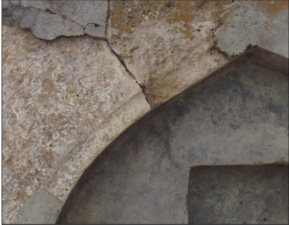
Fotoğraf 113: Hamzabey Köyü Çeşmesinde Yer Alan Sivri Kemerini Belirginleştiren İnce Silmeden Detay
