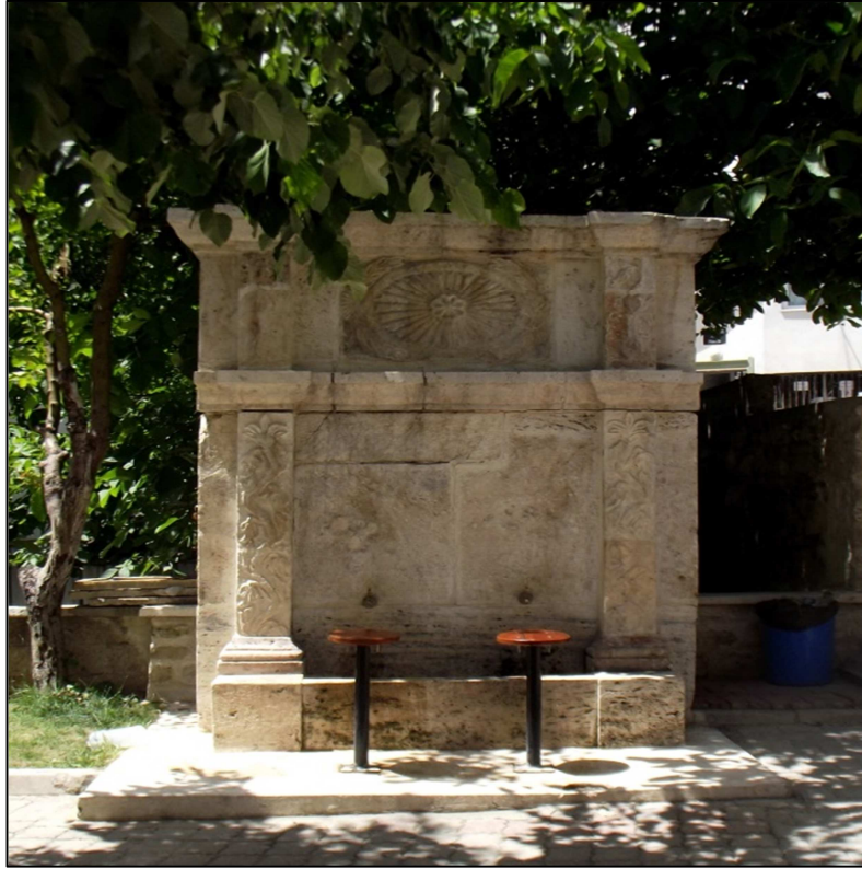
Fotoğraf 5: Karamanlı Cami Çeşmesinin Restorasyon Sonrası Görünümü
