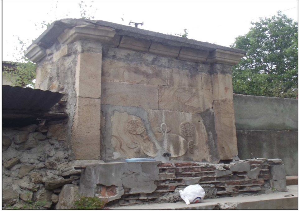
Fotoğraf 50: Kabiller Mahallesi Salih Bey Sokak I. Çeşme (Arka Cephe)
