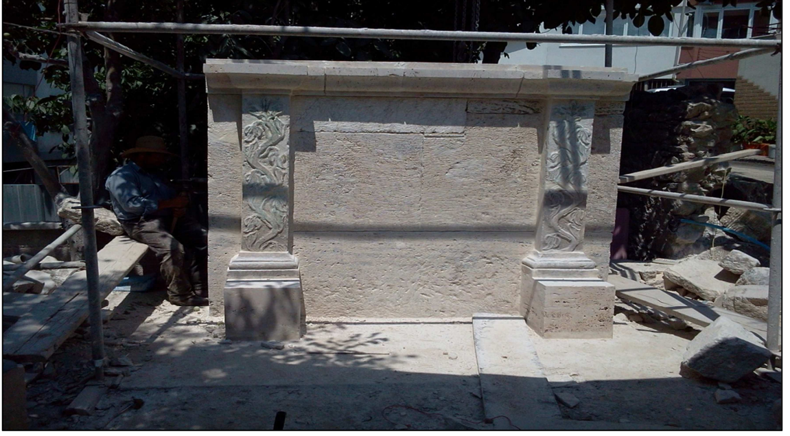
Fotoğraf 8: Karamanlı Cami Çeşmesinde Restorasyon Çalışmaları (Sim Mimarlık)
