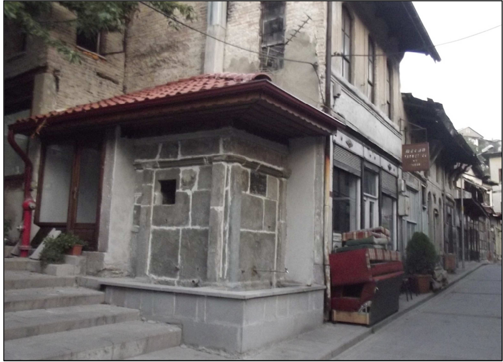
Fotođraf 104: Kaygana Mahallesi Demirciler Caddesi Çeşmesinin Görünümü
