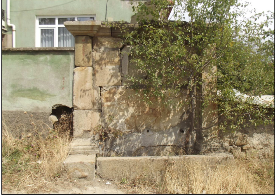
Fotoğraf 49: Kabiller Mahallesi Salih Bey Sokak I. Çeşme (Ön Cephe)
