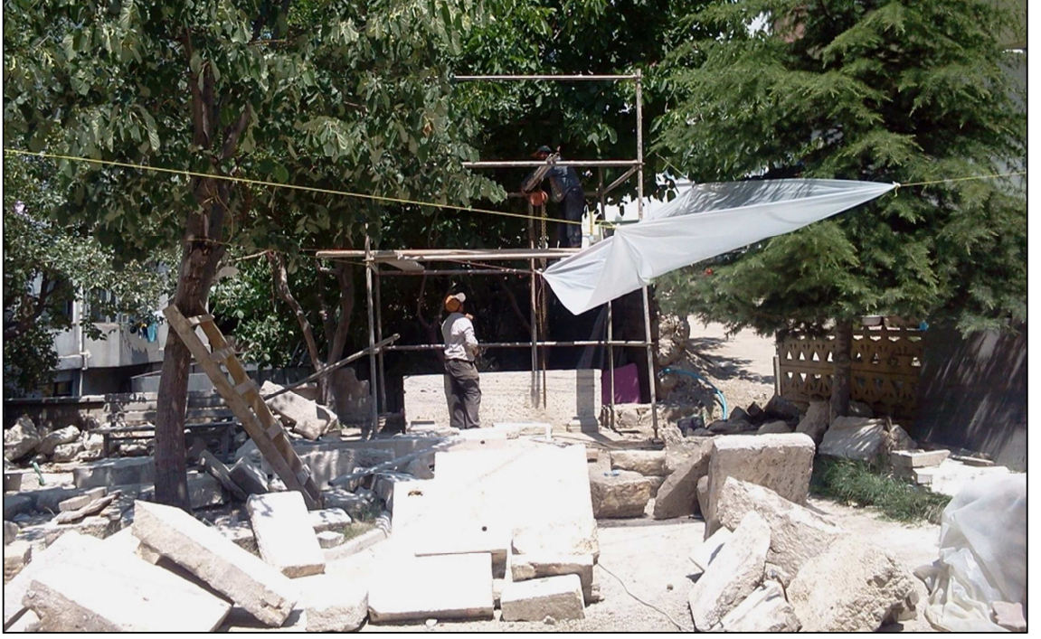
Fotoğraf 6: Karamanlı Cami Çeşmesinde Restorasyon Çalışmaları (Sim Mimarlık)
